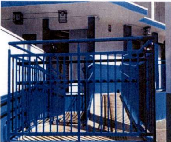
Fotos 04 – Vista frontal da Rampa.
