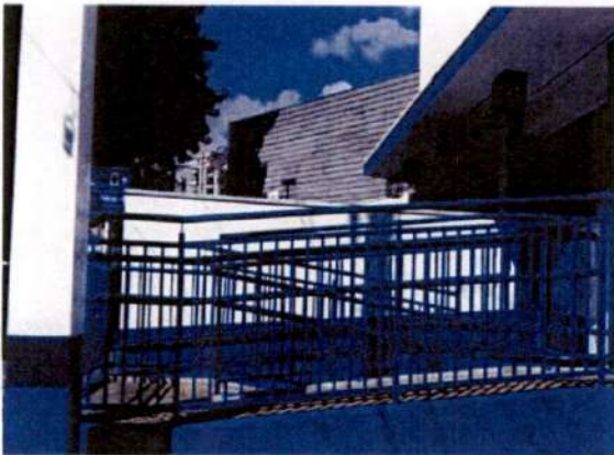
Foto 03 – Área da Rampa a cobrir.
