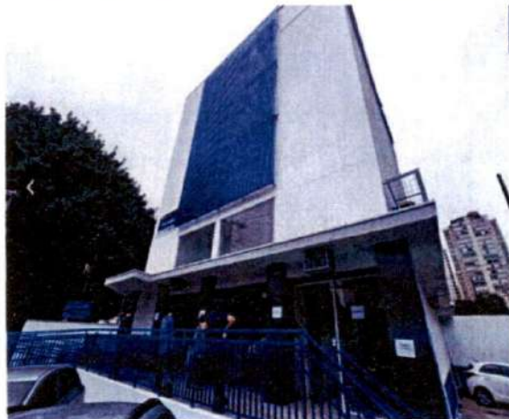
Foto 02 – Local da instalação da cobertura.
