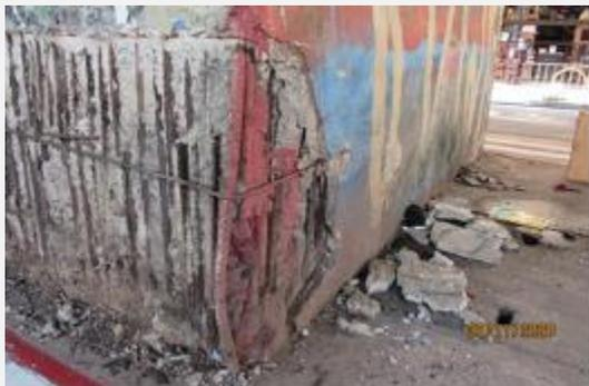
Concreto disgregado com armadura exposta e corroida
