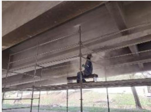
**Recuperação das estruturas de concreto com aplicação de verniz anti-pichação como acabamento**
