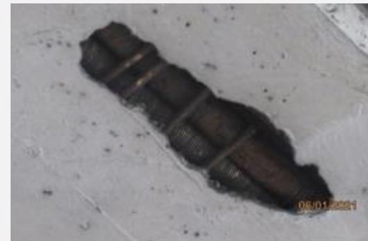
Concreto segregado com protensão exposta
