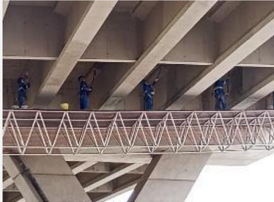
**Recuperação das estruturas de concreto com aplicação de verniz anti-pichação como acabamento e substituição das juntas de dilatação**
