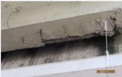
Concreto disgregado com armadura exposta e corroída
