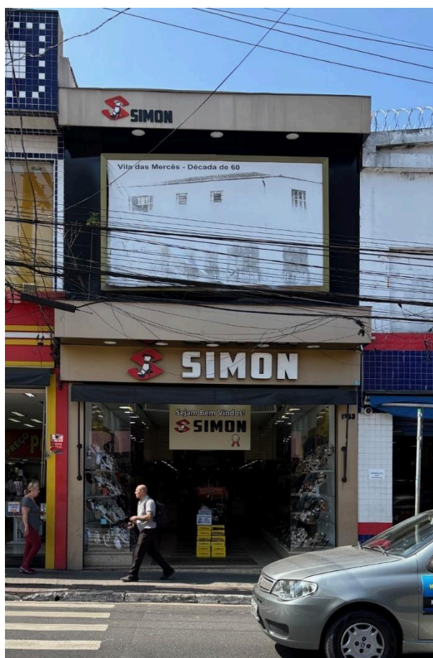
A fachada da Simon Calçados exhibe fotografia do primeiro imóvel em que a loja funcionou, na época de sua inauguração, em 1961, numa demonstração de valorização de sua história. Foto: Fatima Antunes, DPH/SMC/PMSP, 28 ago. 2025.
