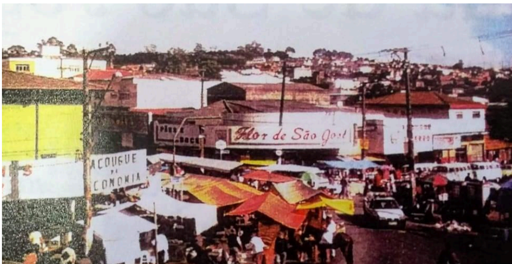
Fotografia sem data. À esquerda tem-se a Casa de Carnes São José e à direita a padaria. 133
