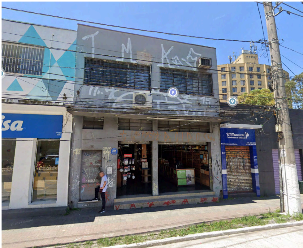
Fachada da Elétrica João Theodoro. Fonte: Google Maps. Acesso em: 04 set. 2025
