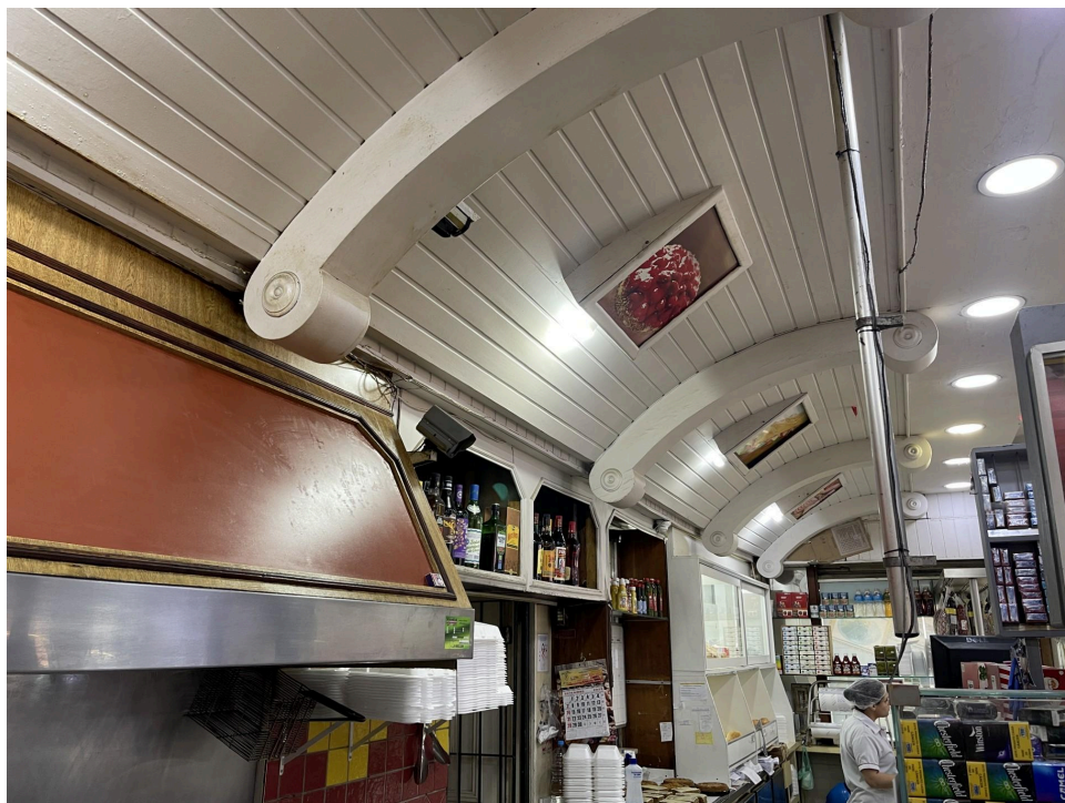
Revestimento de madeira do encontro entre laje e parede, aos fundos da padaria. Autoria própria, 2025.
