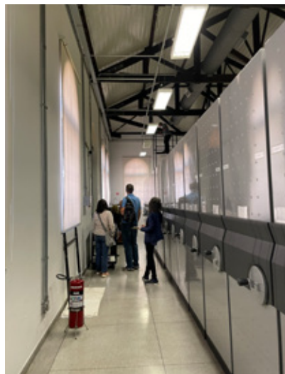
ANX – teste alarme de incêndio.
