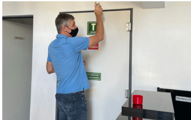
TRM – testes de alarme, bomba e mangueira de incêndio.
