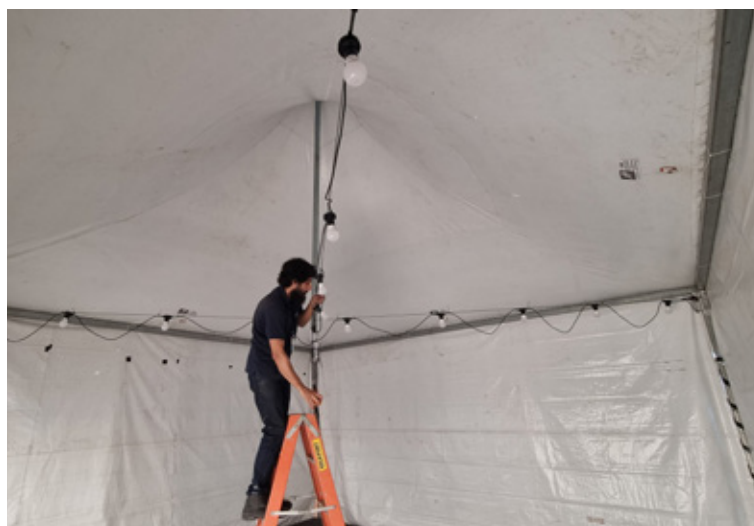
Montagem da iluminação em uma tenda externa para o Festival Arquivo Aberto.
