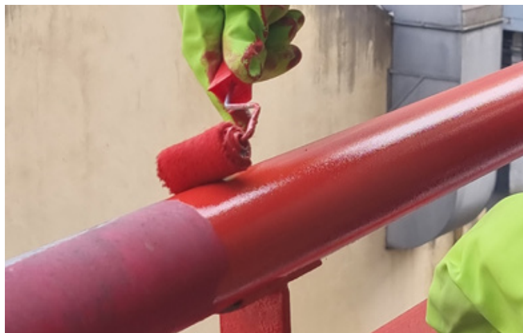
Pintura dos guarda-corpos da Torre da Memória.
