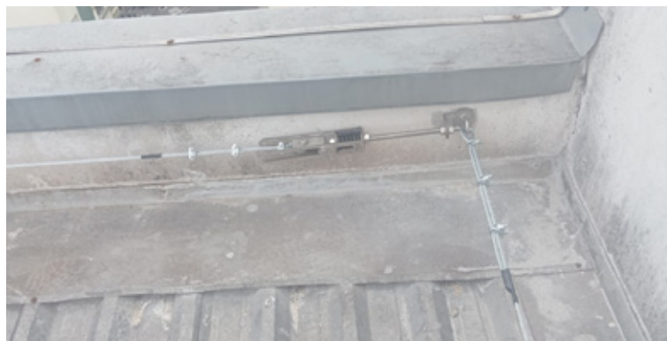
Instalação da linha de vida.
