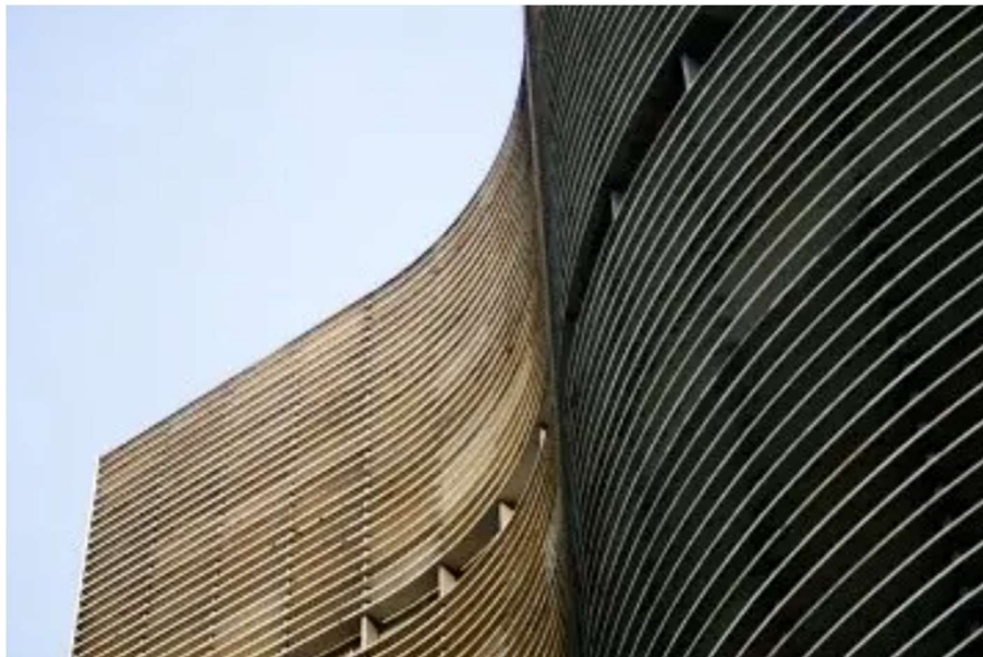
Fig. 6. Brises soleil utilizados também como elementos decorativos, acentuam as curvas do edifício e revelam a sua organicidade, s.d. (Fonte: Veja São Paulo. Foto: André Deak. Acesso: fev. 2026).
