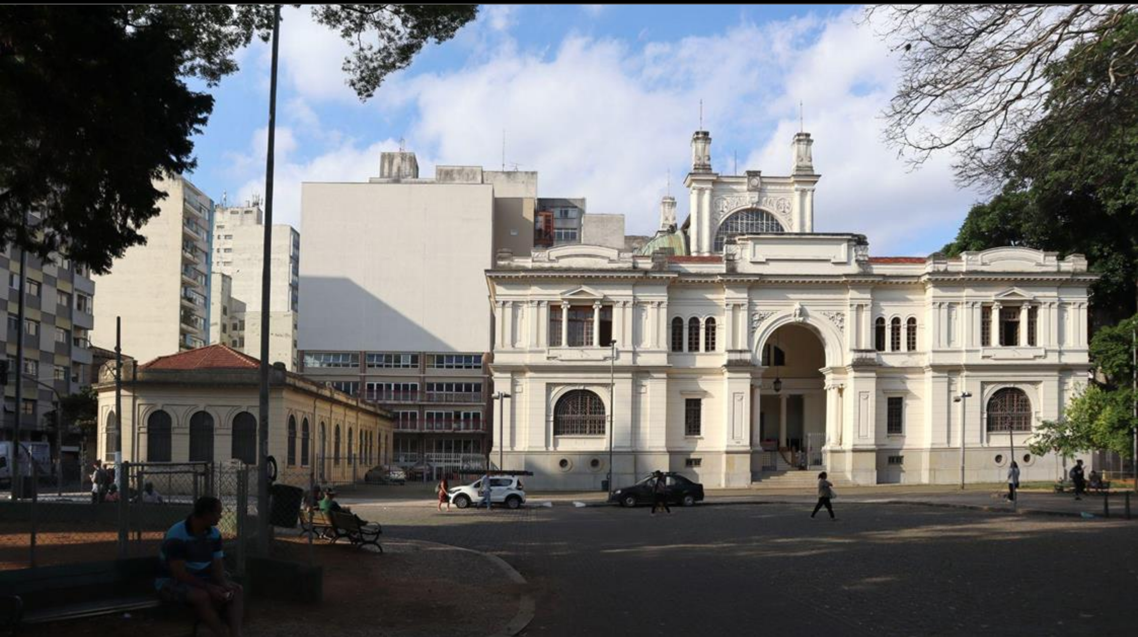
Conjunto de edifícios que abriga o acervo: Edifício Ramos de Azevedo (ERA, à direita), o Edifício Anexo (ANX, à esquerda) e a Torre da Memória (TRM, ao fundo).
