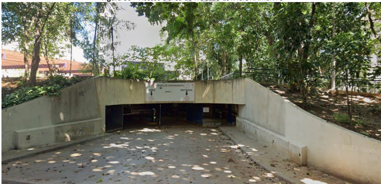
Figura 30 – Acesso à área do NÚCLEO ESTACIONAMENTO
