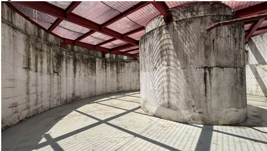
Figura 41 – Vista interna da abertura de ventilação do estacionamento subterrâneo
