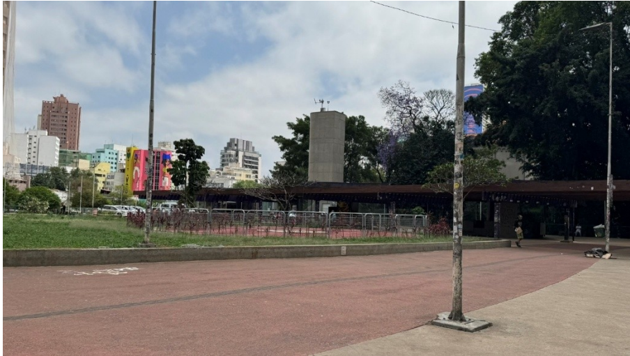
Figura 40 – Vista externa da abertura de ventilação do estacionamento subterrâneo cercada por guarda-corpo
