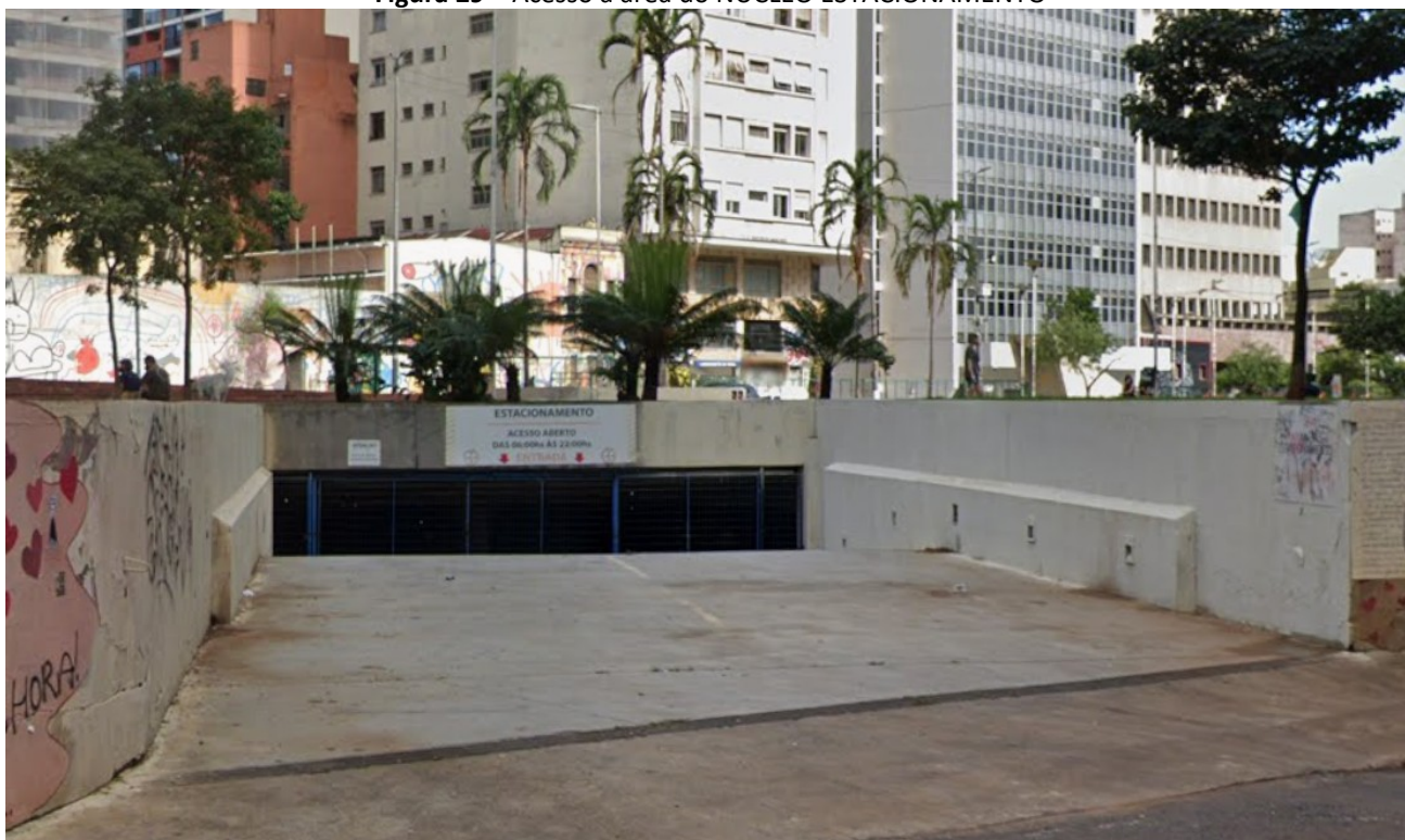
Figura 29 – Acesso à área do NÚCLEO ESTACIONAMENTO
