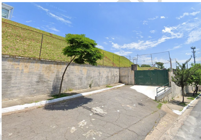
Figura 11 - Acesso de veículos à ÁREA DA CONCESSÃO pela Avenida Jacinto Júlio (portão existente e em uso)
