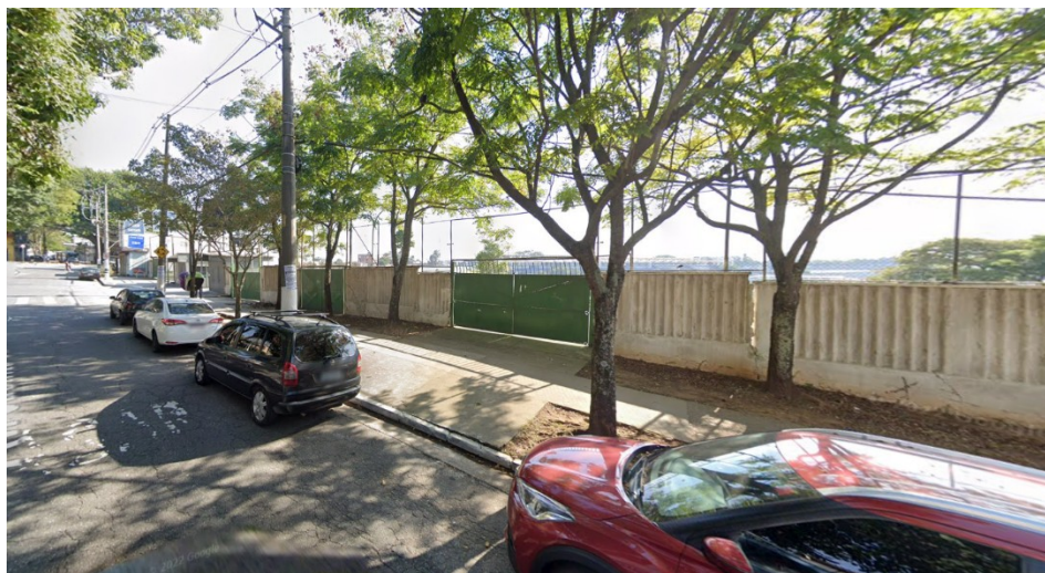
Figura 10 - Acesso de pedestres à ÁREA DA CONCESSÃO pela Avenida Jacinto Júlio. (portão existente mas sem uso)
