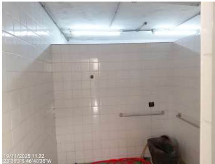
Vista interna – Edificação principal
