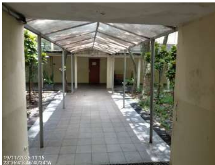
Vista interna – Edificação principal
