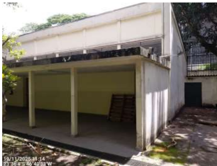
Vista interna – Edificação principal
