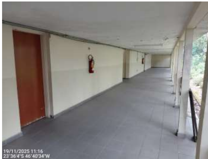
Vista interna – Edificação principal
