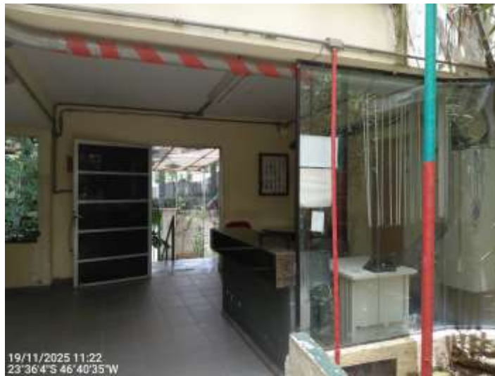
Vista interna – Edificação principal
