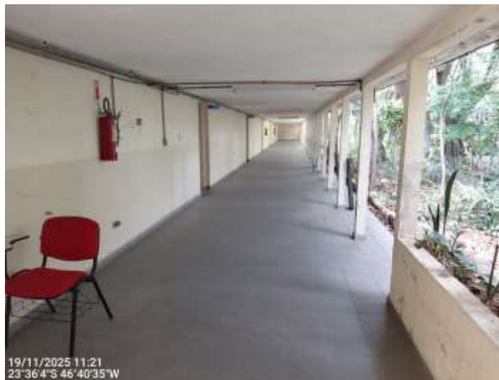
Vista interna – Edificação principal
