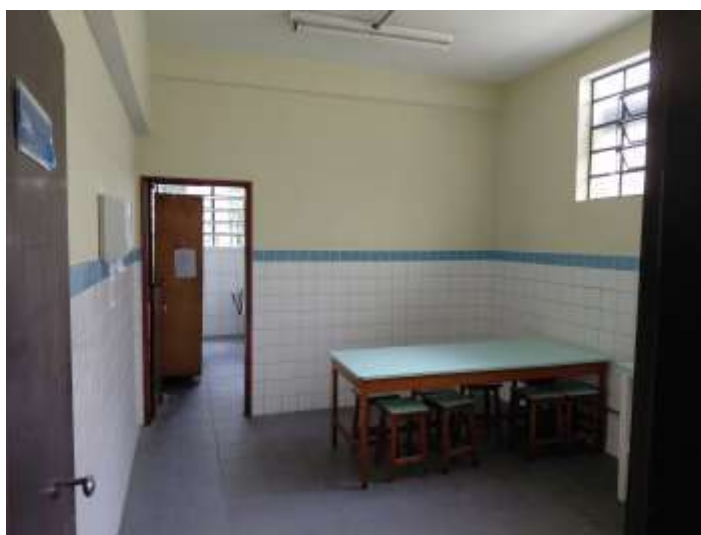
Vista interna – Edificação principal
