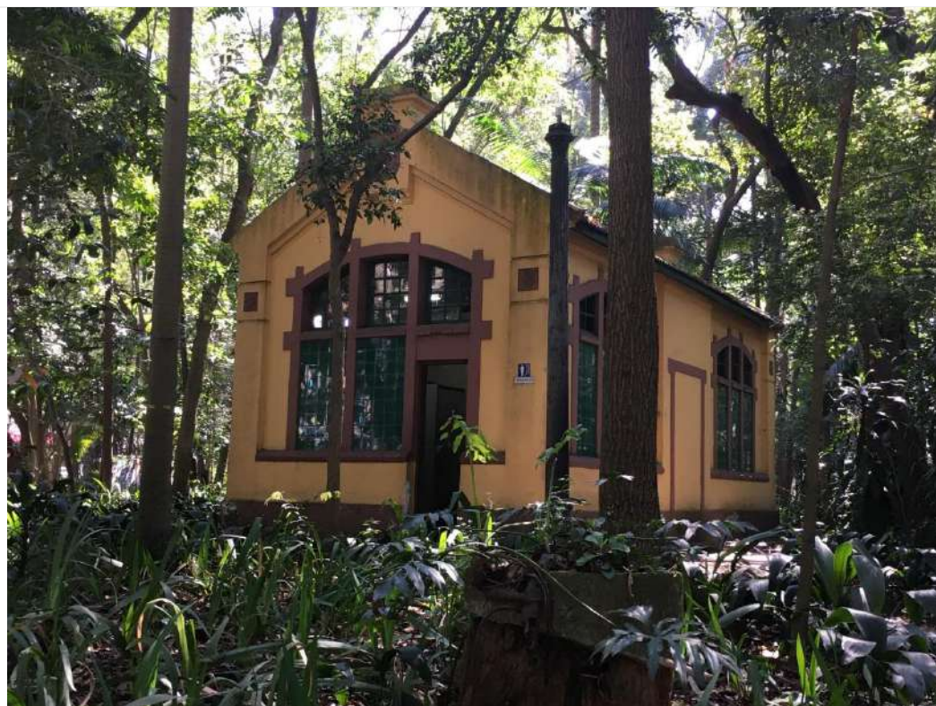
Edificação dos sanitários do Parque Trianon. Fonte: PMSP (2019).
