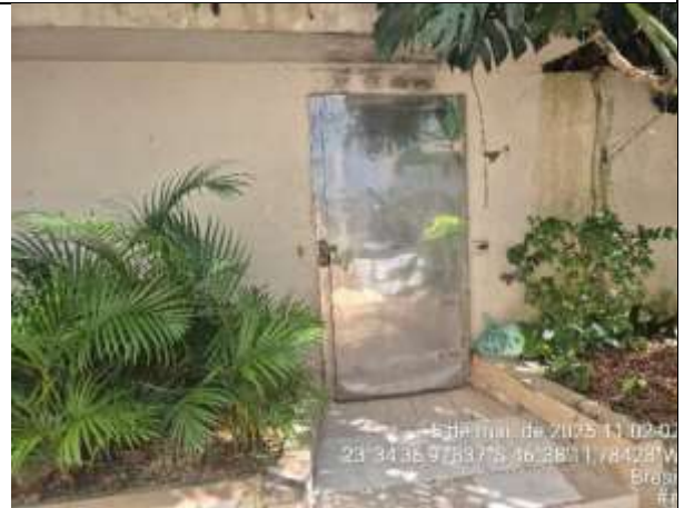
Ocupação de Terceiros na Avenida Armando Ferrentini
