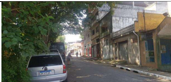
Foto 01: Descrever na legenda o que é visto na imagem juntamente com o nome do logradouro. Focar em destacar a infraestrutura do núcleo e problemas identificados na vistoria.
