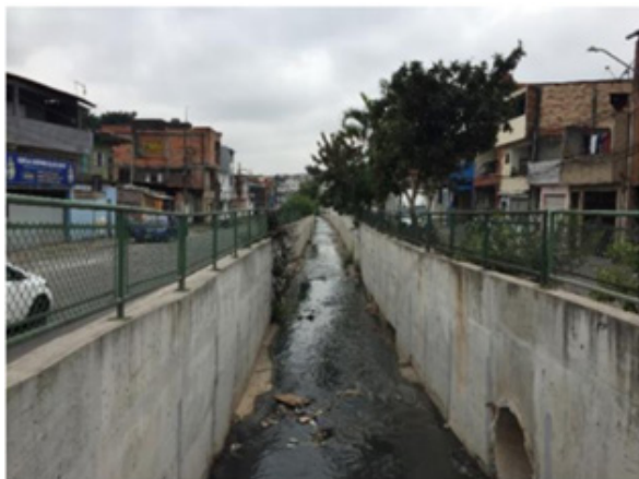
Foto 23 – Seção do córrego do Engenho, canalizado em concreto e em seção aberta
