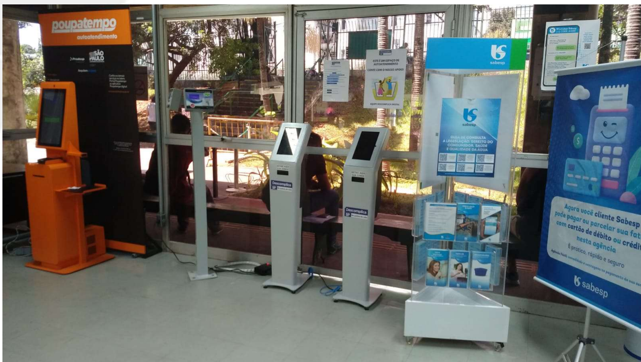
Fios no chão sem proteção
