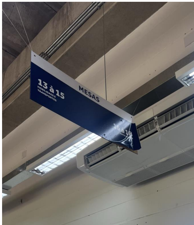
Placa aérea danificada.
