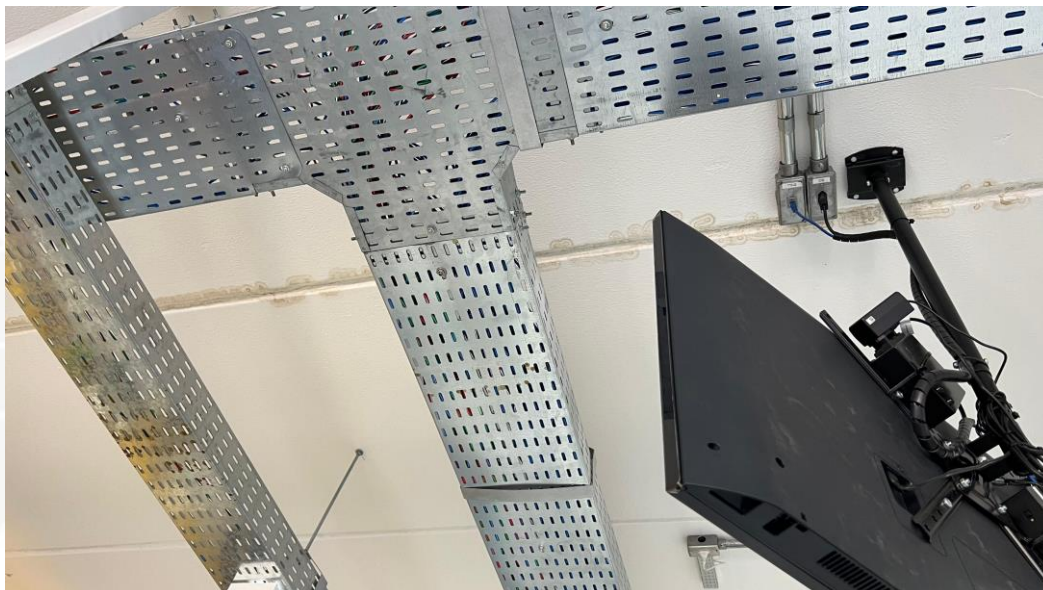
Infiltração no teto.
