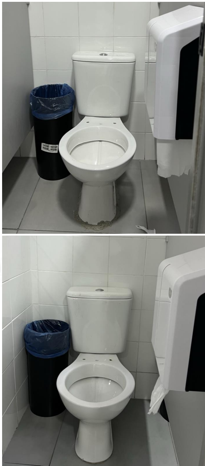
Vasos sem tampa e assento no sanitário feminino.
