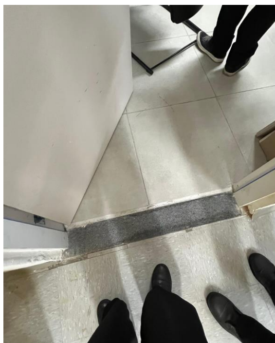
Piso do CPD foi instalado pela subprefeitura.
