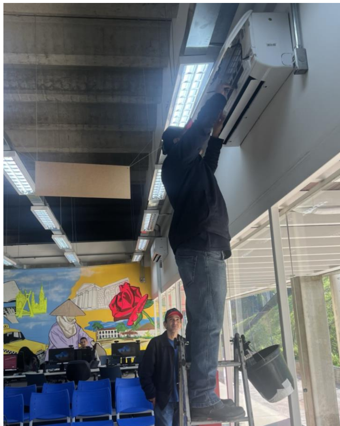
Manutenção preventiva dos ar-condicionados.
