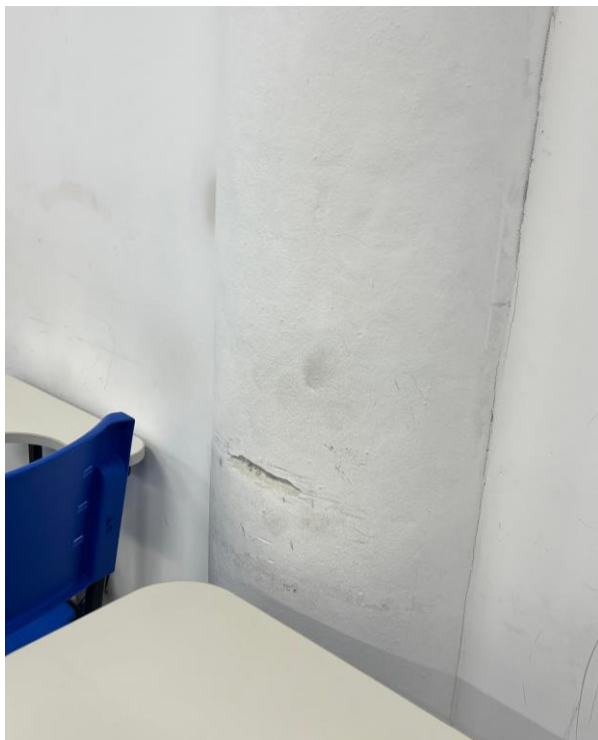
Coluna com pedaço quebrado no miniauditório.
