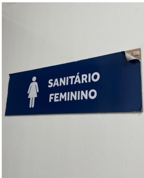
Placa de porta danificada.
