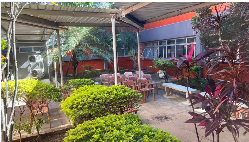
A unidade não possui área de convivência. Subprefeito implantou bancos de concreto no pátio para que fossem usados pelos funcionários do Descomplica.
