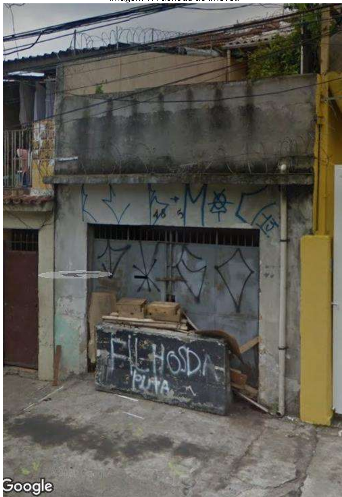
Imagem 1: Fachada do Imóvel.
