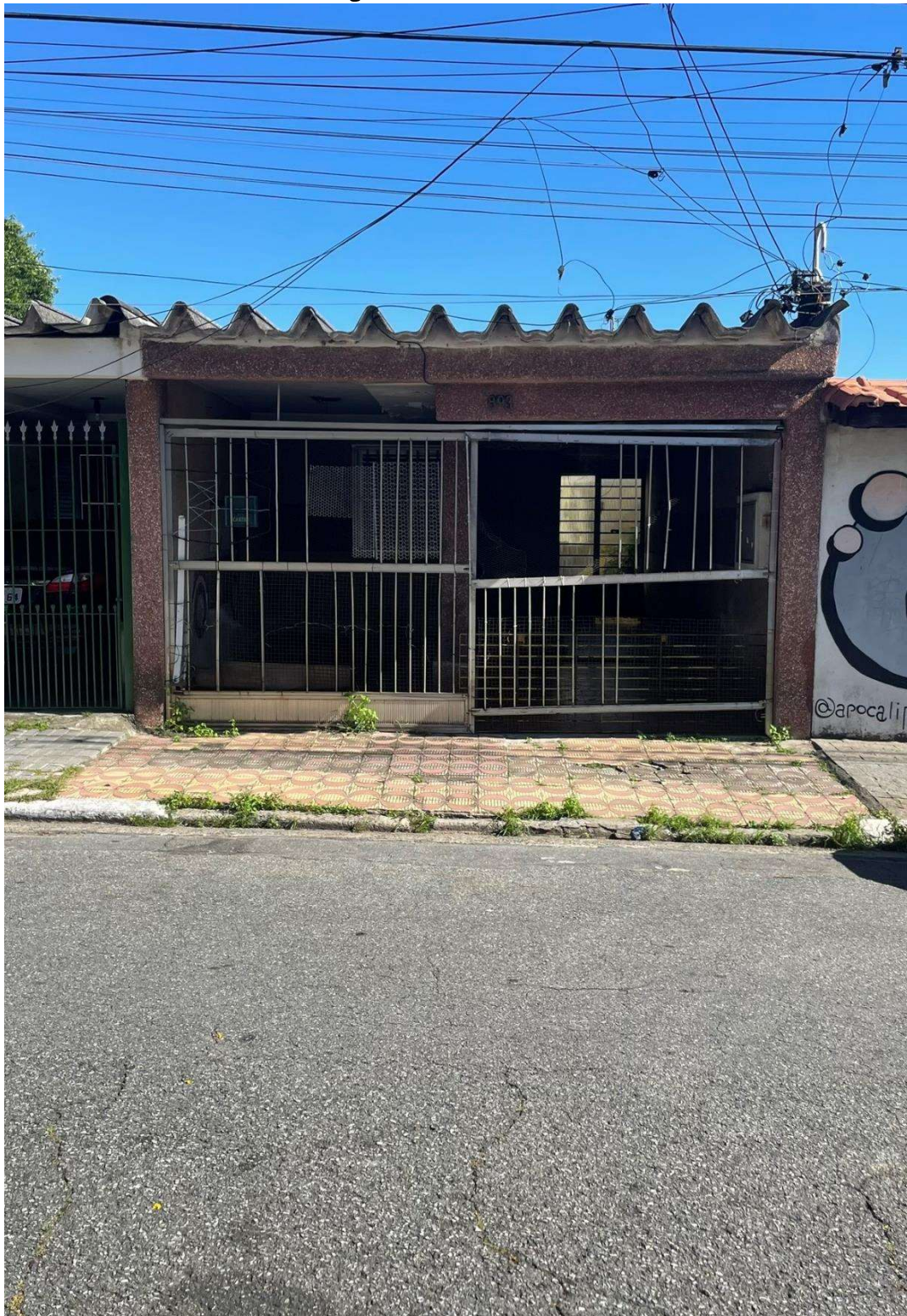
Imagem 1: Fachada do Imóvel.
