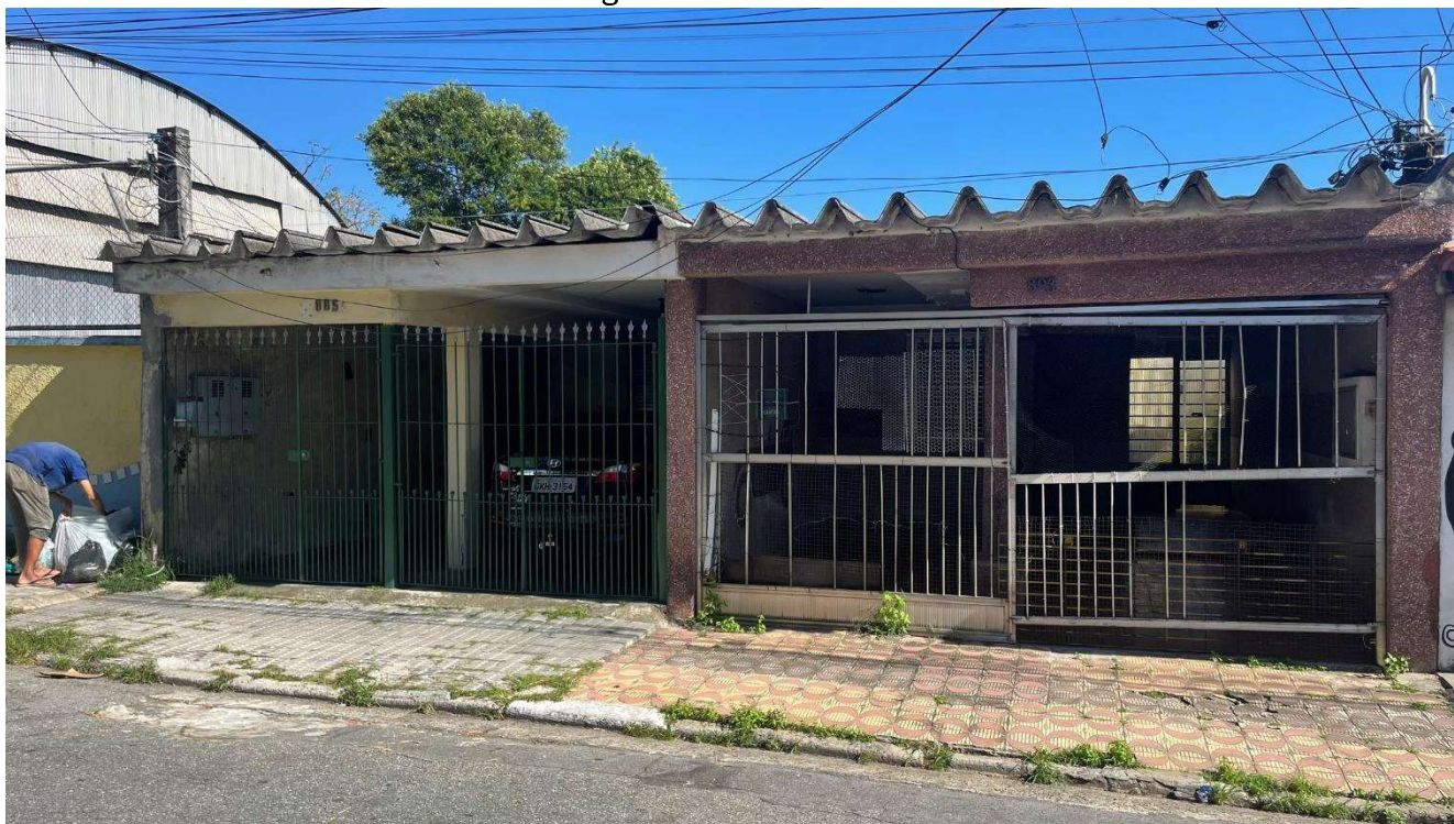
Imagem 2: Fachada do Imóvel.
