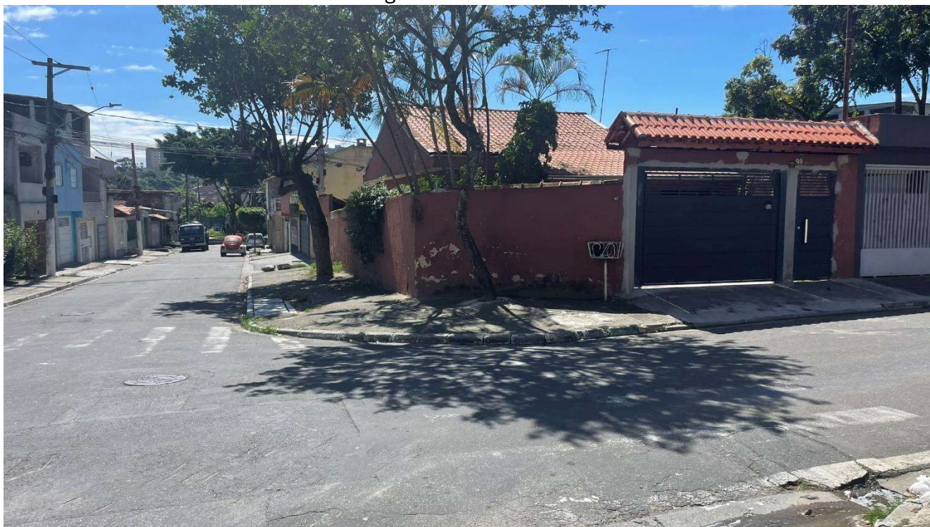
Imagem 2: Fachada do Imóvel.
