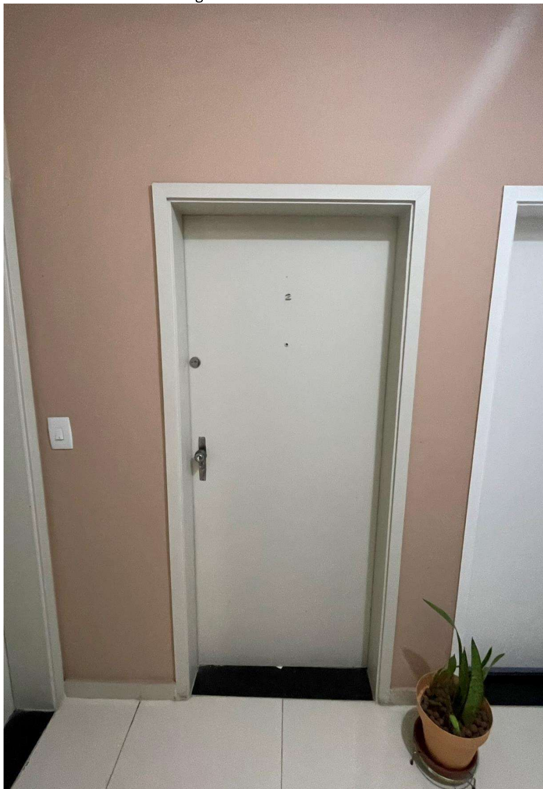
Imagem 1: Fachada do Imóvel.
