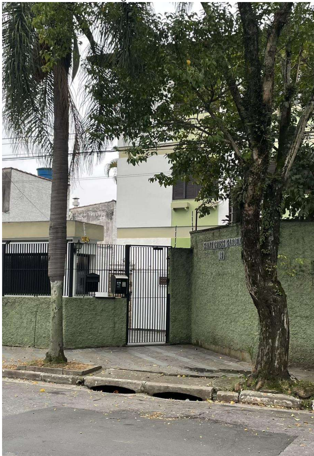
Imagem 1: Fachada do Imóvel.
