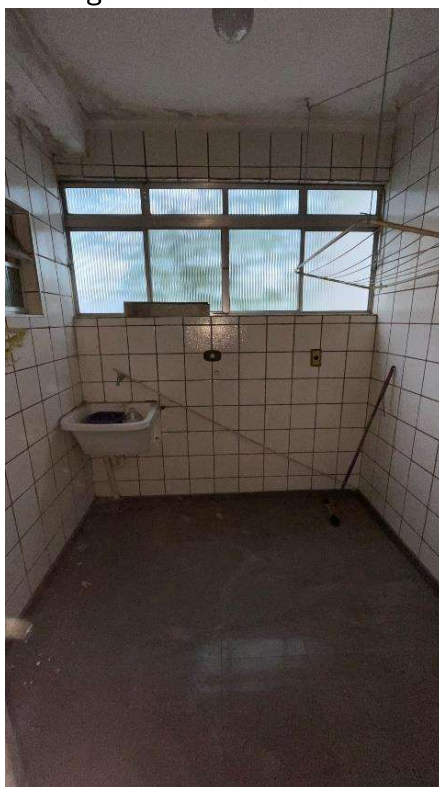
Imagem 5: Interior 6º Andar.
