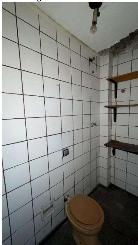
Imagem 7: Interior 6º Andar.
