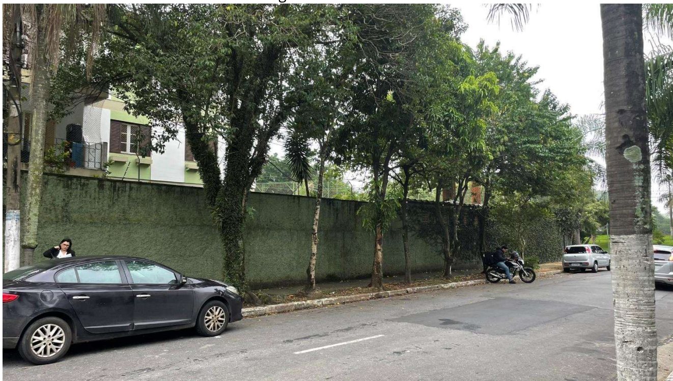
Imagem 2: Fachada do Imóvel.
