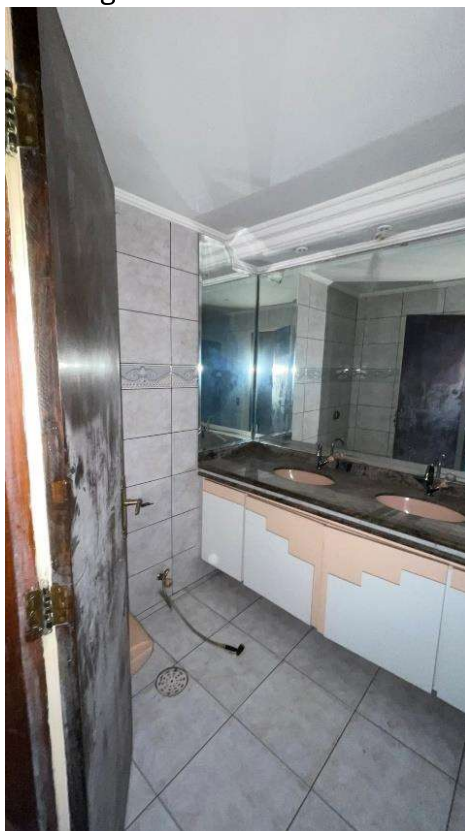
Imagem 14: Interior 8º Andar.
