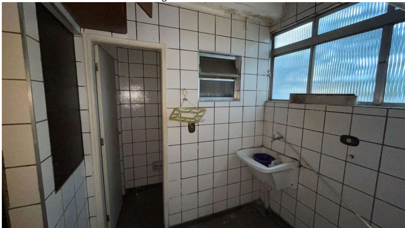
Imagem 6: Interior 6º Andar.
