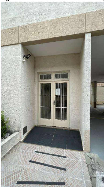
Imagem 20: 3º Andar – Andar Garagem.
