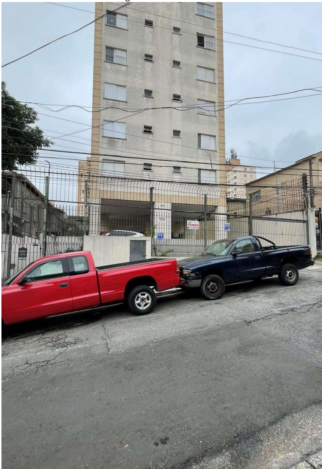
Imagem 1: Fachada do Imóvel.
