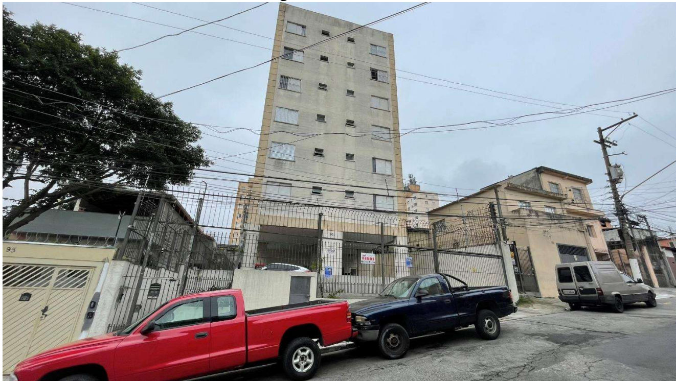
Imagem 2: Fachada do Imóvel.
