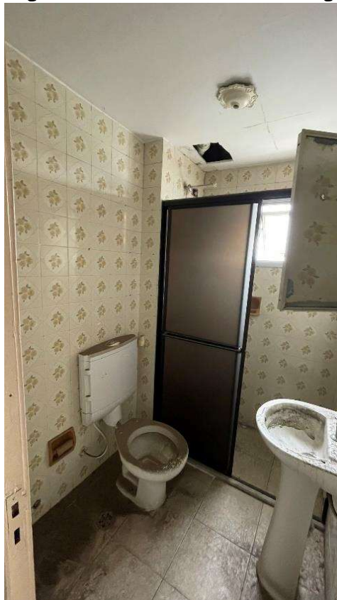
Imagem 16: 3º Andar – Andar Garagem.
