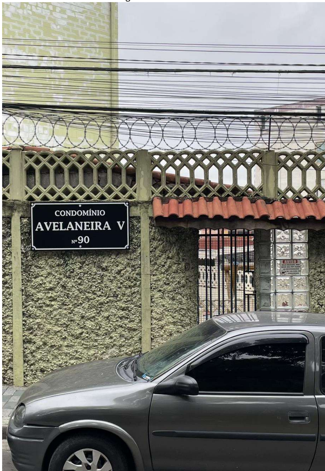
Imagem 1: Fachada do Imóvel.
