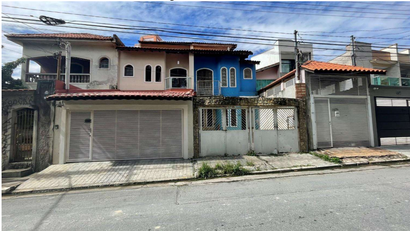
Imagem 2: Fachada do Imóvel.
