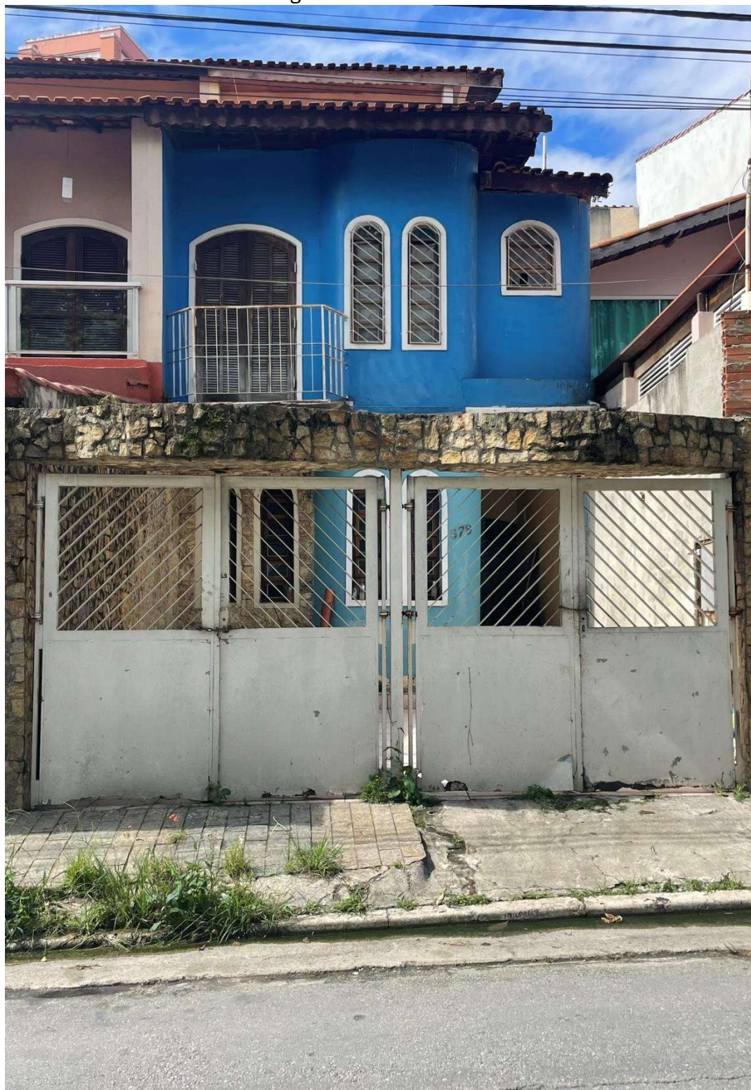
Imagem 1: Fachada do Imóvel.
