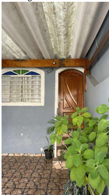
Imagem 2: Fachada do Imóvel.
