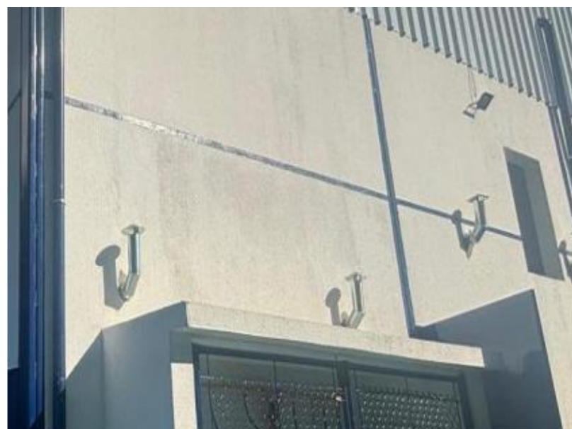
INTALAÇÃO AQUECEDORES A GÁS - CHAMINÉS
