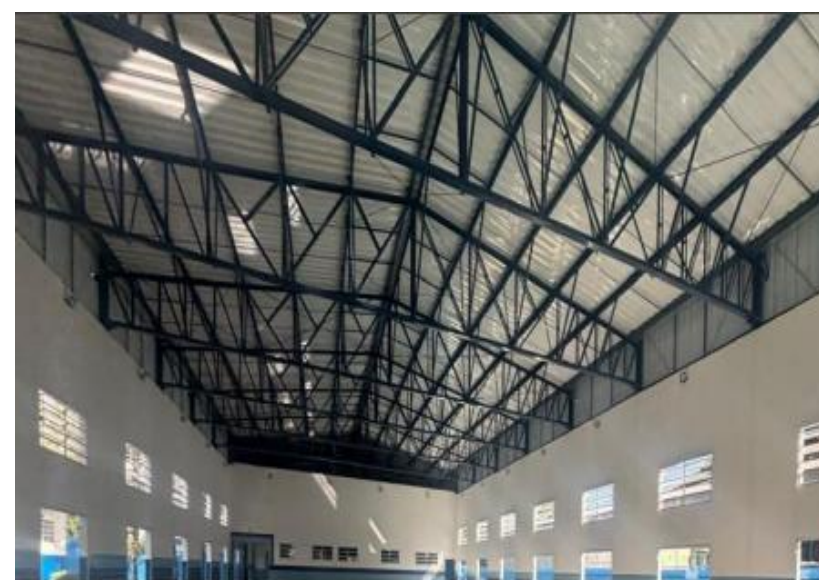
PINTURA ESTRUTURA METÁLICA PISCINA
