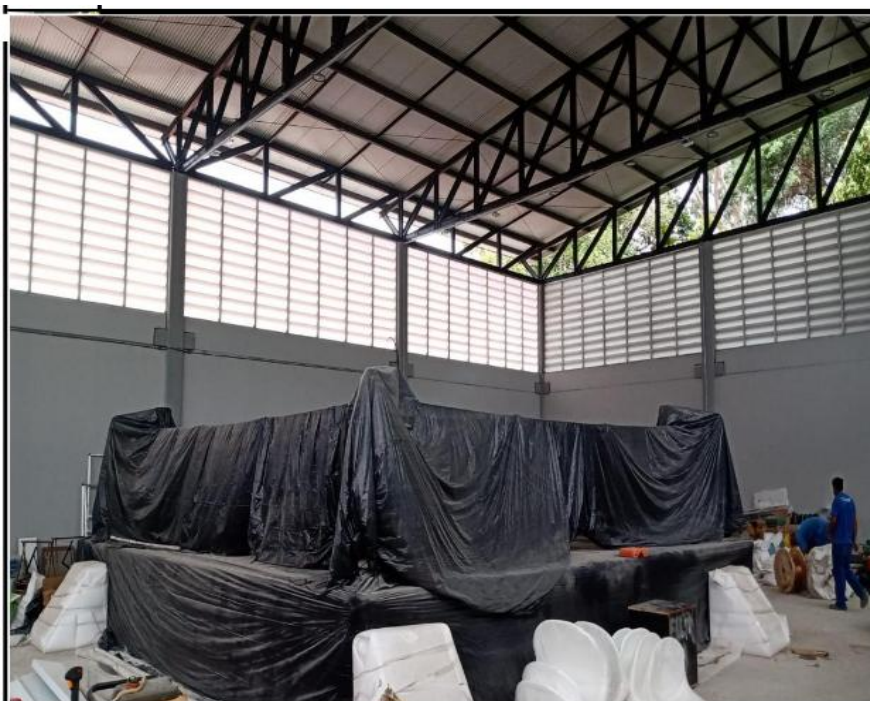
RINGUE INSTALADO NO GINASIO DE LUTAS (COBERTO POR LONA PARA CONSERVAÇÃO ATÉ A INAUGURAÇÃO).
