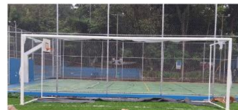
FOTO 10: INSTALAÇÃO DE TRAVE
