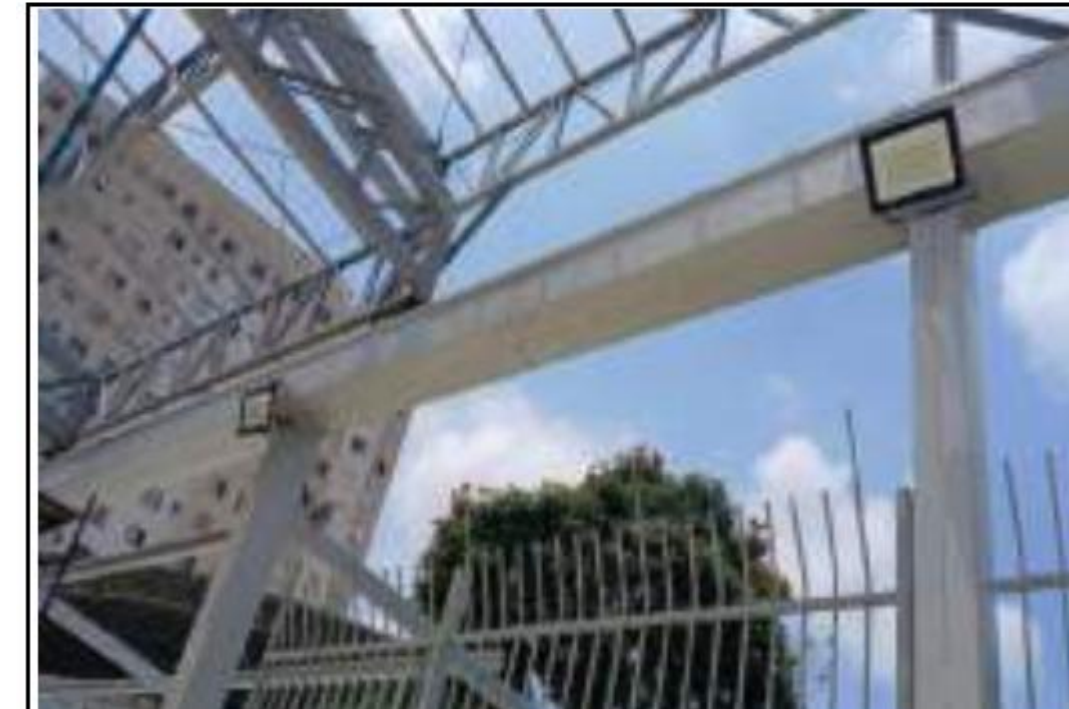
INSTALAÇÃO ELÉTRICA ILUMINAÇÃO
