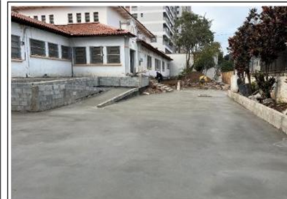
IMPLATAÇÃO - CONCRETO - ESPAÇO ATI / CALÇADA
