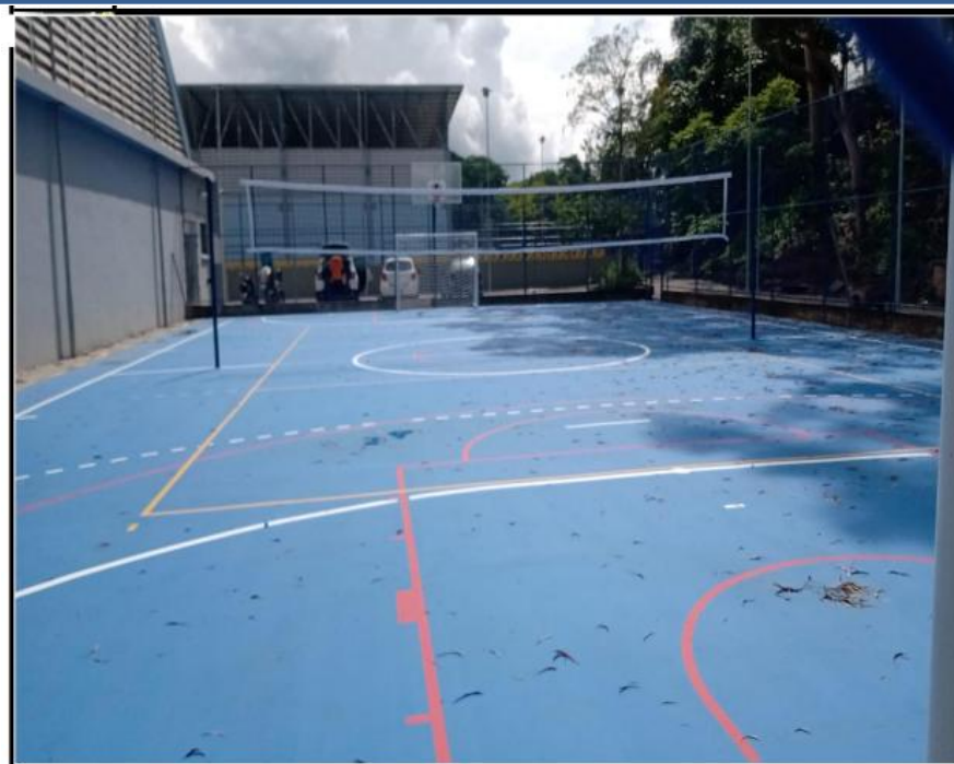
QUADRA POLIESPORTIVA EXTERNA COM DEMARCAÇÃO E ACESSÓRIOS INSTALADOS.
