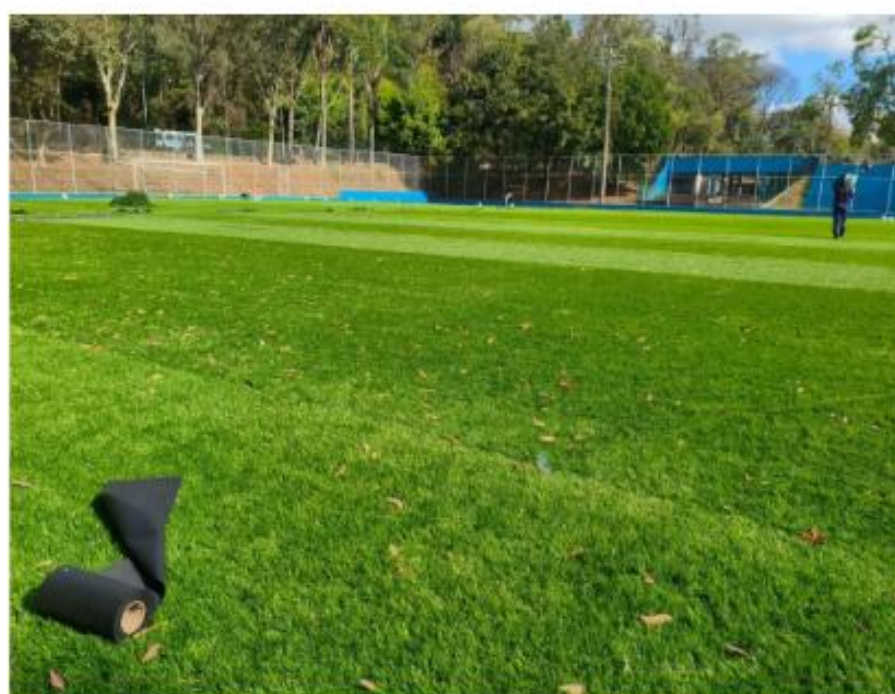
FOTO 4: INSTALAÇÃO DE GRAMA SINTÉTICA
