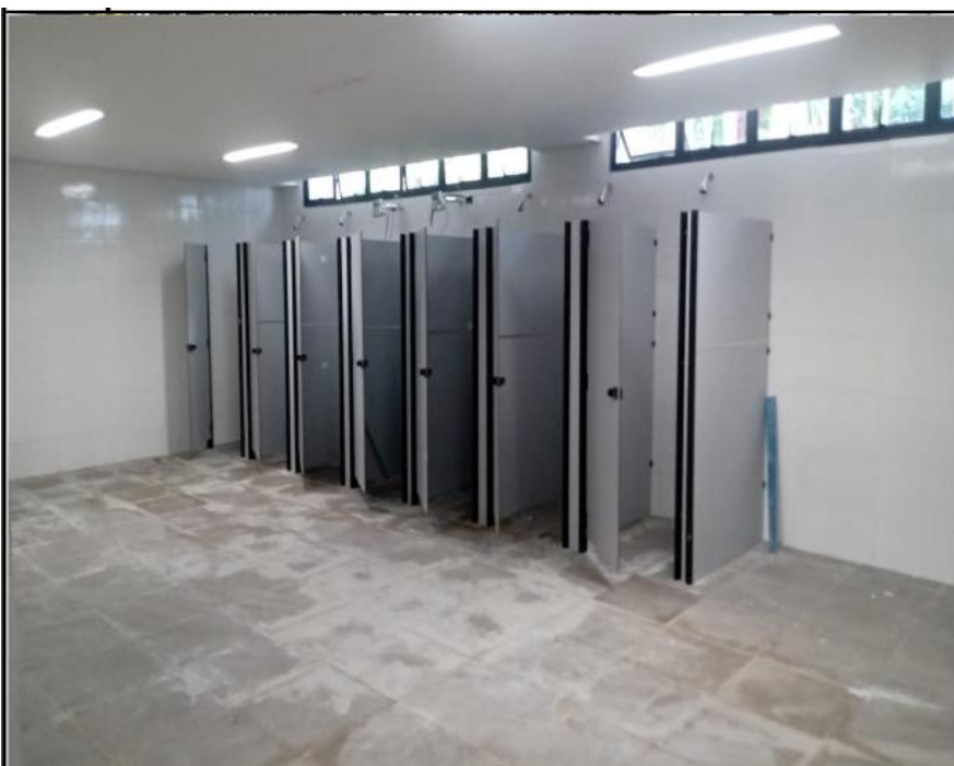
INSTALAÇÃO DE DIVISÓRIAS SANITÁRIAS.
