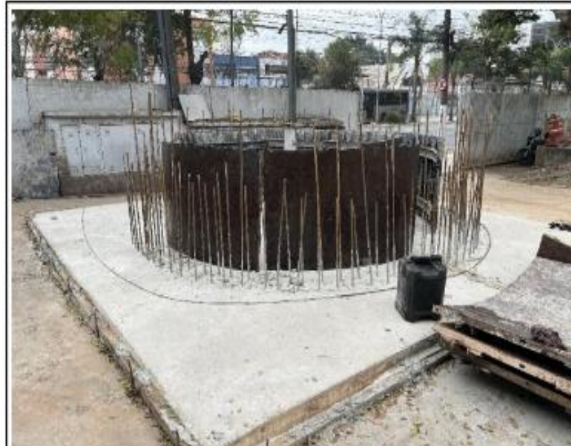
ADM - FUNDAÇÃO RESERVATÓRIO
