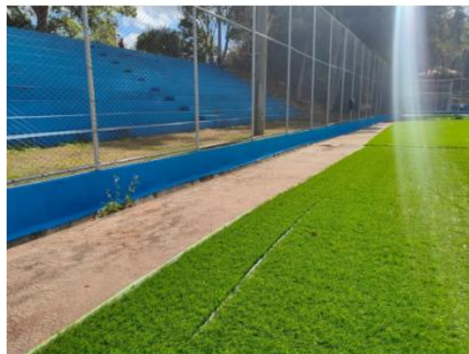
FOTO 6: PINTURA EM LÁTEX
