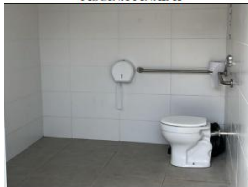
FOTO 88 – VESTIÁRIO PCD I
