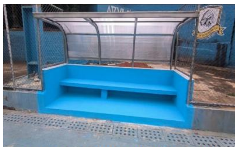
FOTO 62 - BANCO DE RESERVAS VIII (PINTURA, SERRALHERIA, COBERTURA E PISO)
