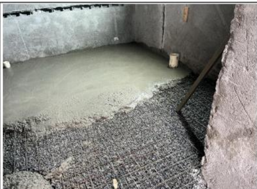
ADM - PISO DE CONCRETO - SALAS INTERNAS
