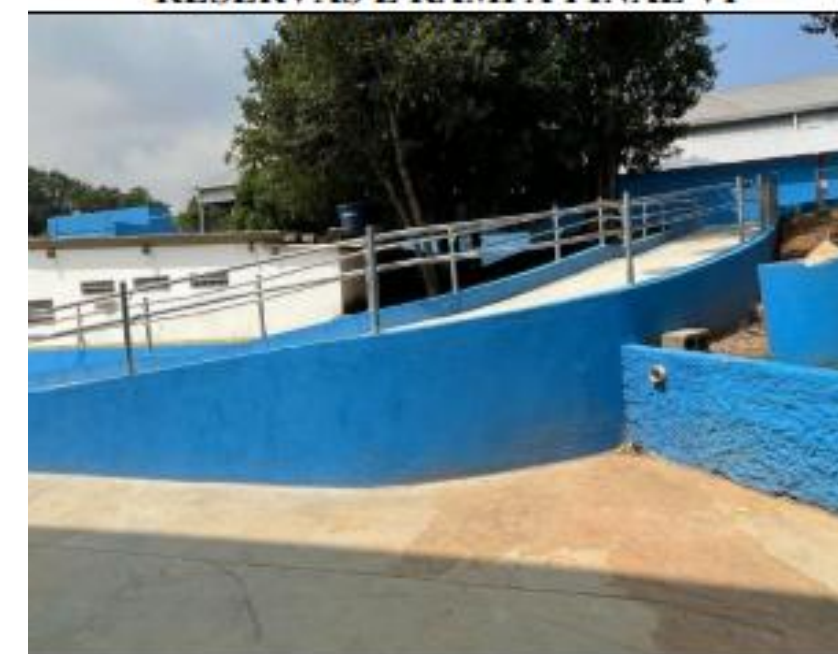
FOTO 123 – QUADRA E BANCO DE RESERVAS E RAMPA FINAL VIII
