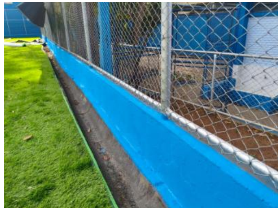
FOTO 5: PINTURA EM LÁTEX
