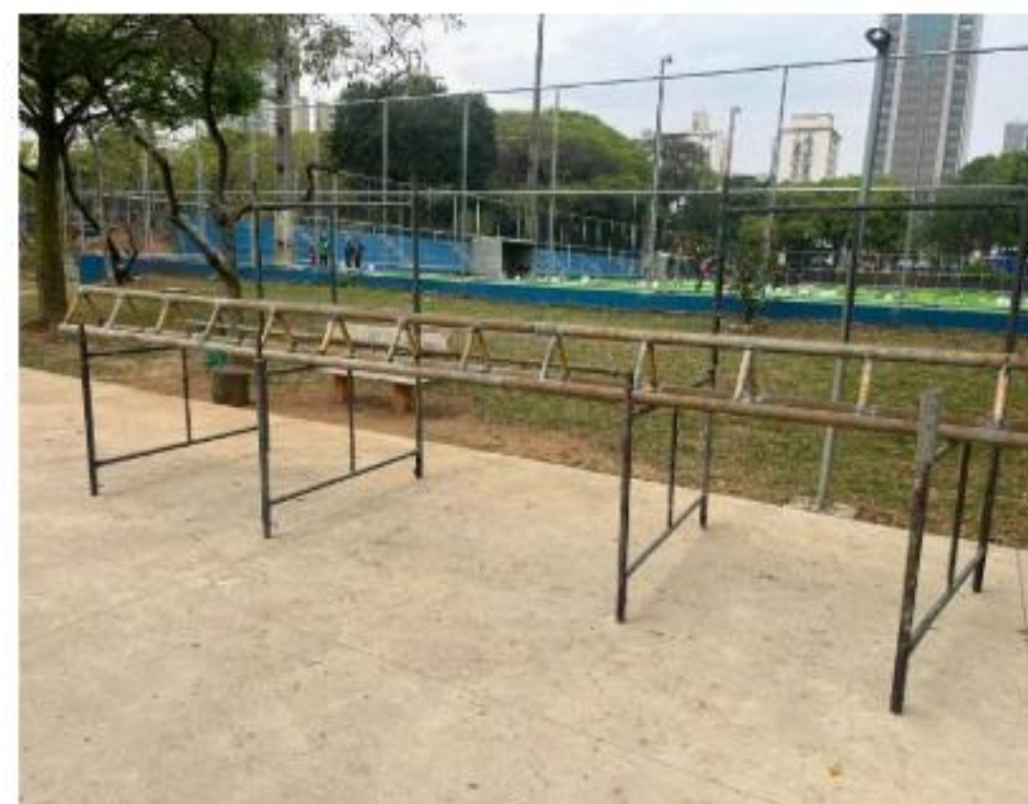
ESTRUTURA METÁLICA DE DIVISA
