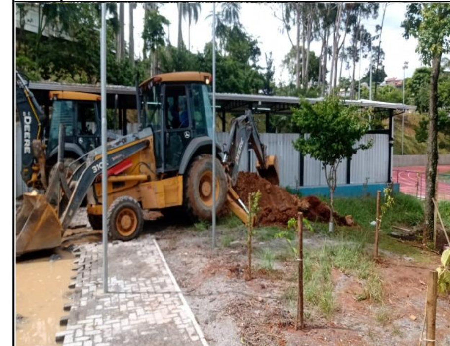
ESCAVAÇÃO PARA IMPLANTAÇÃO DE RAMPA DE ACESSIBILIDADE PARA PCD.
