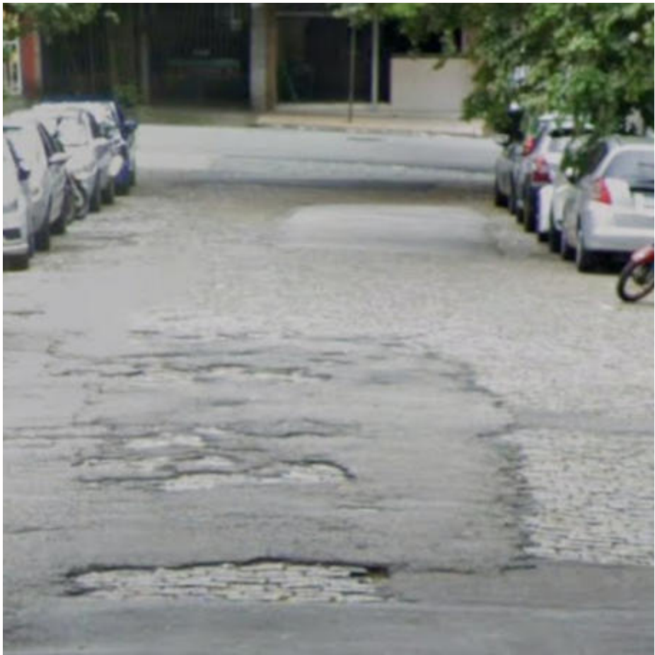
Local da intervenção
