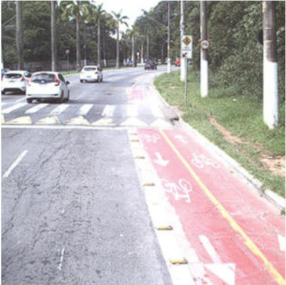
Local da intervenção
