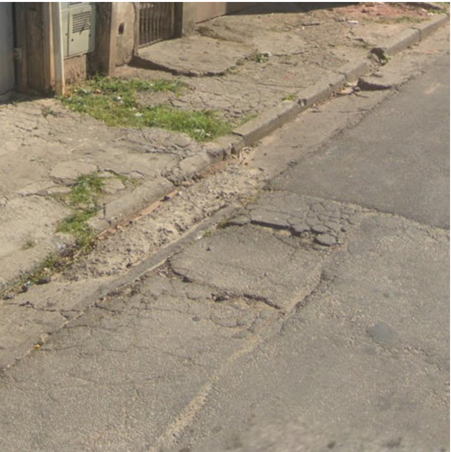
Local da intervenção
