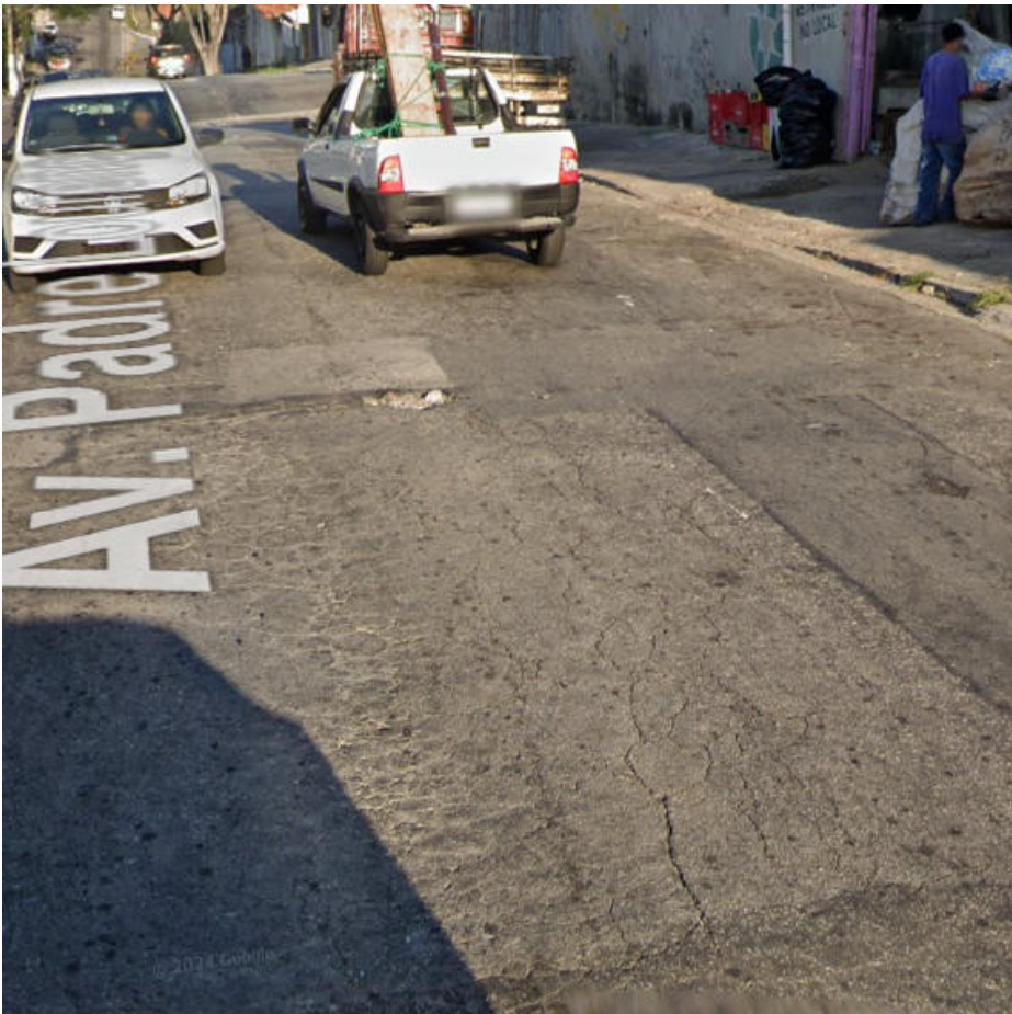
Local da intervenção
