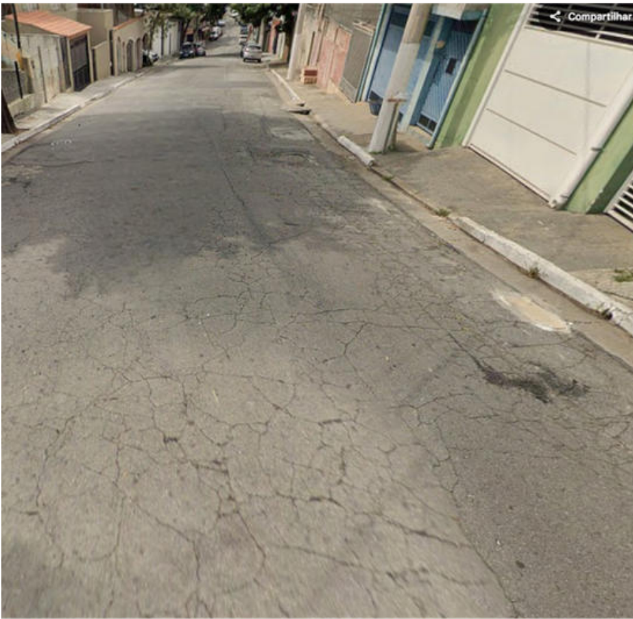
Local da intervenção
