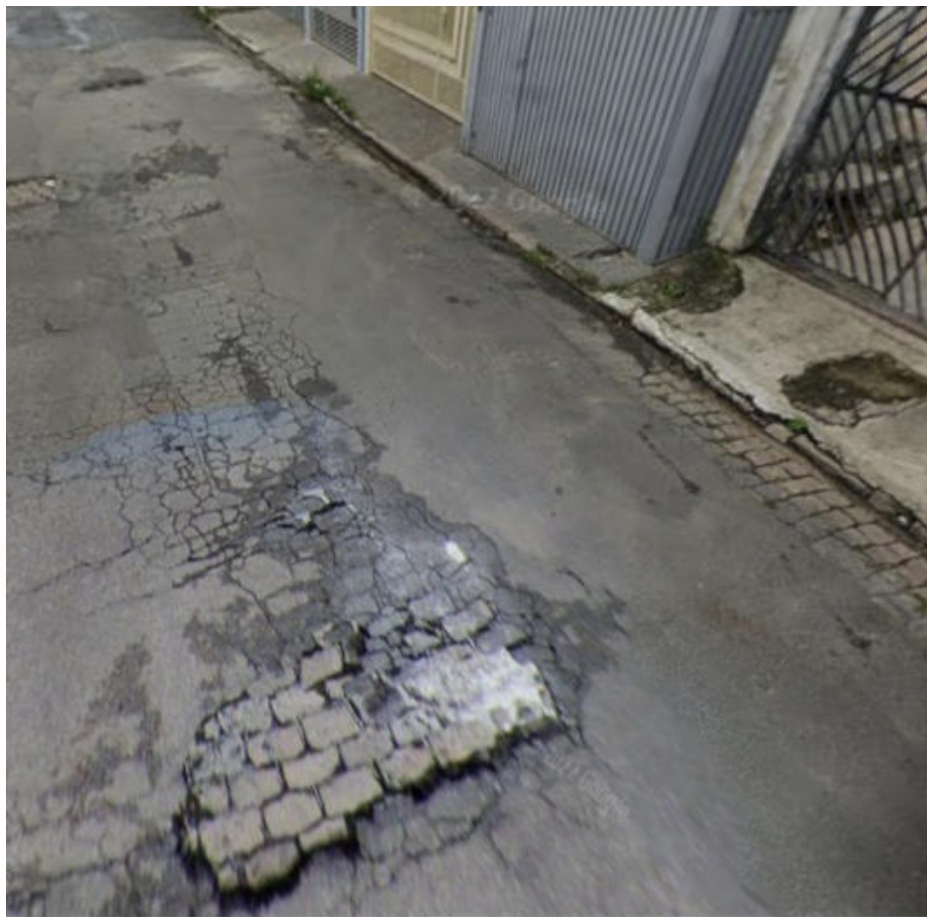
Local da intervenção
