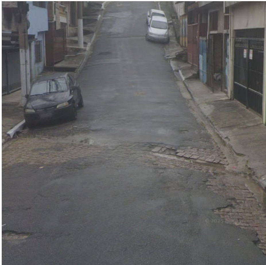
Local da intervenção
