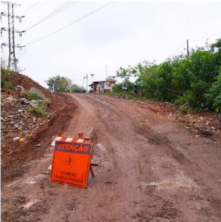
Antes da pavimentação
