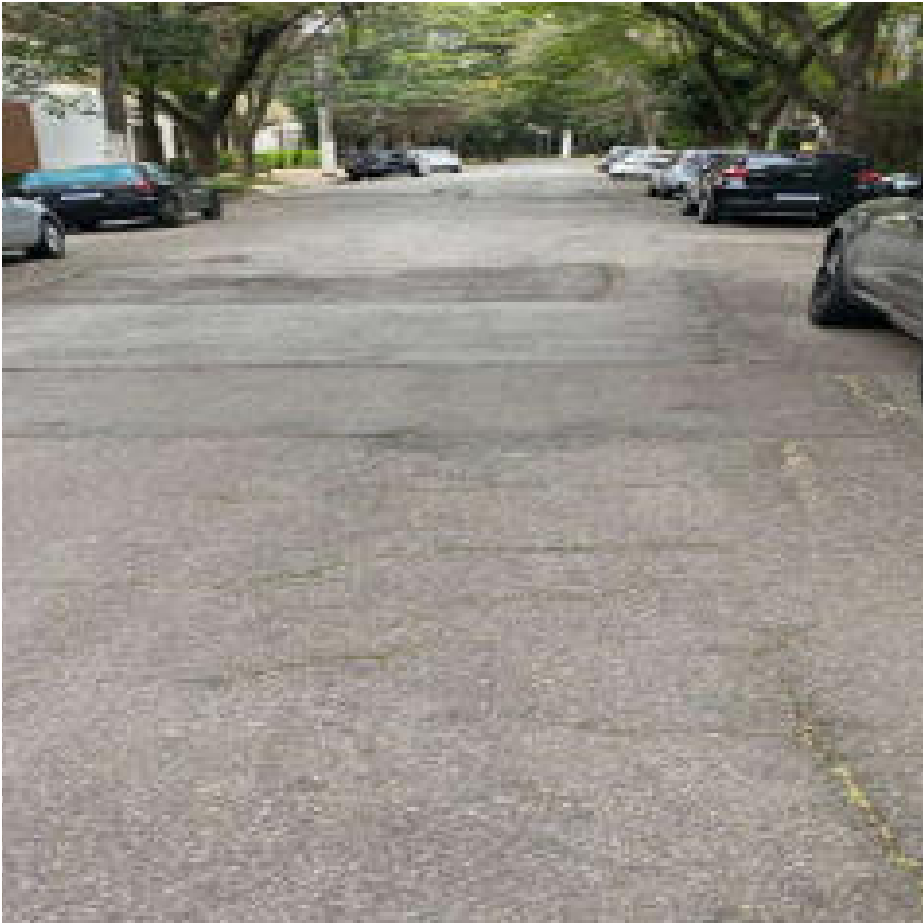
Local da intervenção
