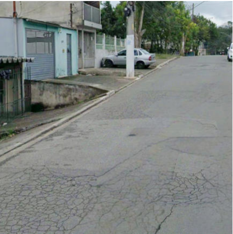
Local da intervenção
