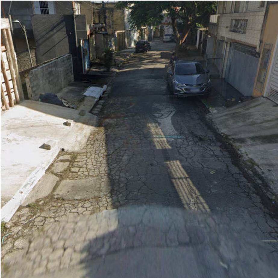
Local da intervenção
