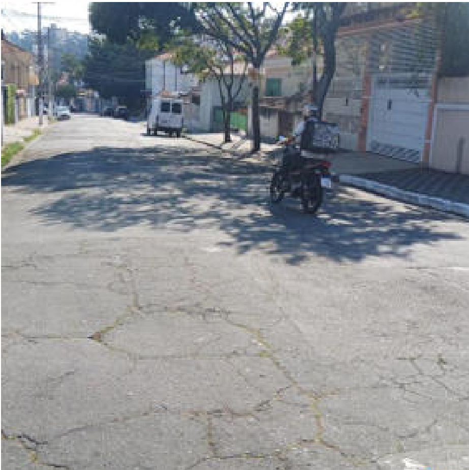
Local da intervenção
