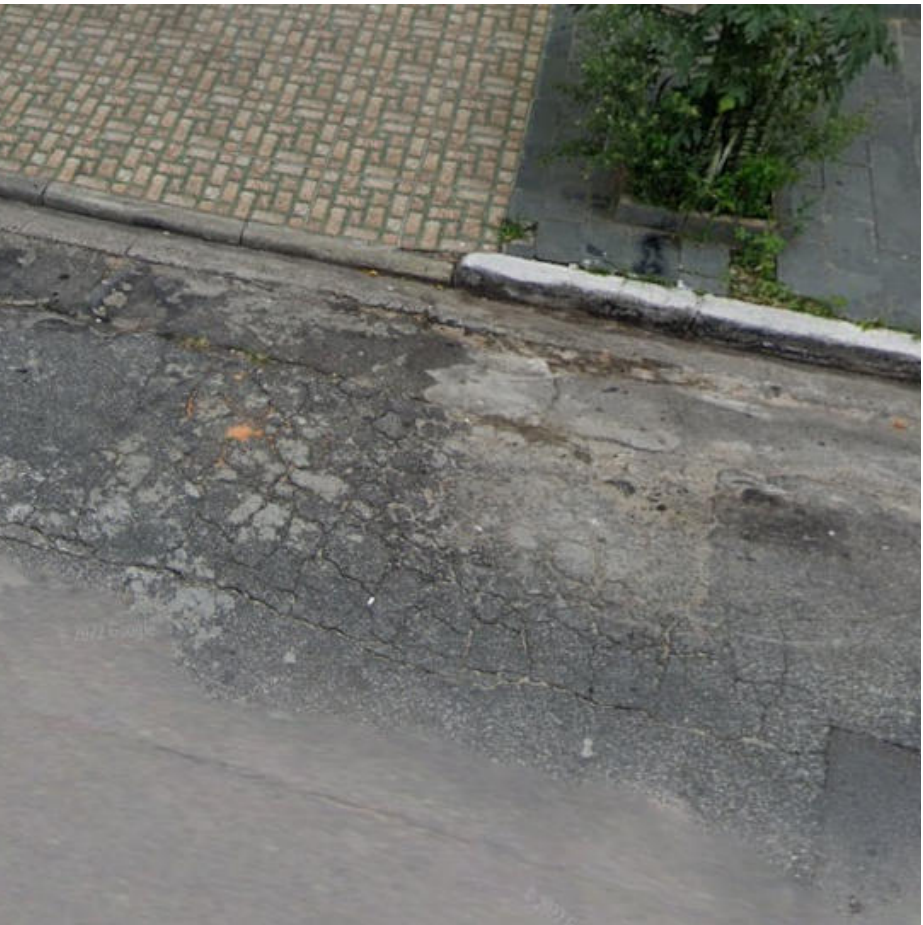
Local da intervenção
