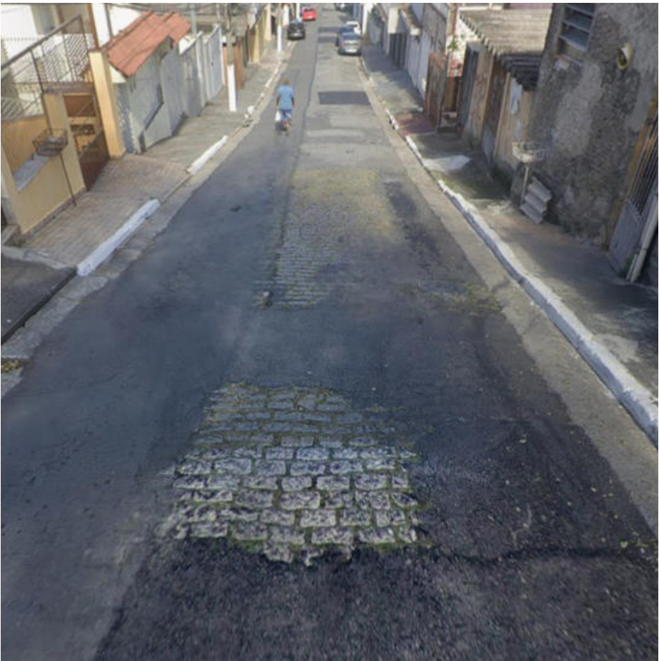
Local da intervenção
