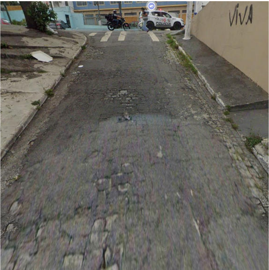
Local da intervenção
