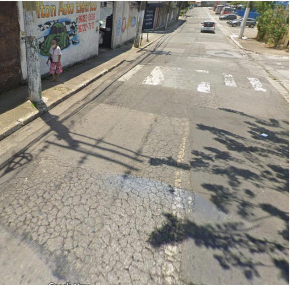
Local da Intervenção
