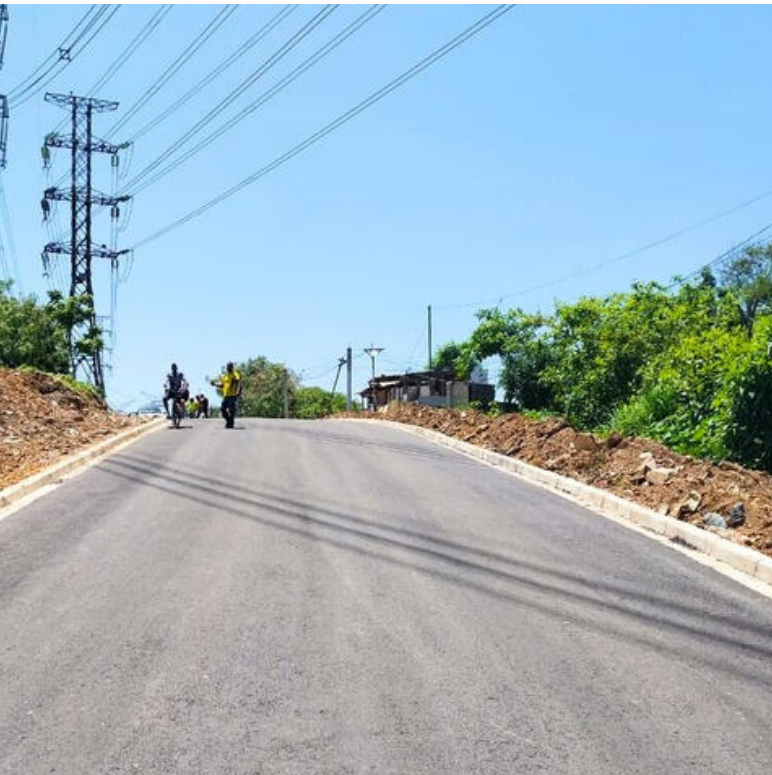
Depois da pavimentação
