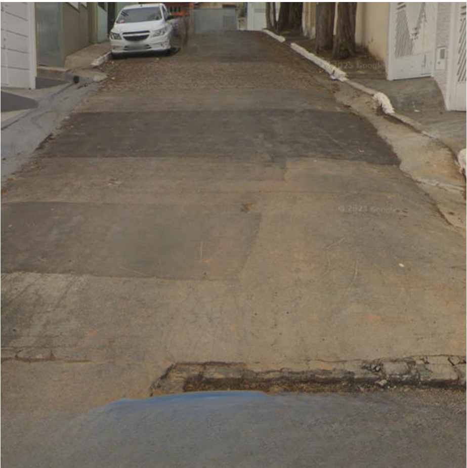
Local da intervenção
