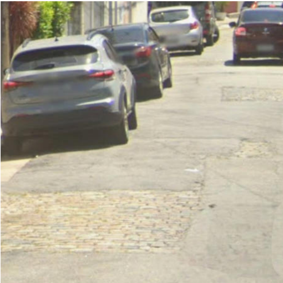
Local da intervenção
