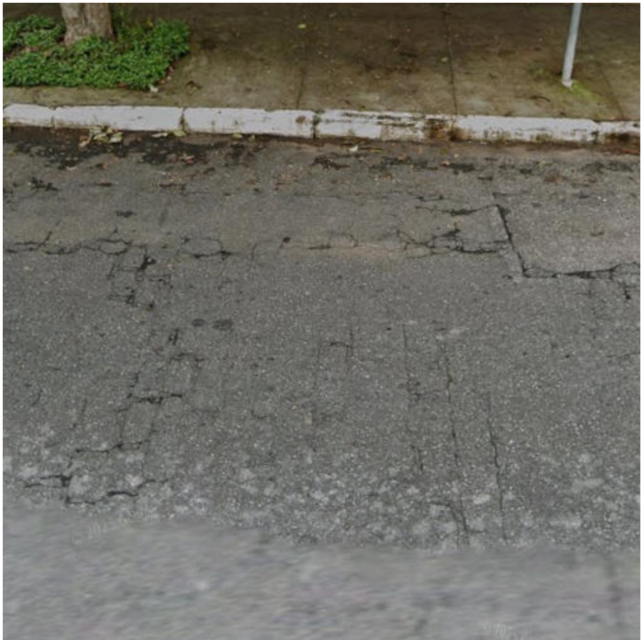
Local da intervenção
