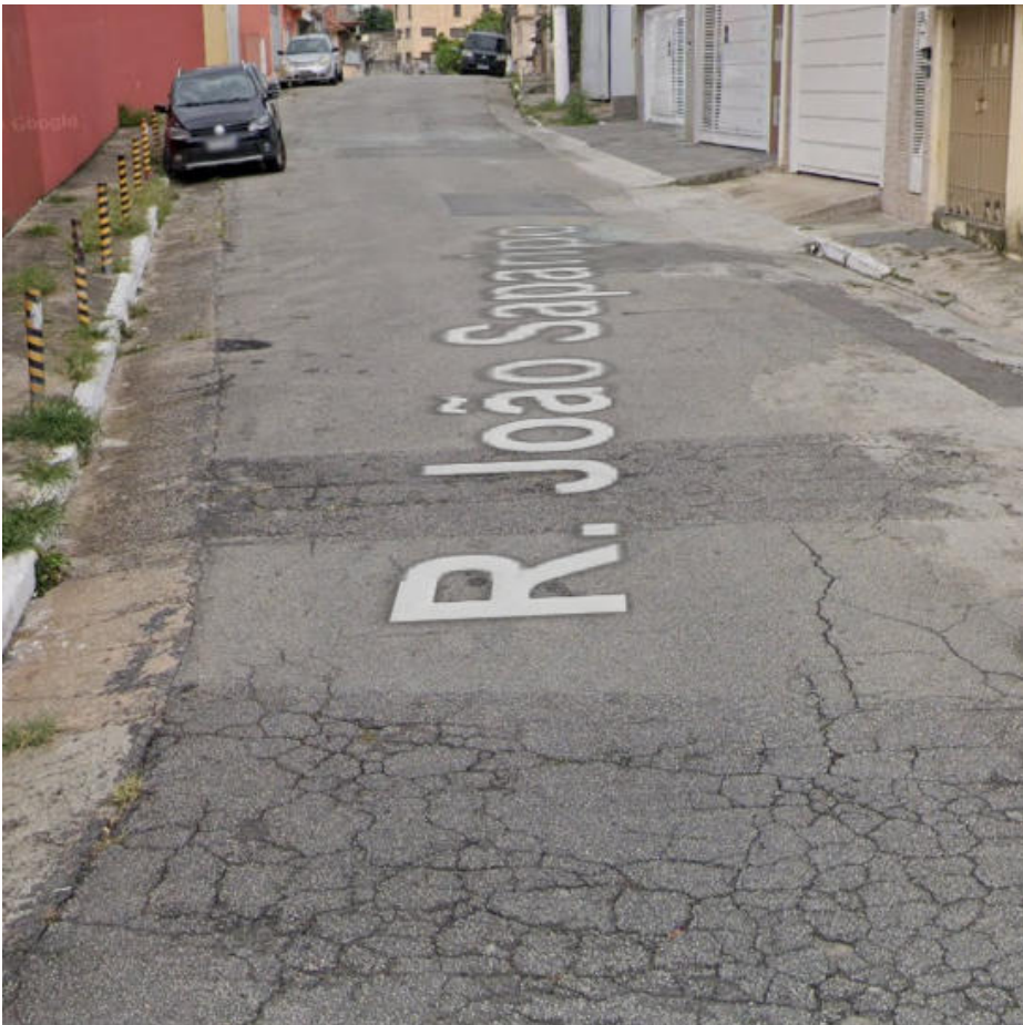
Local da intervenção
