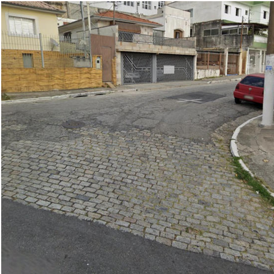
Local da intervenção
