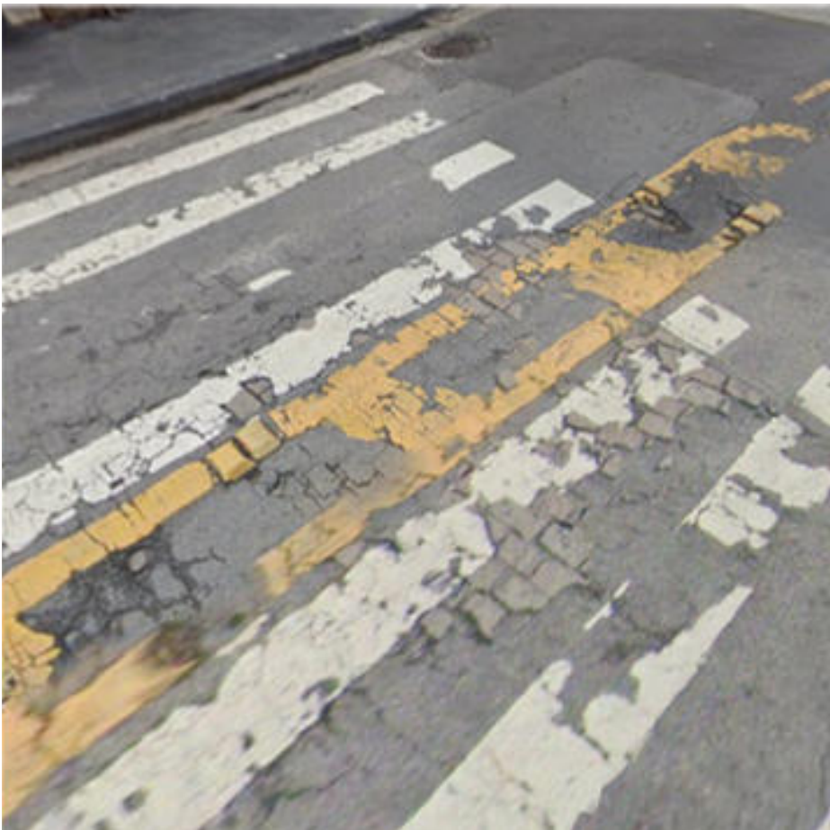
Local da intervenção
