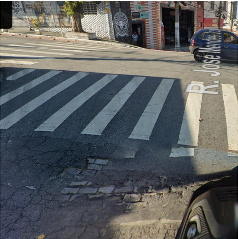
Local da intervenção
