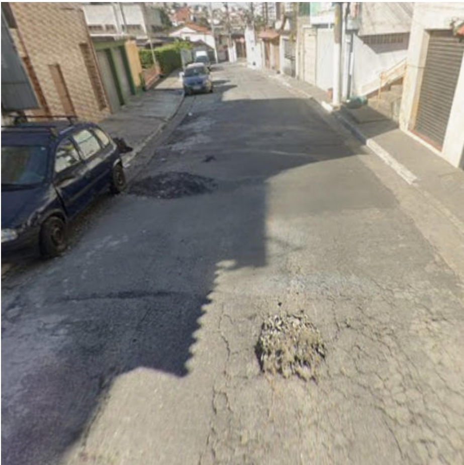
Local da intervenção
