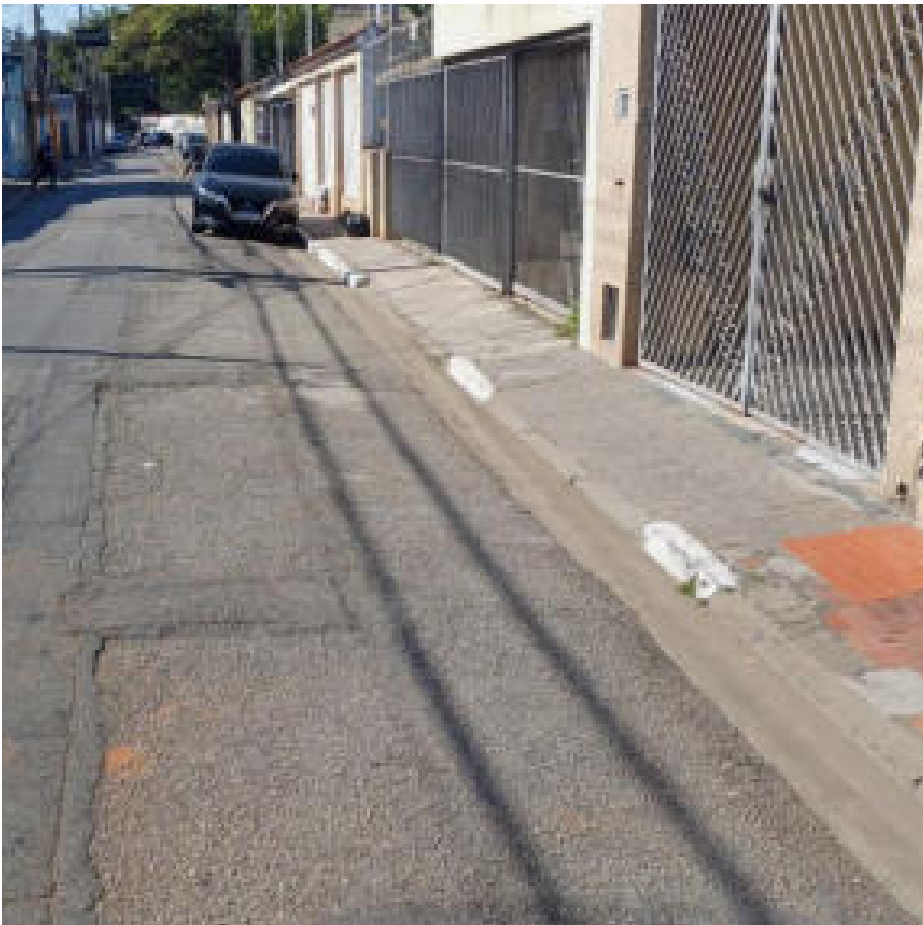
Local da intervenção
