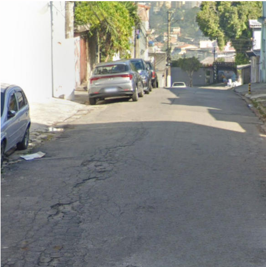
Local da intervenção
