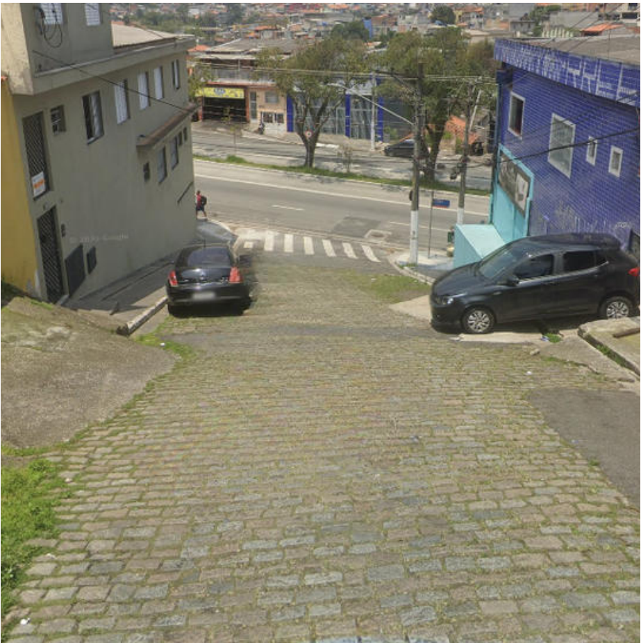
Identificação de Patologia
