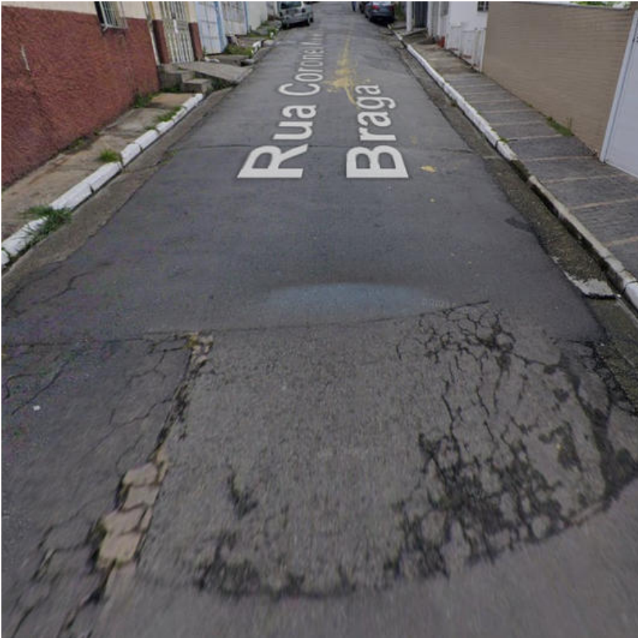
Local da intervenção
