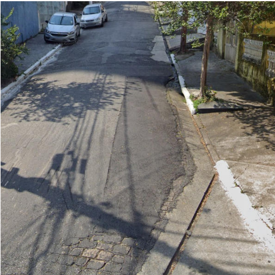
Local da intervenção
