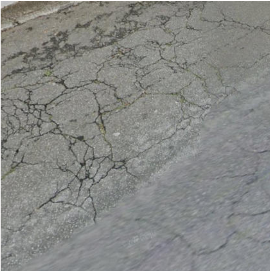
Local da intervenção
