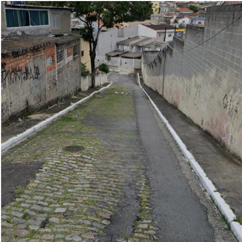
Local da intervenção
