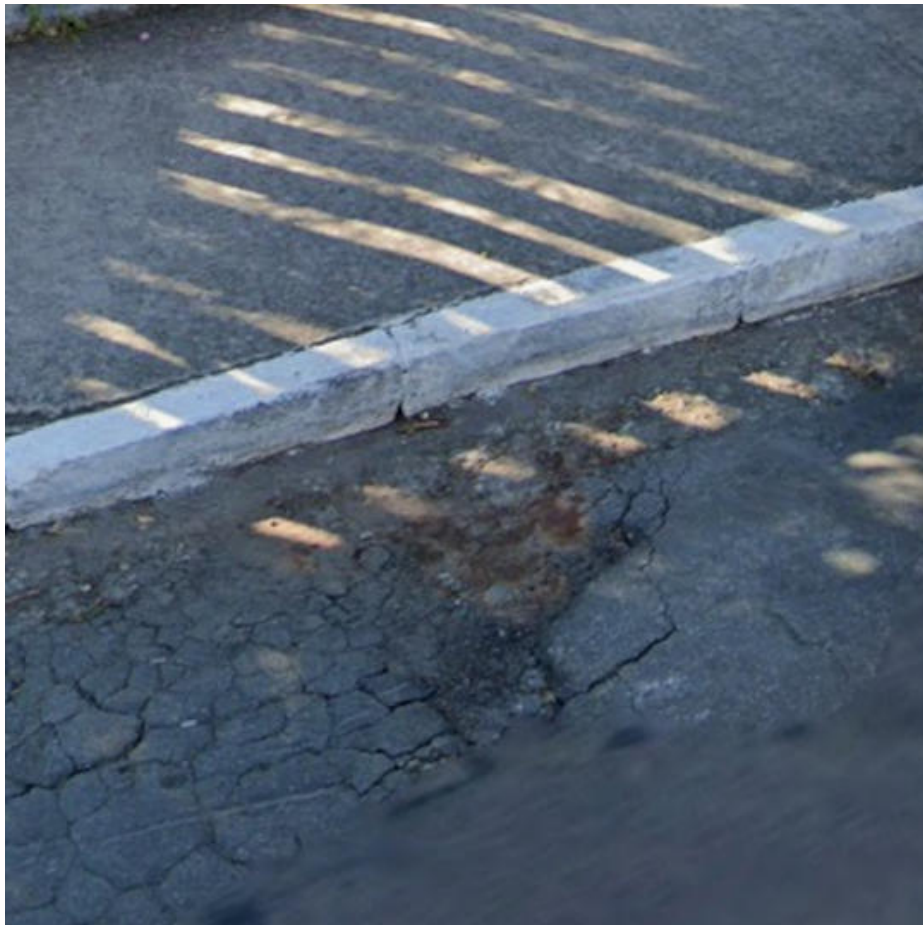
Local da intervenção
