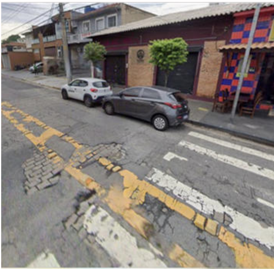
Local da intervenção
