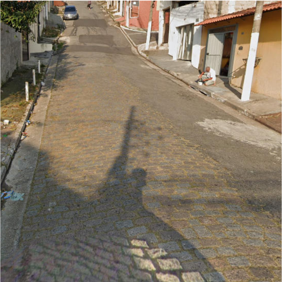
Local da intervenção
