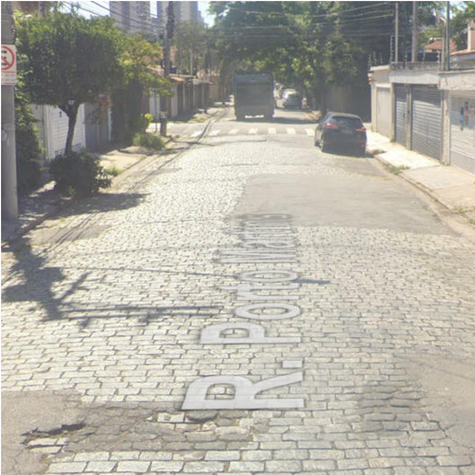
Local da intervenção
