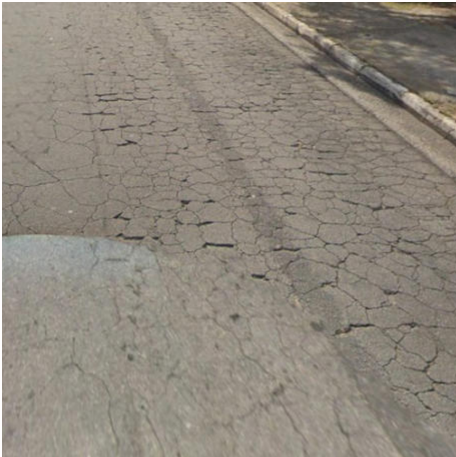
Local da intervenção
