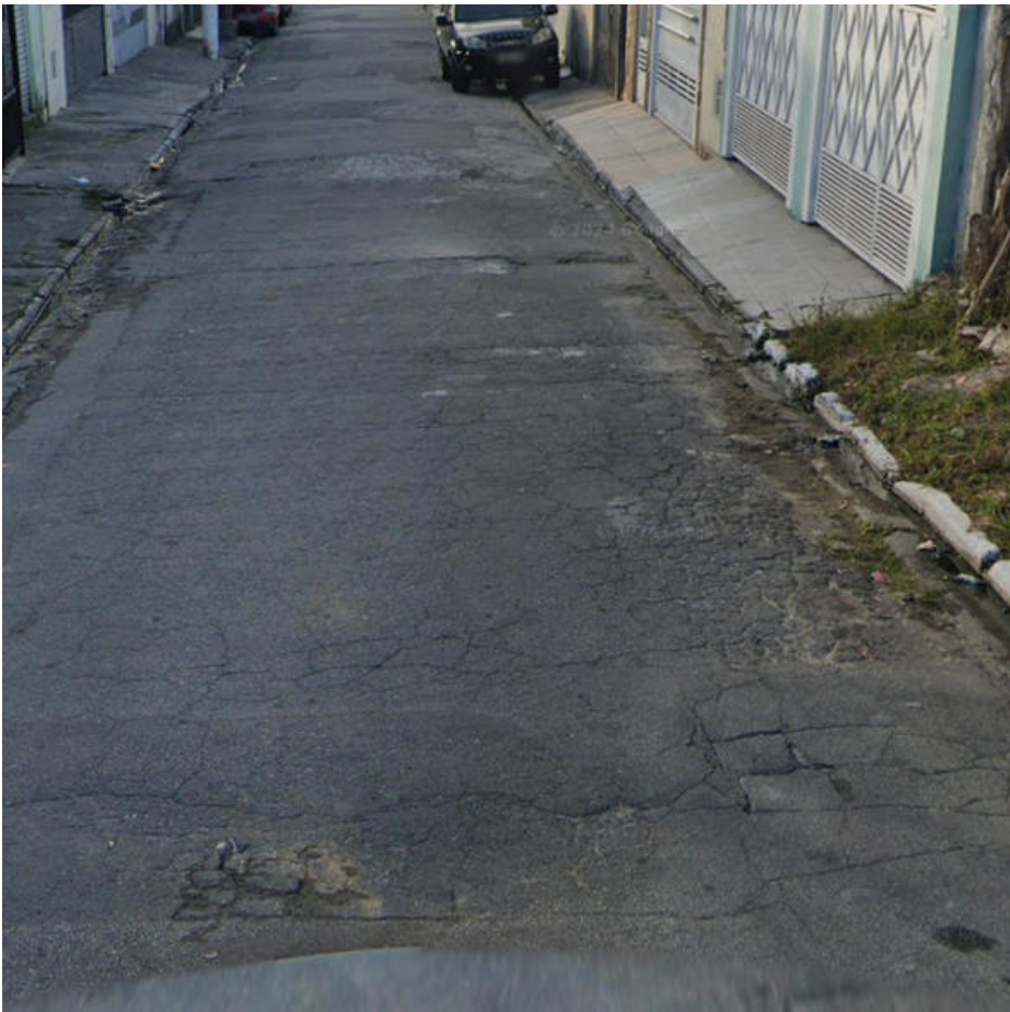
Local da intervenção
