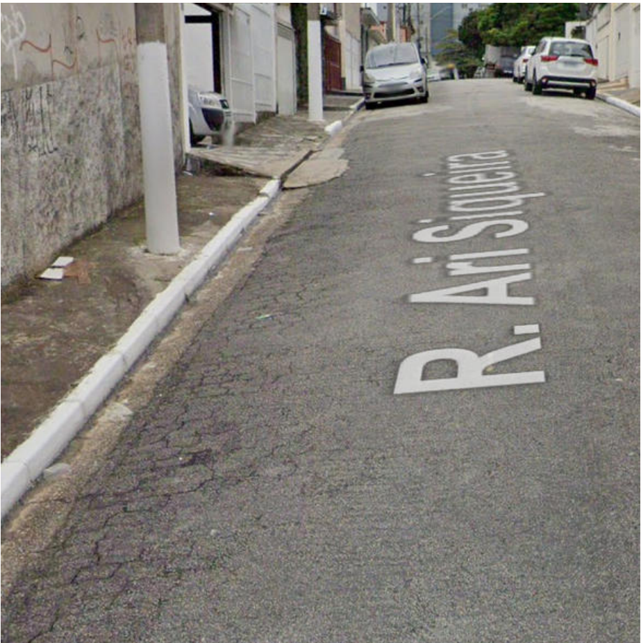
Local da intervenção
