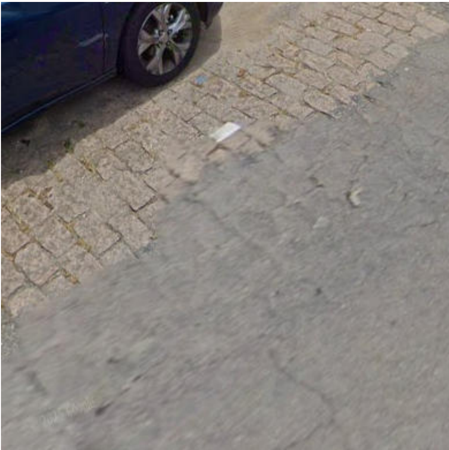
Local da intervenção
