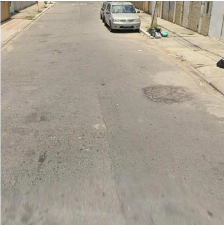
Local da intervenção
