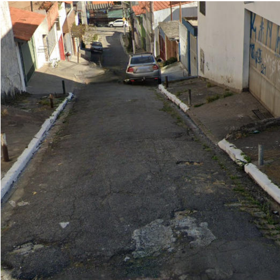
Local da intervenção
