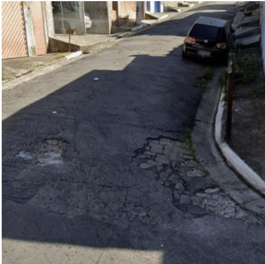
Local da intervenção
