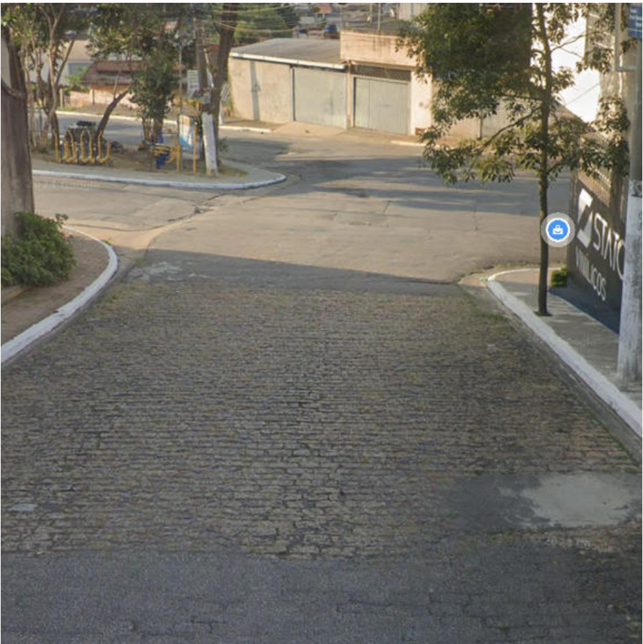
Local da intervenção
