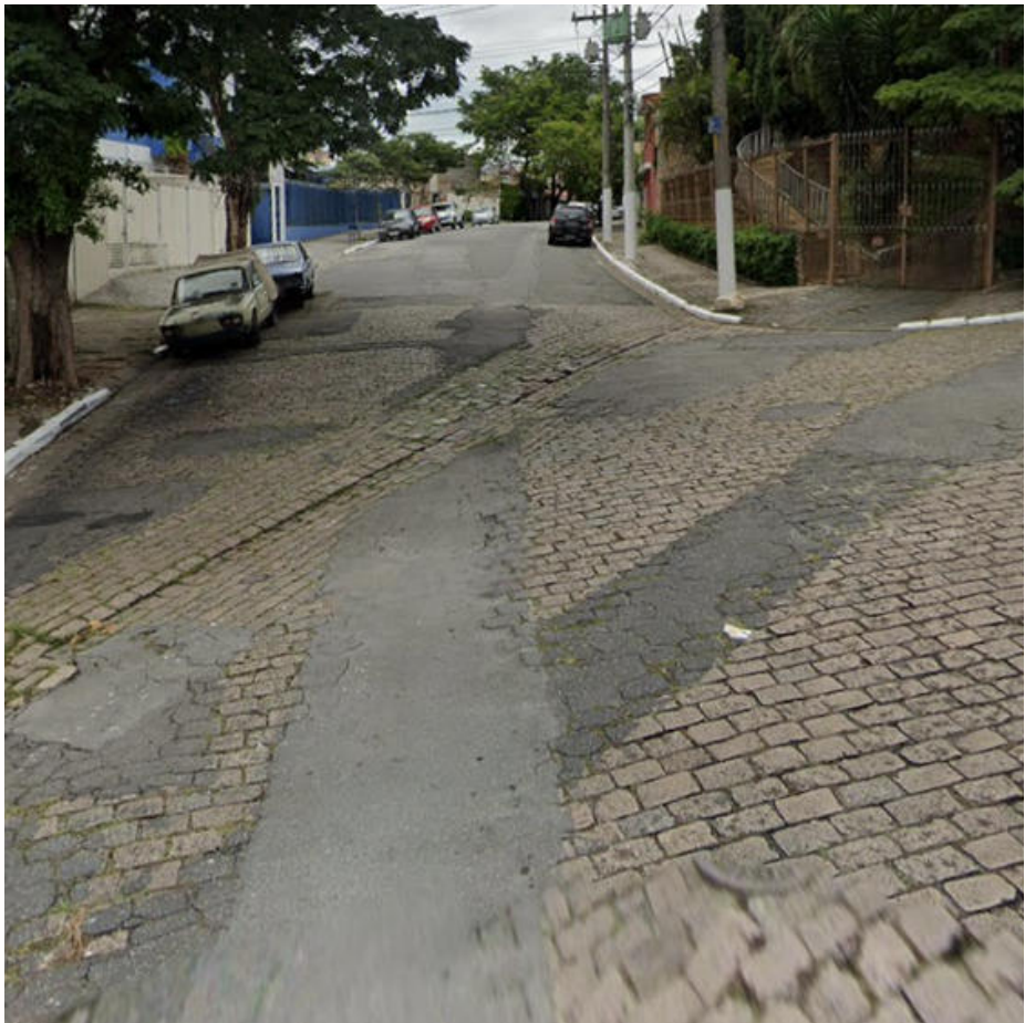
Local da intervenção
