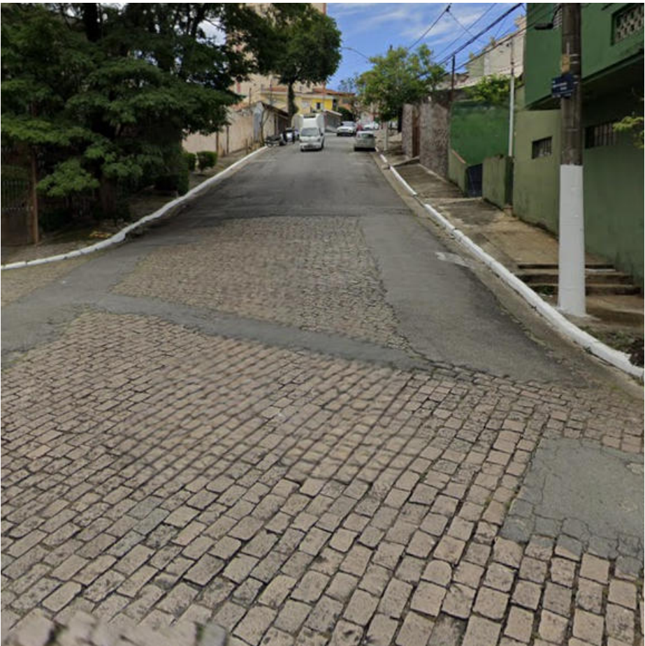
Local da intervenção
