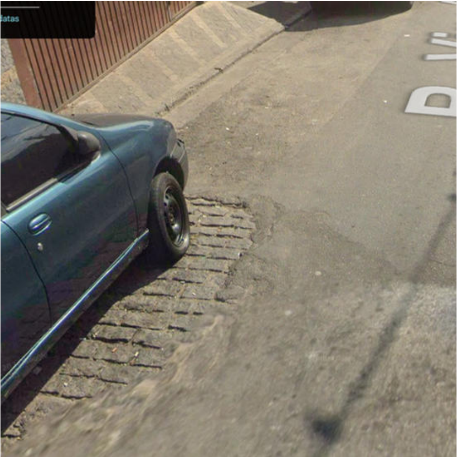
Local da intervenção
