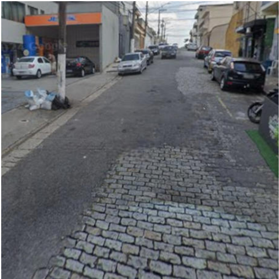
Local da intervenção
