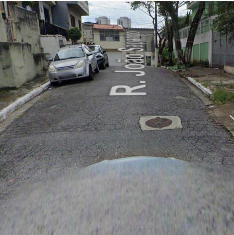
Local da intervenção
