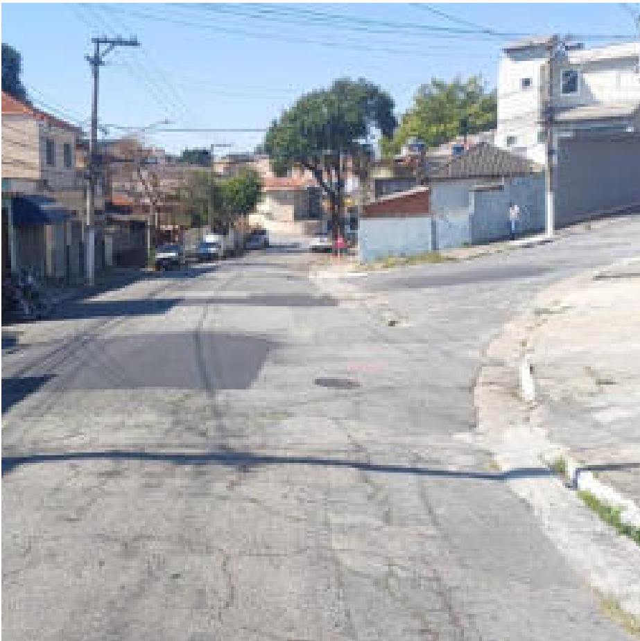
Local da intervenção
