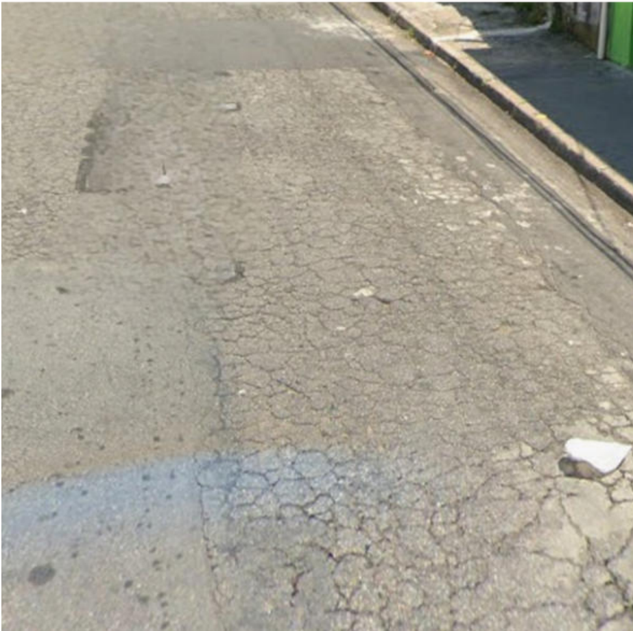
Local da intervenção
