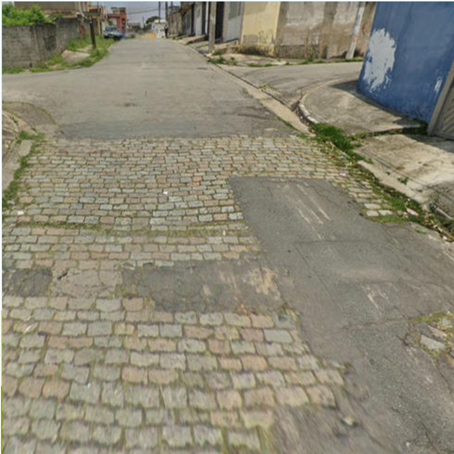
Local da intervenção
