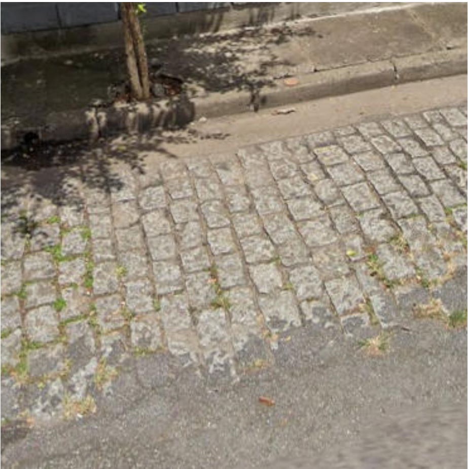
Local da intervenção
