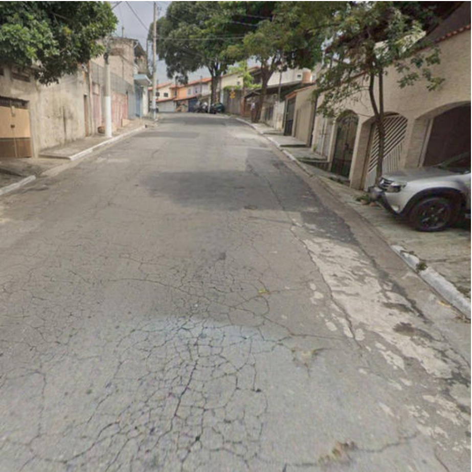
Local da intervenção
