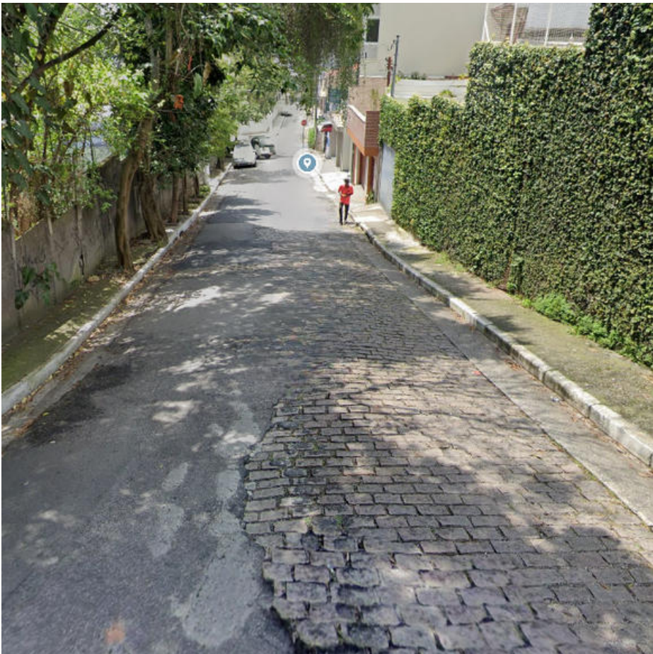
Local da intervenção
