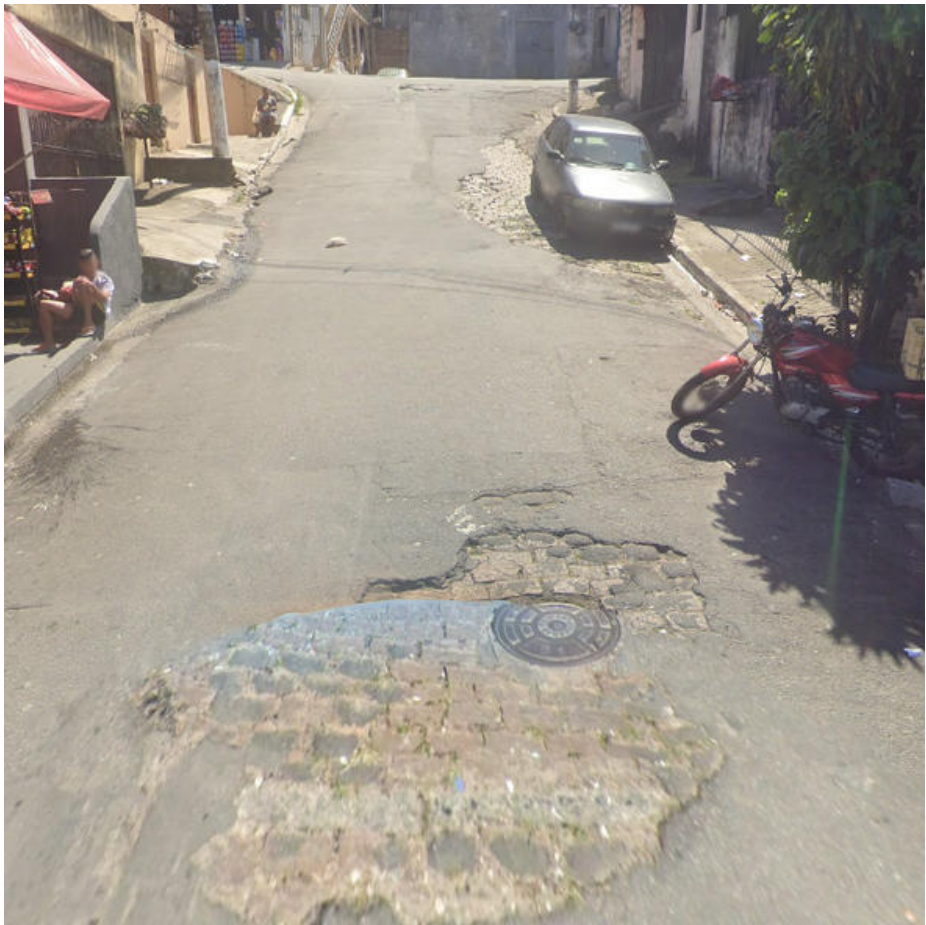
Local da intervenção
