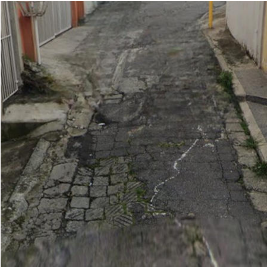
Local da intervenção
