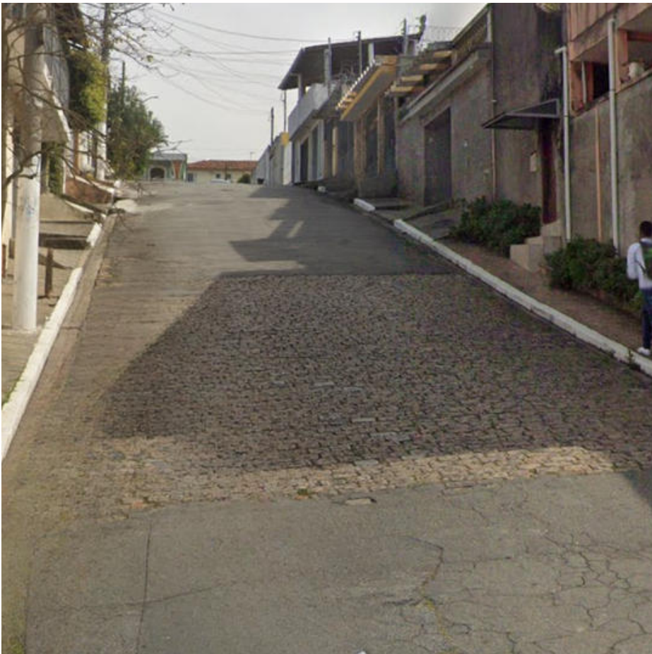
Local da intervenção
