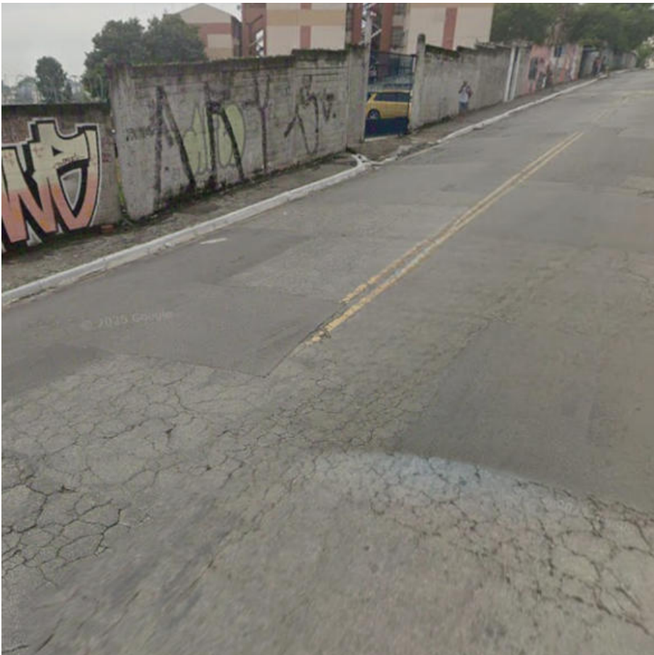
Local da intervenção
