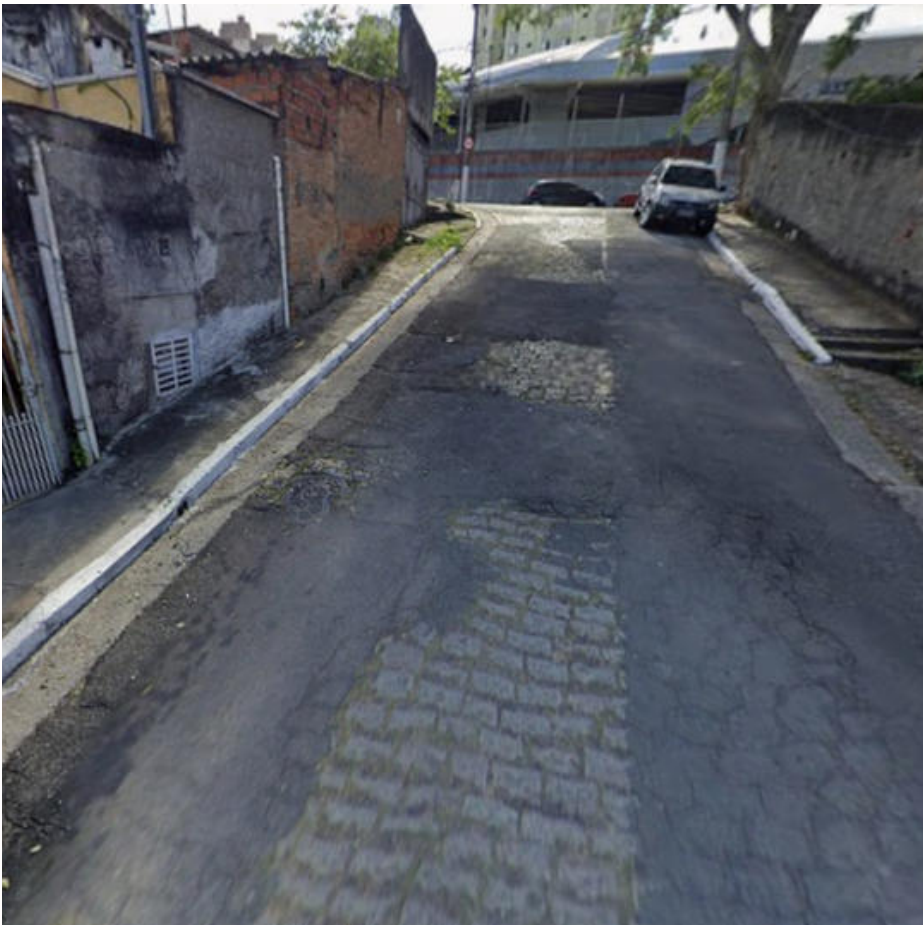
Local da intervenção
