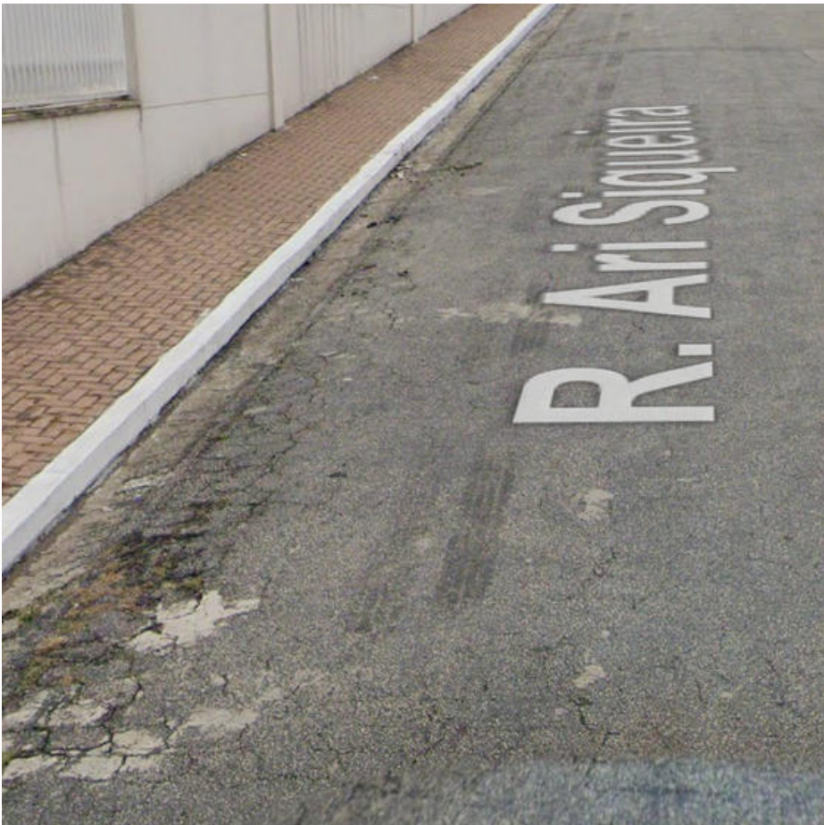
Local da intervenção
