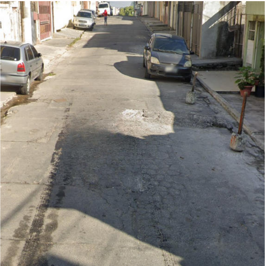
Local da intervenção
