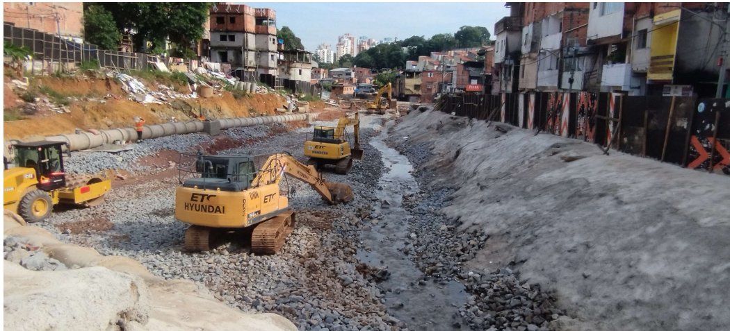
Canalização do Córrego COLOMBO 1ª FASE
