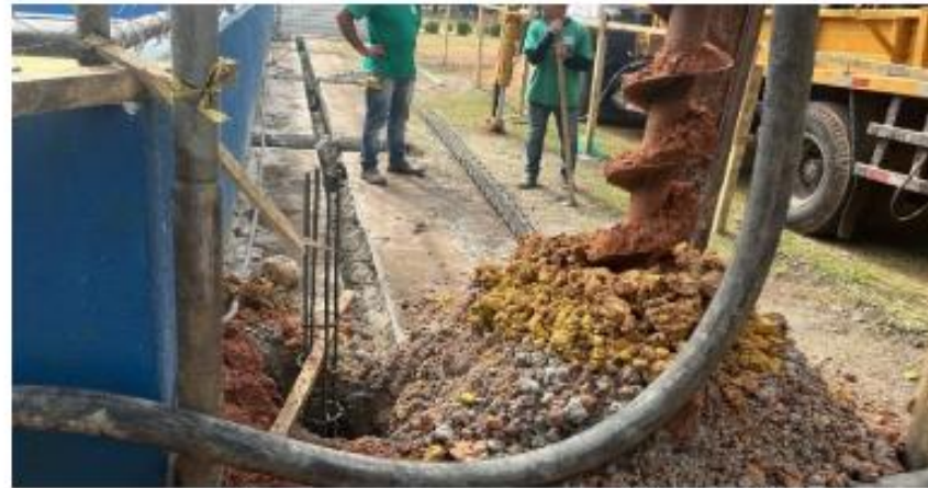
EXECUÇÃO DE ESTACA - HÉLICE CONTÍNUA
