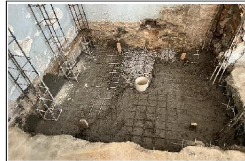
ADM - TELA DE AÇO - POÇO PLATAFORMA
