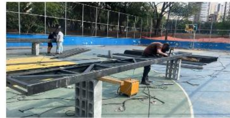
FORNECIMENTO E MONTAGEM DE ESTRUTURA METÁLICA
