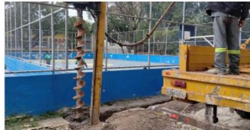
EXECUÇÃO DE ESTACA - HÉLICE CONTÍNUA
