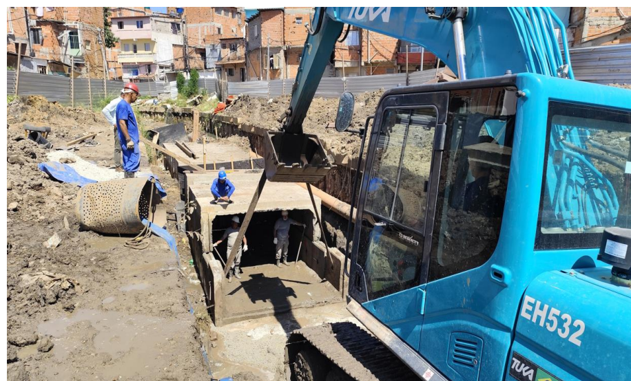
Instalação das aduelas de concreto
