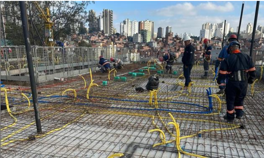
Condomínio E1 - Execução da rede elétrica na laje
