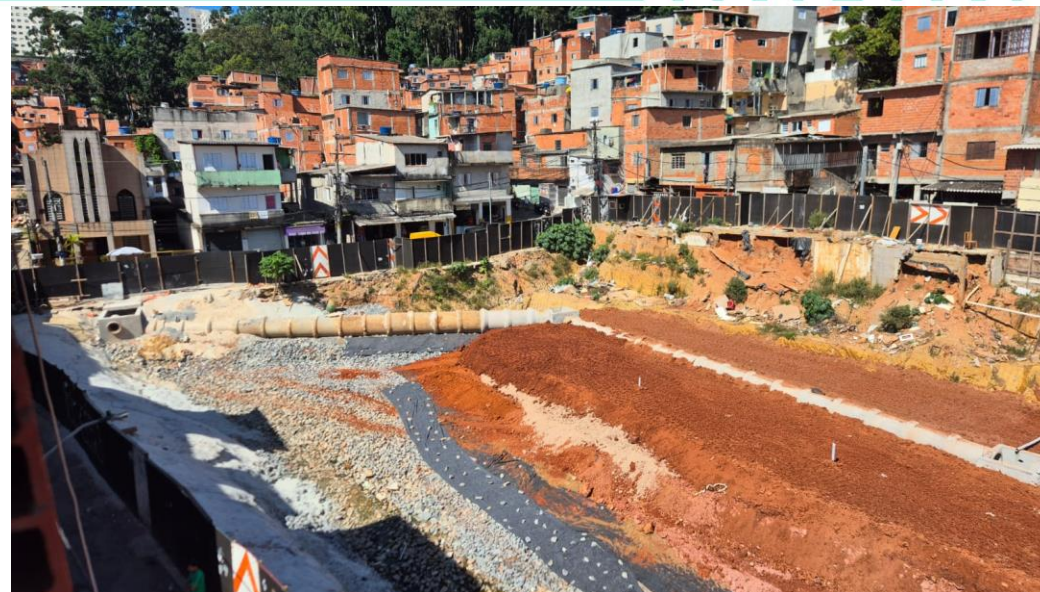
Execução da rede de drenagem
