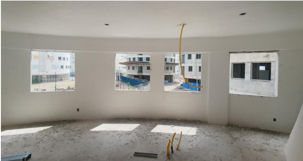
Revestimento de gesso liso
