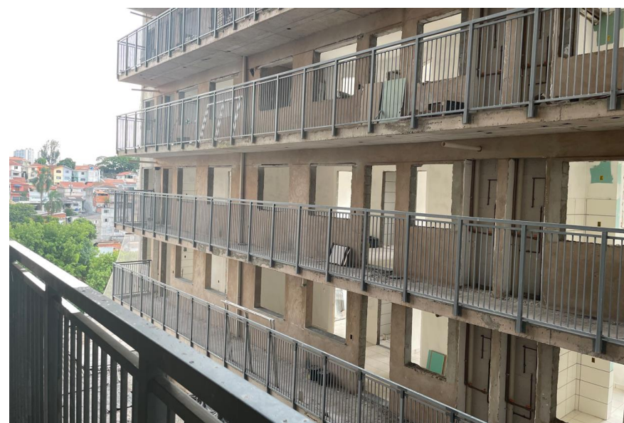
Cond. A – Instalação do guarda-corpo
