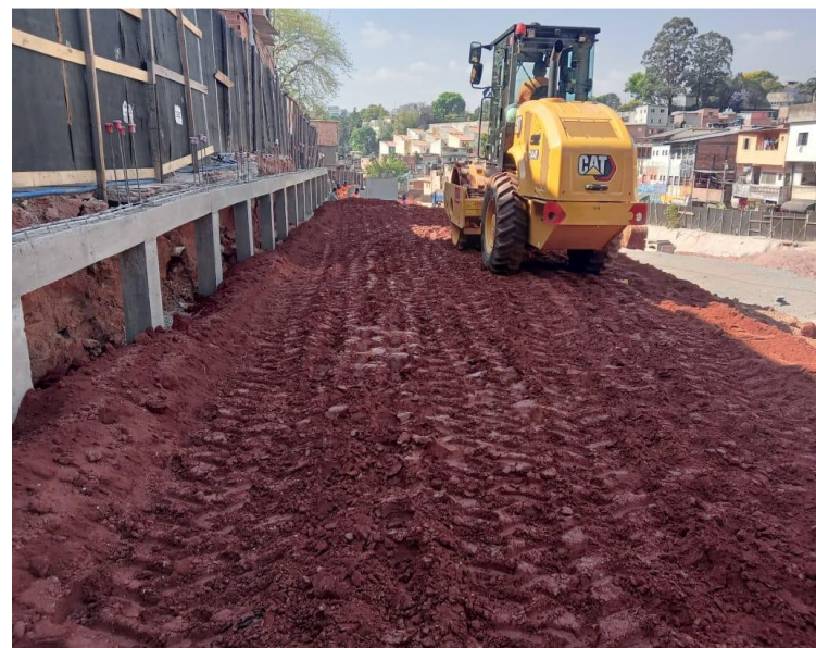
COMPACTAÇÃO DE TALUDE
