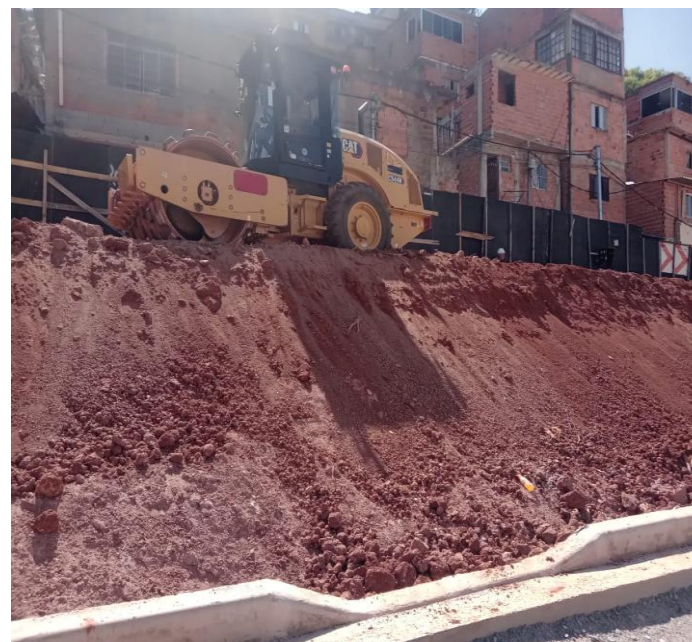
COMPACTAÇÃO DE TALUDE
