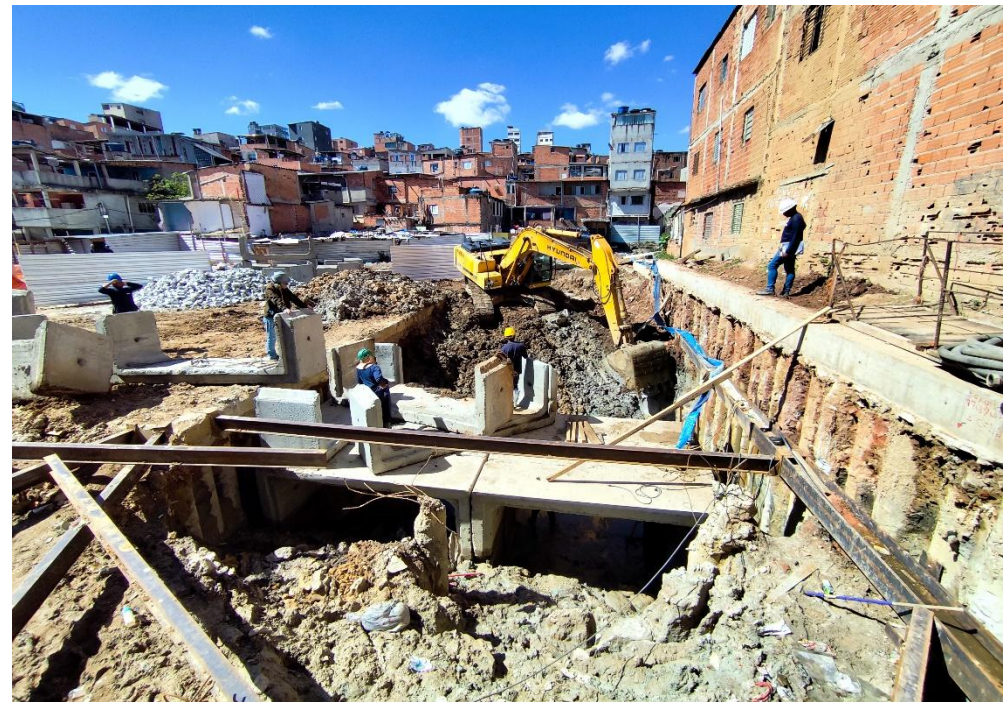
Instalação das aduelas de concreto
