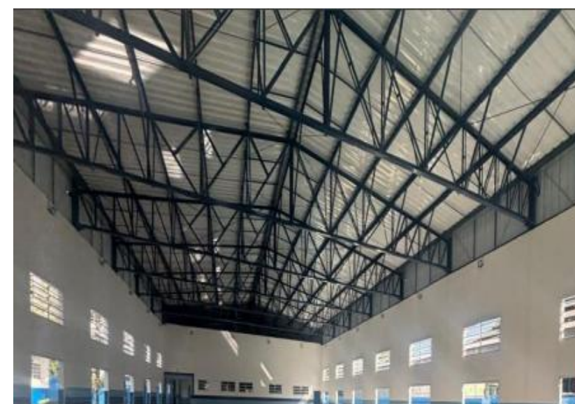
PINTURA ESTRUTURA METÁLICA PISCINA
