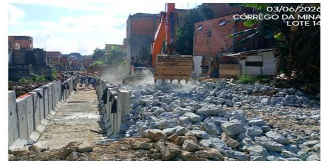
Aplicação de rachão para melhoria no acesso
