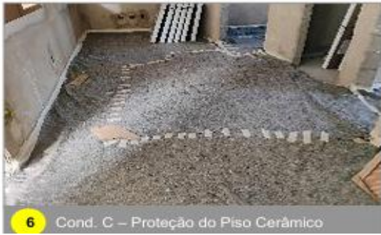
6 Cond. C – Proteção do Piso Cerâmico
