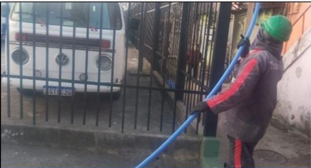
Ligações provisórias de água
