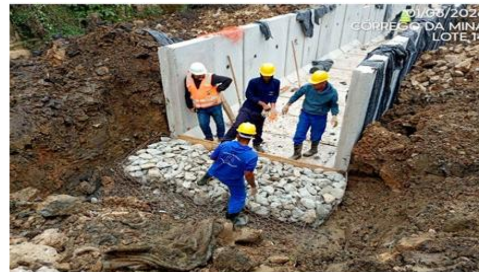
Execução do gabião estaca 8+15
