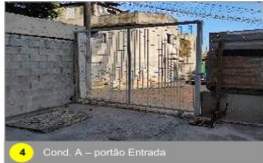
4 Cond. A – portão Entrada
