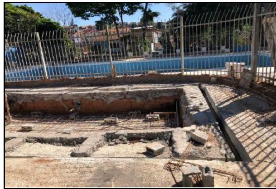
ARMADURA DE AÇO
