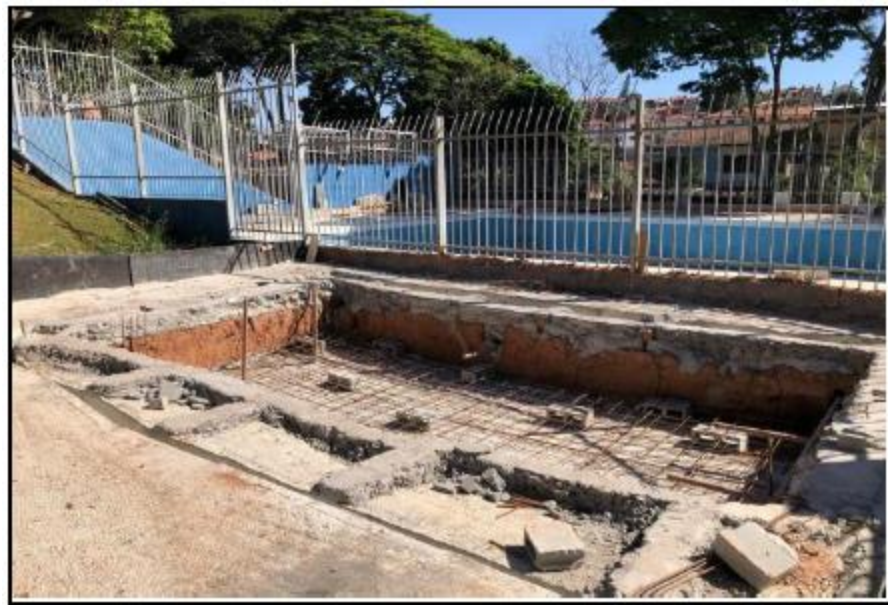
ARMADURA DE AÇO
