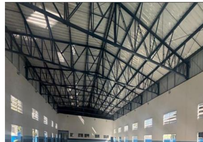
PINTURA ESTRUTURA METÁLICA PISCINA
