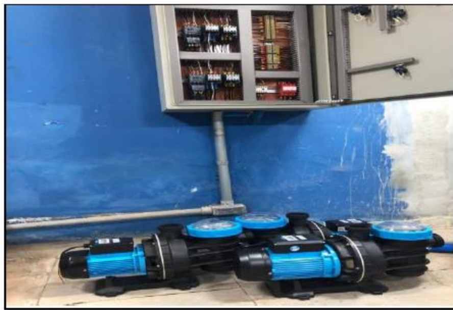
CONJUNTO MOTOR-BOMBA 240M3/H, 20MCA, 20CV,
