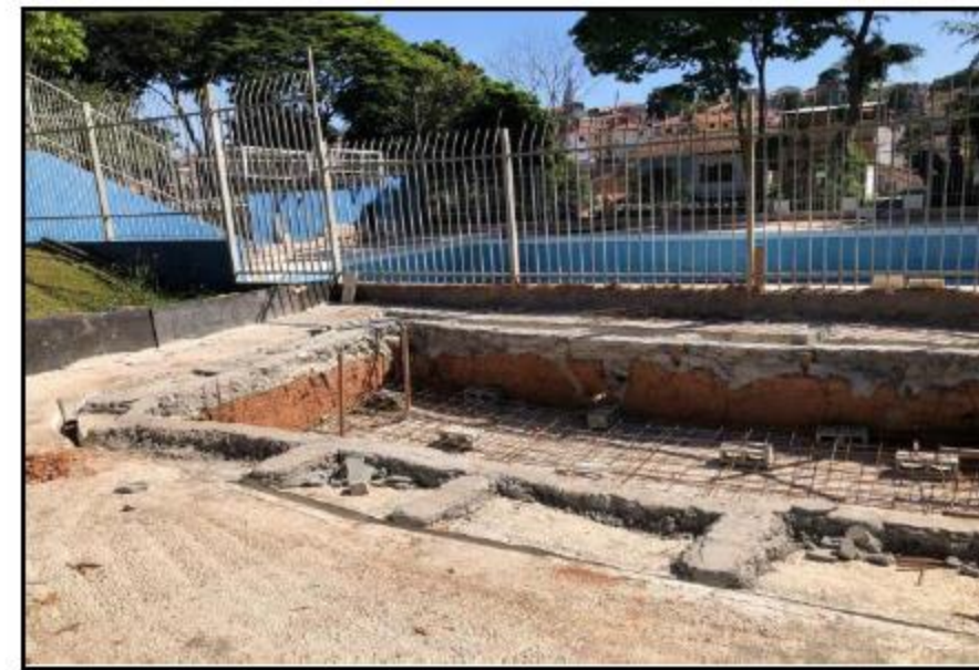
ARMADURA DE AÇO
