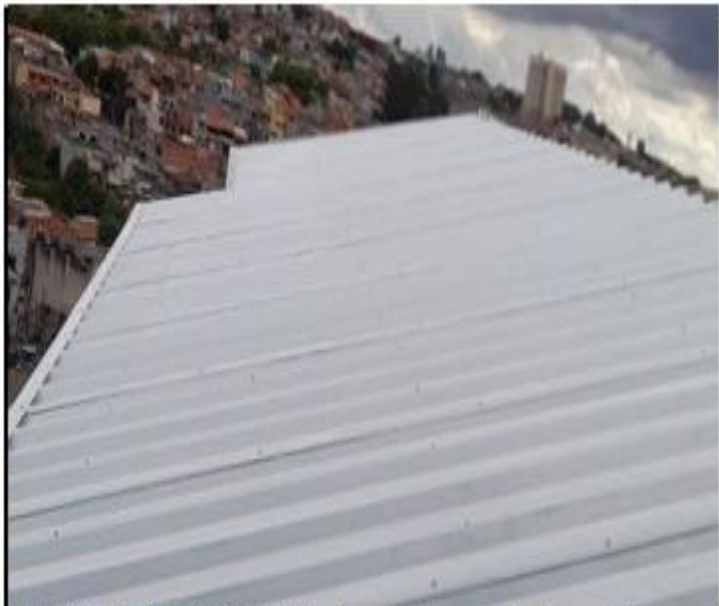
REFORMA DA COBERTURA: Conclusão de telhado metálico em telha trapezoidal dupla.
