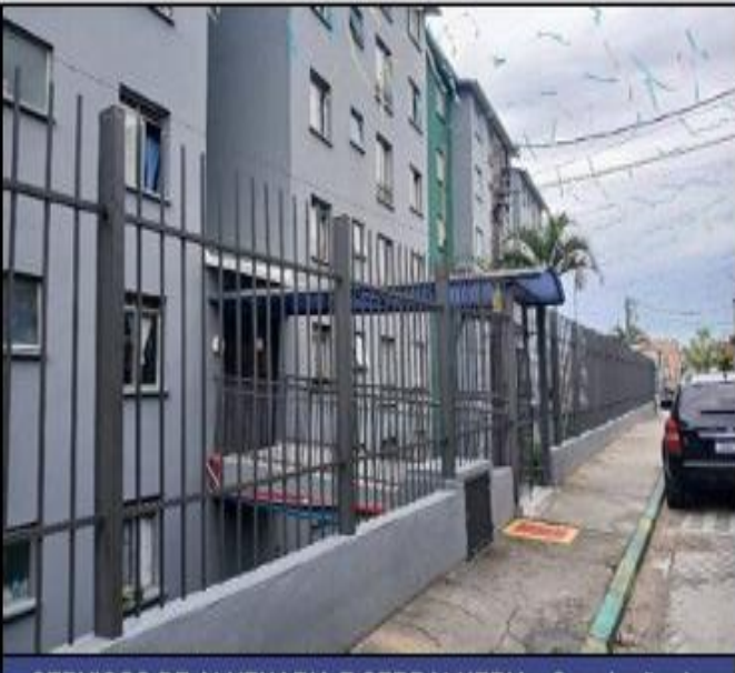
SERVIÇOS DE ALVENARIA E SERRALHERIA - Conclusão de revitalização de gradil e muretas externa.
