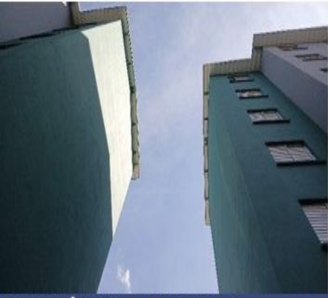
RECUPERAÇÃO E PINTURA DE FACHADAS - Reparos e retoque gerais
