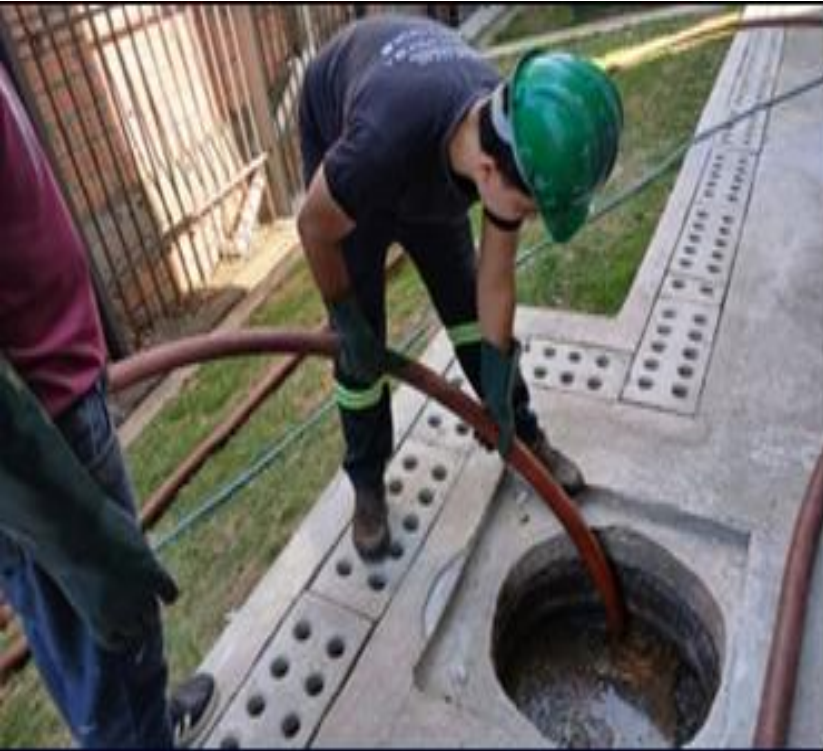
REDE DE ESGOTO - Verificação de caixas de passagem.
