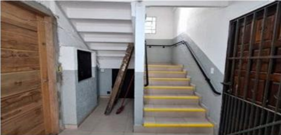
Vista panorâmica hall e escadas internas
