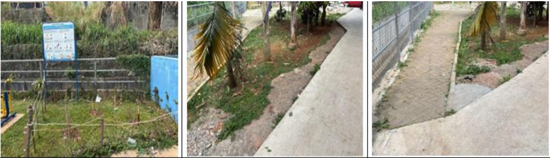
PRAÇA SOGROS – REFORMA DE PRAÇA
