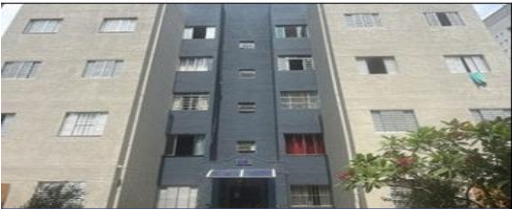
Vista panorâmica - Bloco 4
