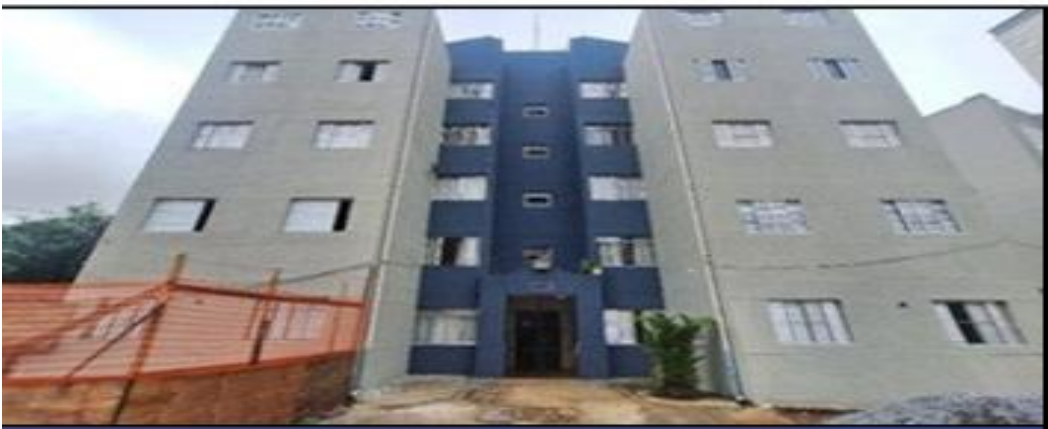
Vista panorâmica - Bloco 5
