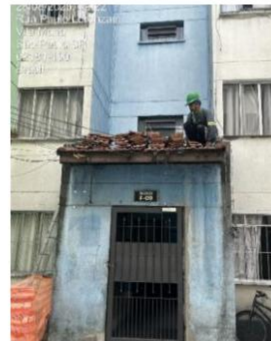
FOTO 09 - TELHADO E FACHADA HALL DE ENTRADA
