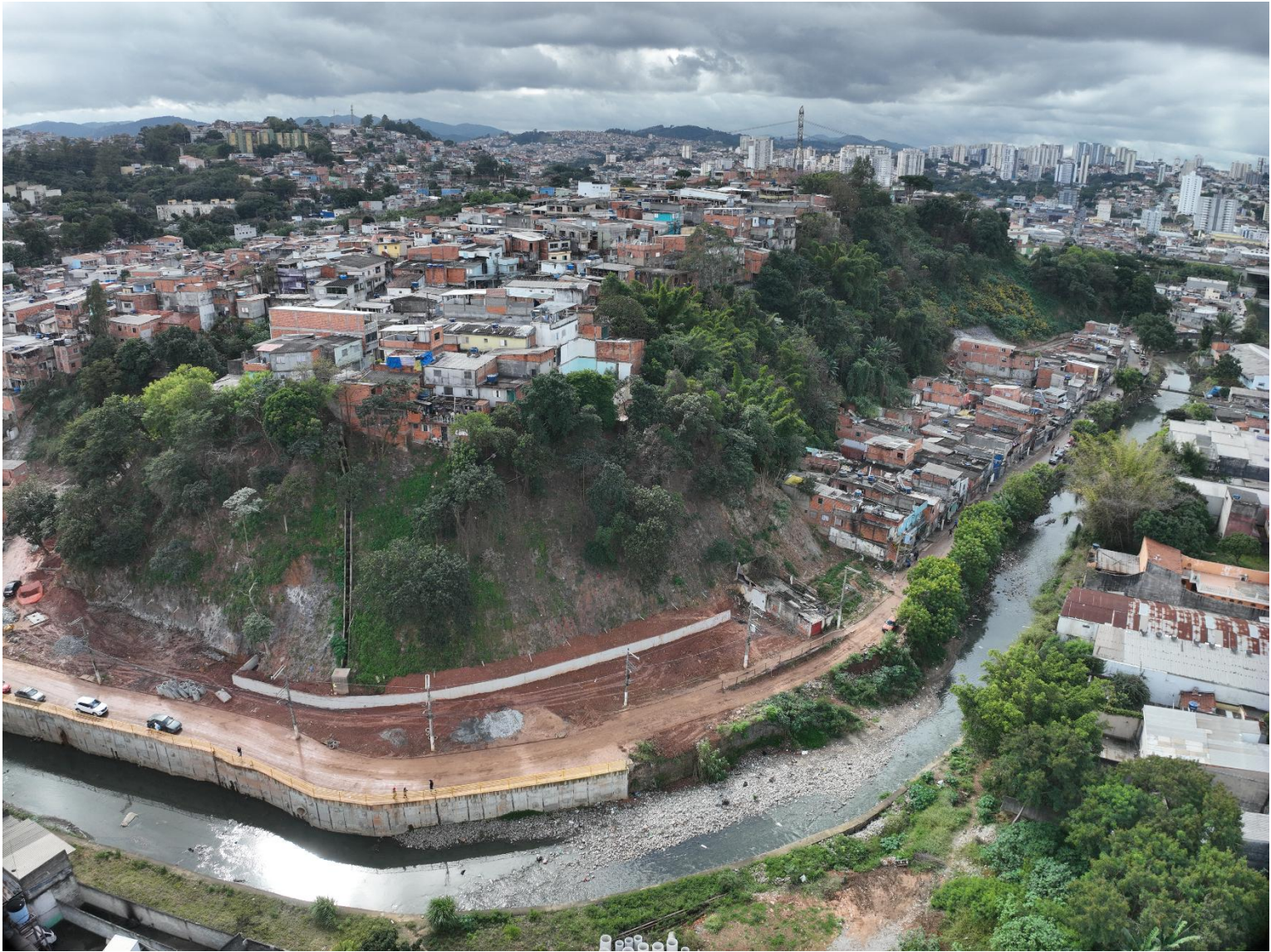
Contenção de encosta
