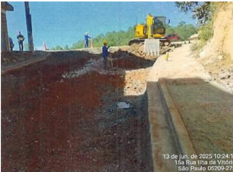
ABERTURA DE CAIXA PARA PAVIMENTAÇÃO
