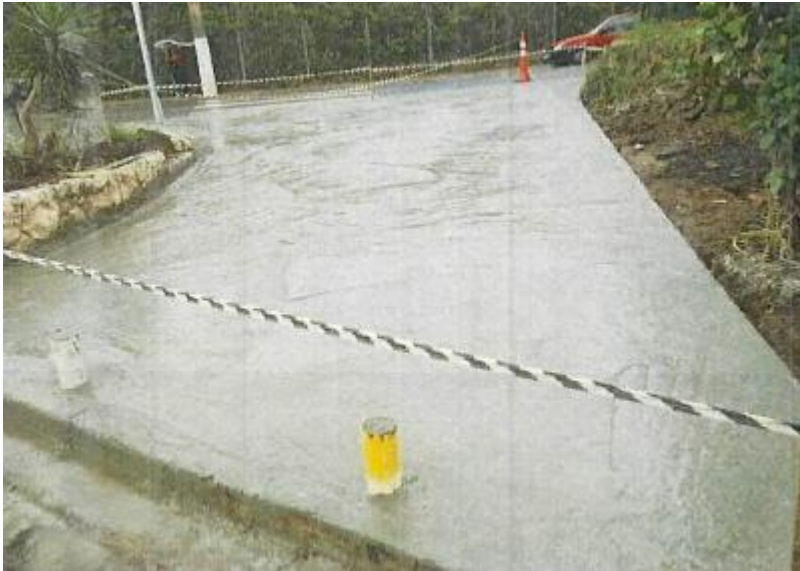
CONCRETO RECÉM-LANÇADO (CALÇADAS)
