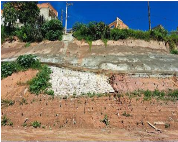
Rua Vitória do Vale - Solo Grampeado
