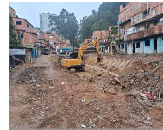
4 Limpeza e retirada de entulho do córrego – trecho 3
