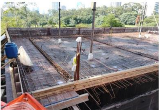
2 Forma e armação para laje de caixa perdido
