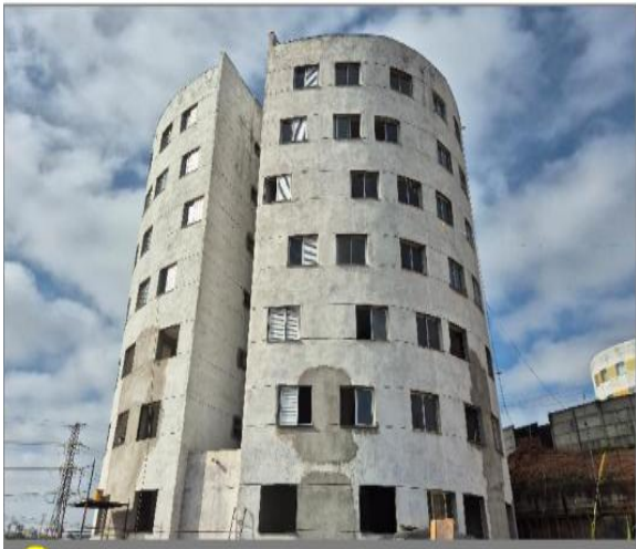
2 Vista da área dos Blocos 1e 2 - Cond. 4
