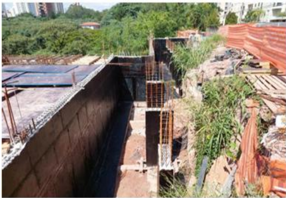
1 Execução de contenção e Pilares de caixa perdido
