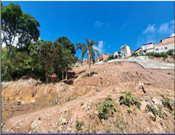
Rua Vitória do Vale - Solo Grampeado
