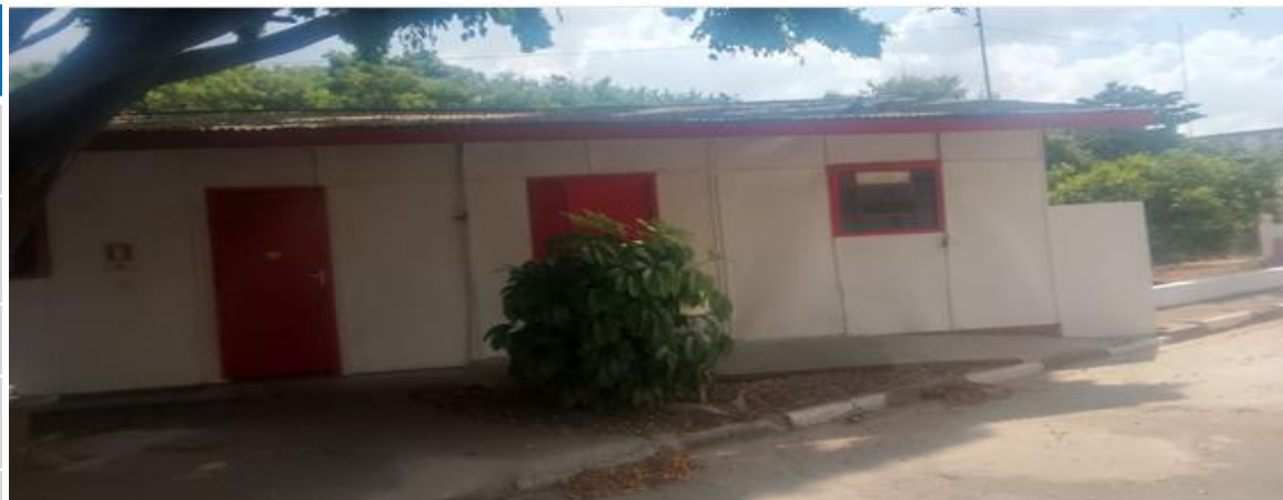
Sampaio Corrêa - manutenção do canteiro
