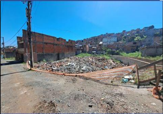
Rua Vitória do Vale - Demolições
