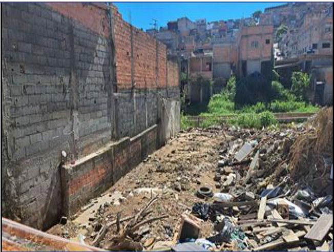
Rua Vitória do Vale - Demolições
