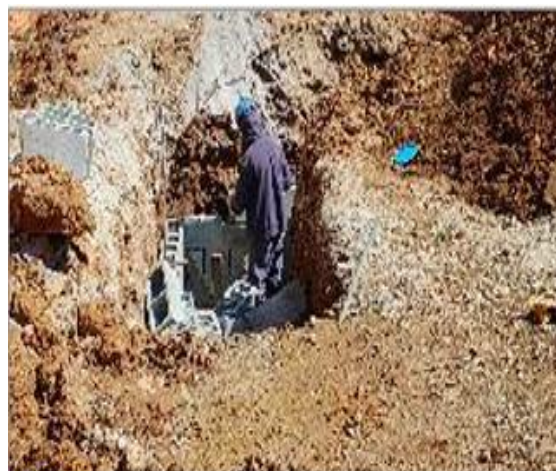
1 Fase 3 – Abertura de vala para drenagem
