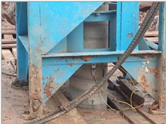
3 Condomínio J – Execução do ensaio dinâmico nas estacas
