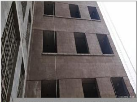
7 Condomínio L – Execução do revestimento externo
