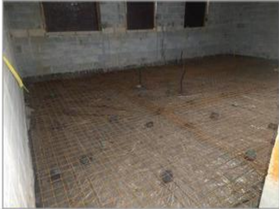
4 Condomínio L – Armação do piso do térreo
