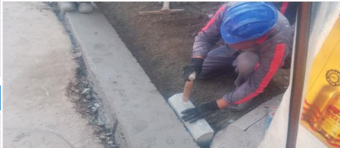
Sampaio Correa - Setor2 - Obras de infraestrutura
