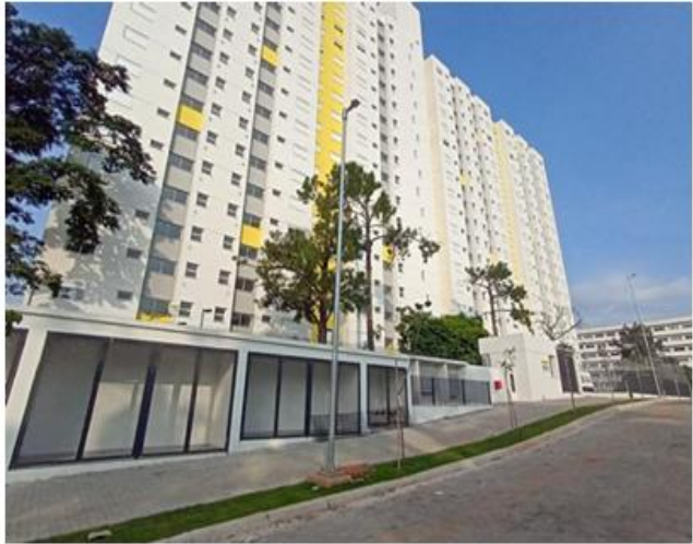
Área Externa - Finalização da instalação do gradil junto à Torre 5
