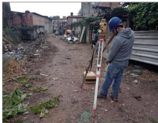
1 Topografia realizando levantamentos planialtimétricos – trecho 3
