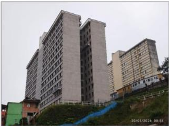
8 Condomínio L – Execução do revestimento externo
