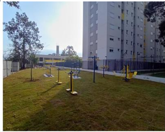
Área Externa - Plantio de gramas e instalação de equipamentos de academia ao ar livre
