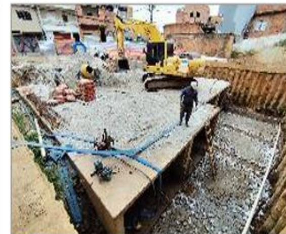
4 Fase 3 – Tanque de Retardo – Laje de Fundo
