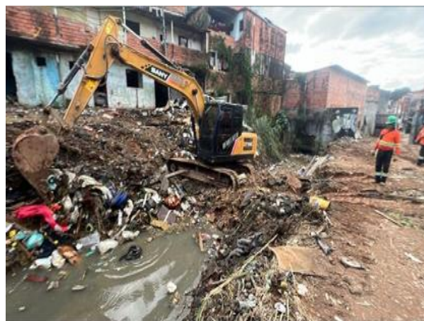
3 Limpeza e retirada de entulho do córrego – trecho 3
