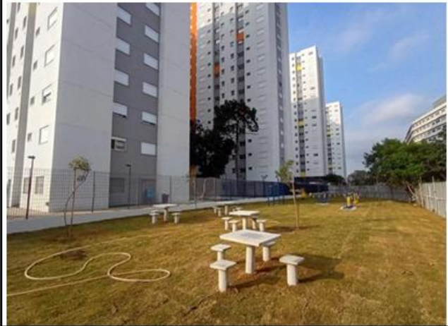
Área Externa - Plantio de grama e instalação de mesas e banco de concreto
