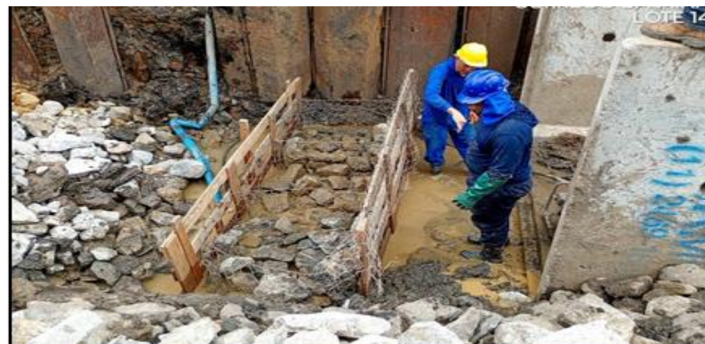
Execução do degrau do canal com gabião, ESTACA 2+9.
