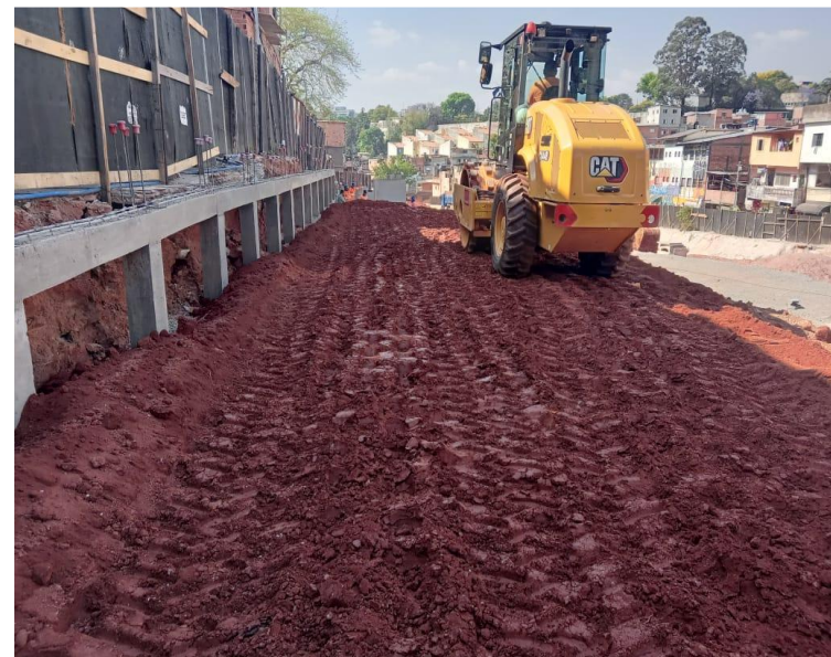
COMPACTAÇÃO DE TALUDE
