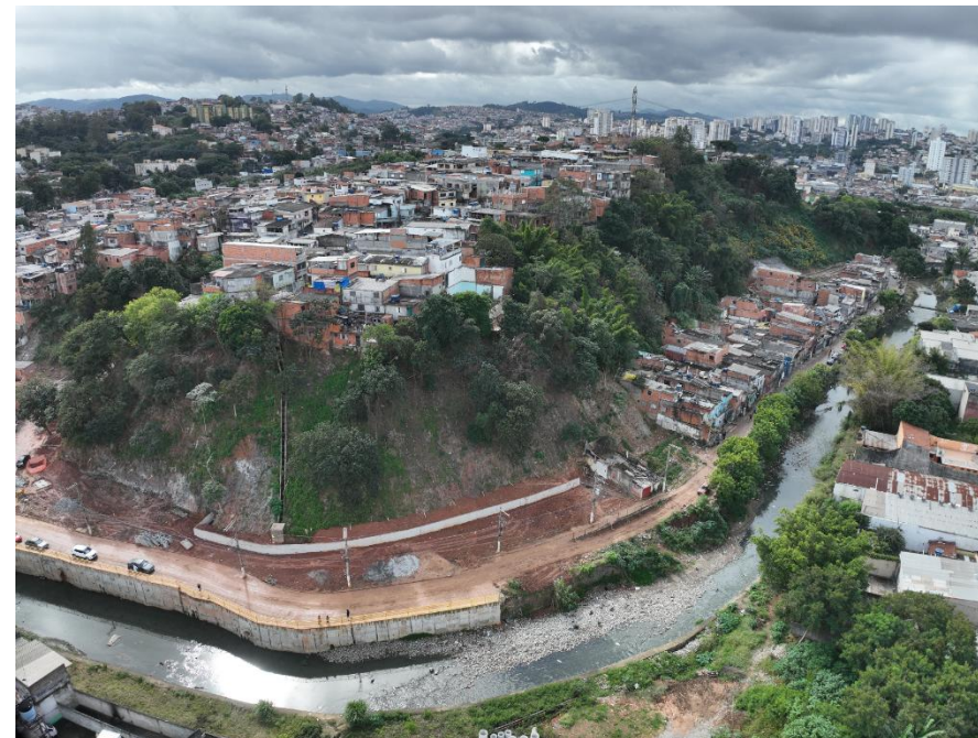
Contenção de encosta
