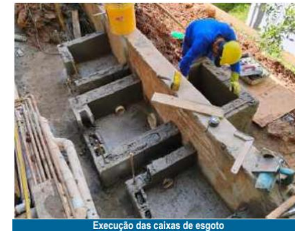
Execução das caixas de esgoto
