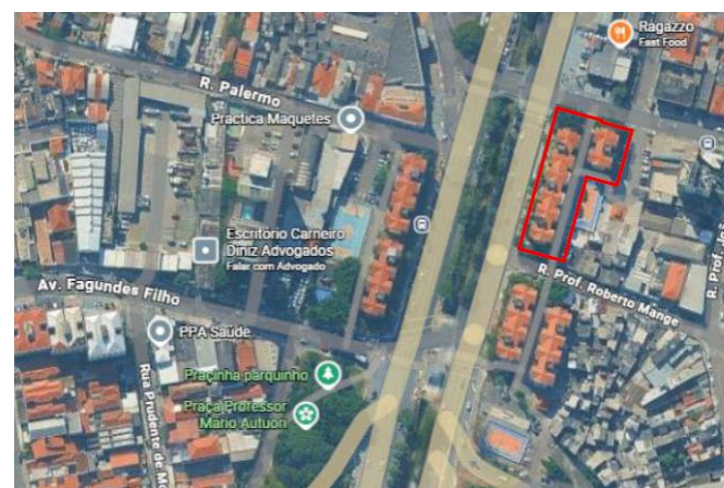
Figura 3 – Foto Aérea – Conjunto Habitacional Cingapura – Imigrantes
