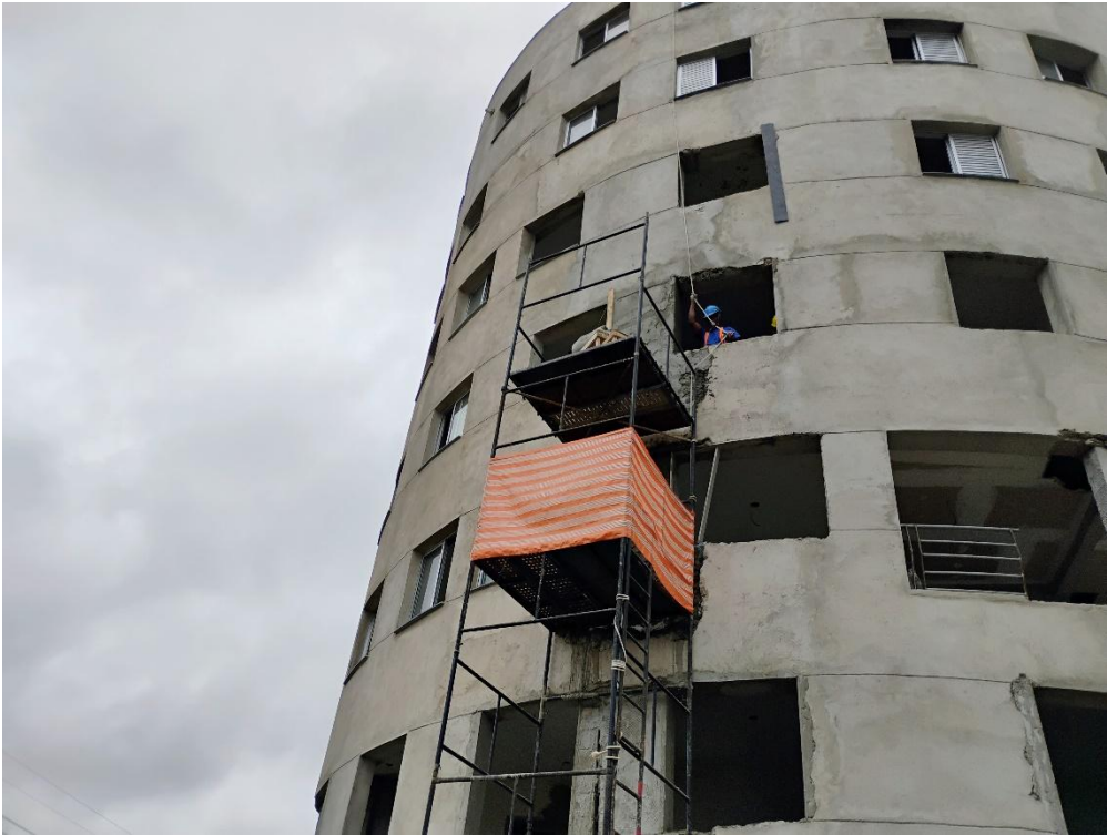
Foto: Setembro/25 – Revestimento da Fachada
