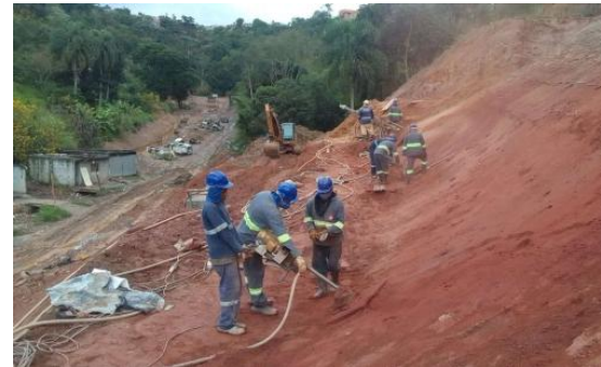
PERFURAÇÃO DO TALUDE
