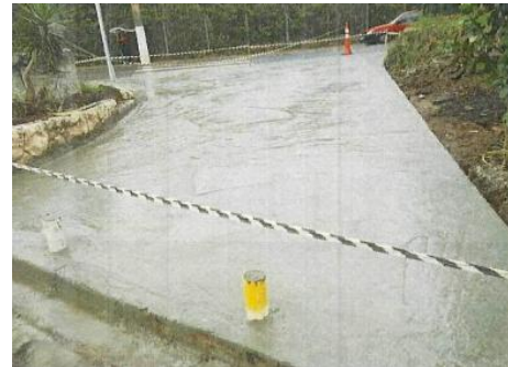
CONCRETO RECÉM-LANÇADO (CALÇADAS)
