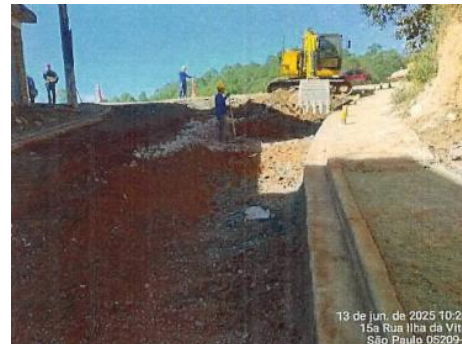
ABERTURA DE CAIXA PARA PAVIMENTAÇÃO
