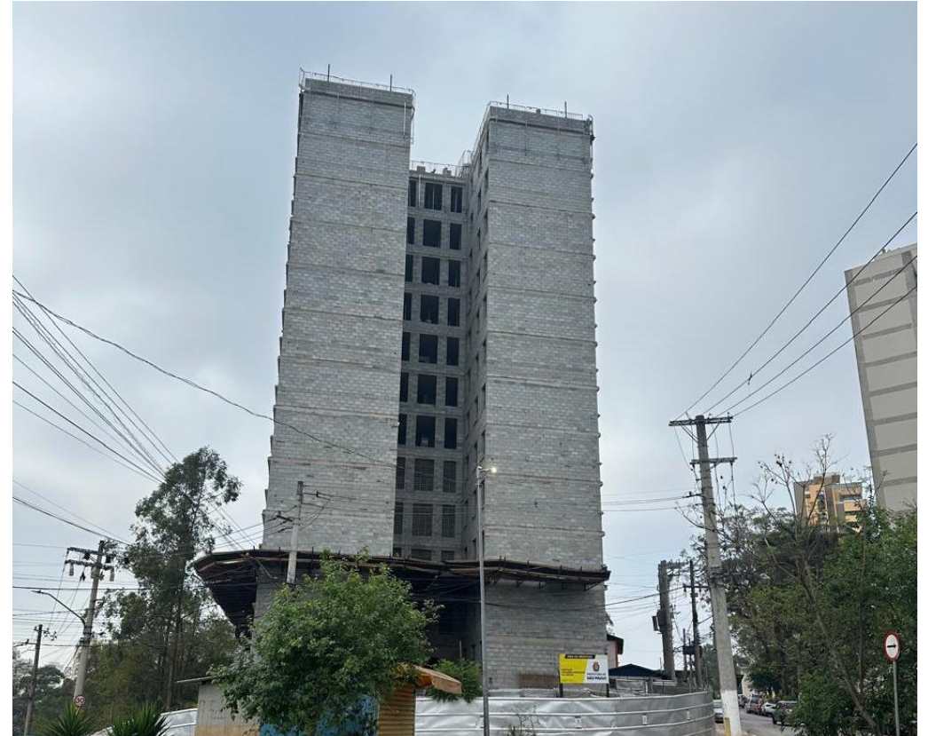
VISTA DO CONDOMÍNIO A
