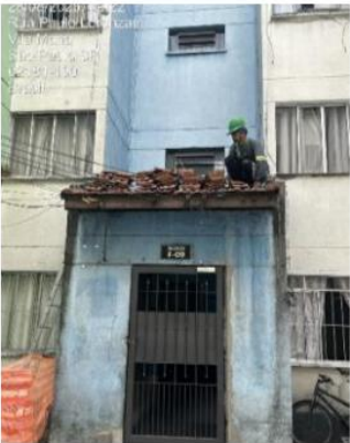
FOTO 09 -TELHADO E FACHADA HALL DE ENTRADA
