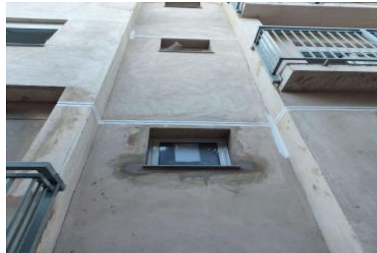
CONDOMÍNIO A - INSTALAÇÃO DE CAIXILHO
