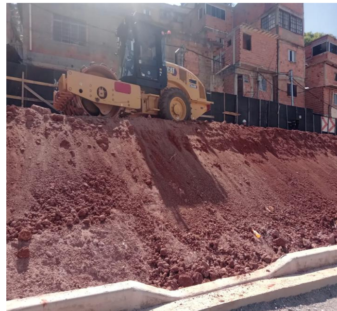
COMPACTAÇÃO DE TALUDE
