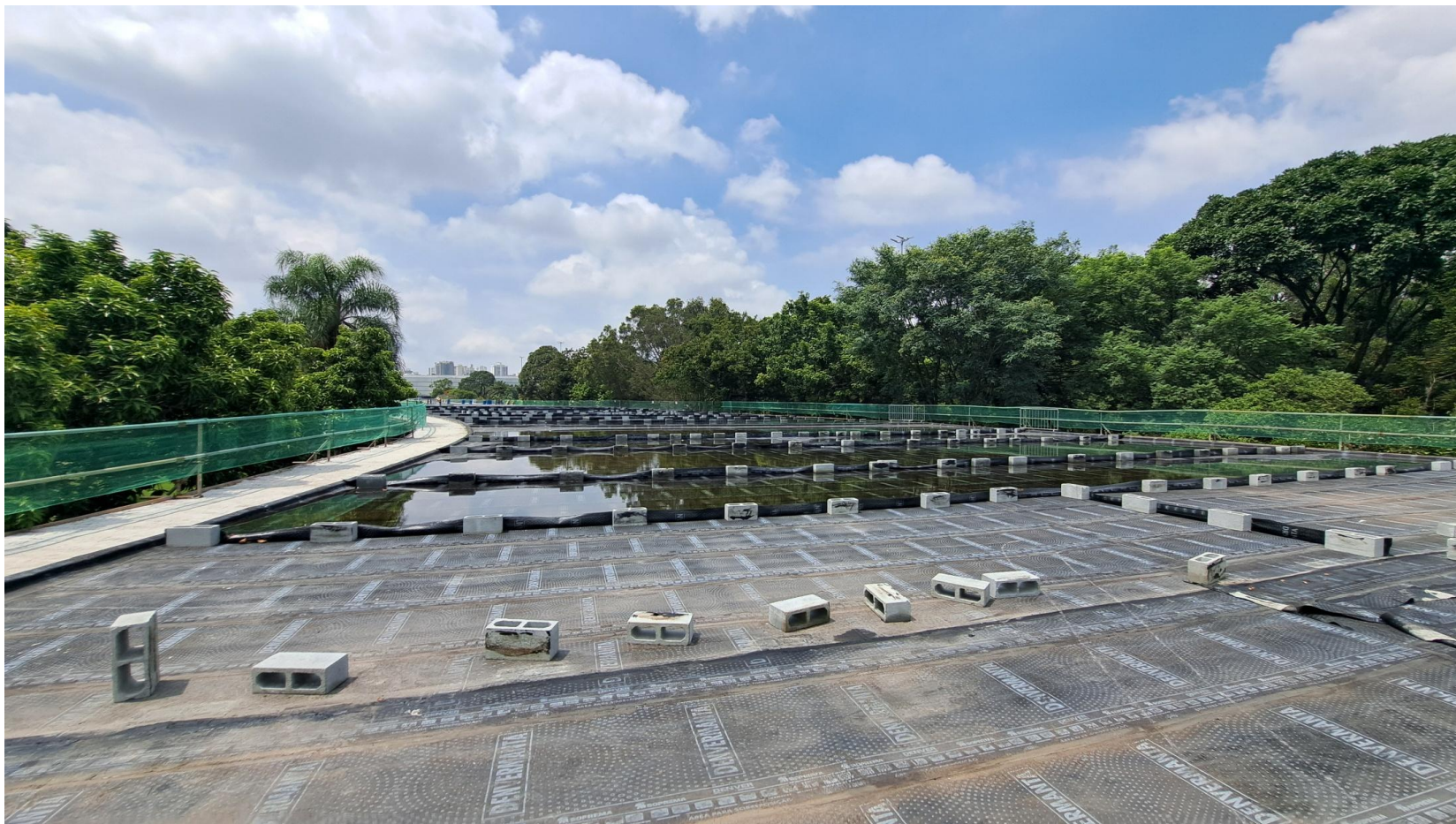
Teste de estanqueidade da impermeabilização – fevereiro/2025
