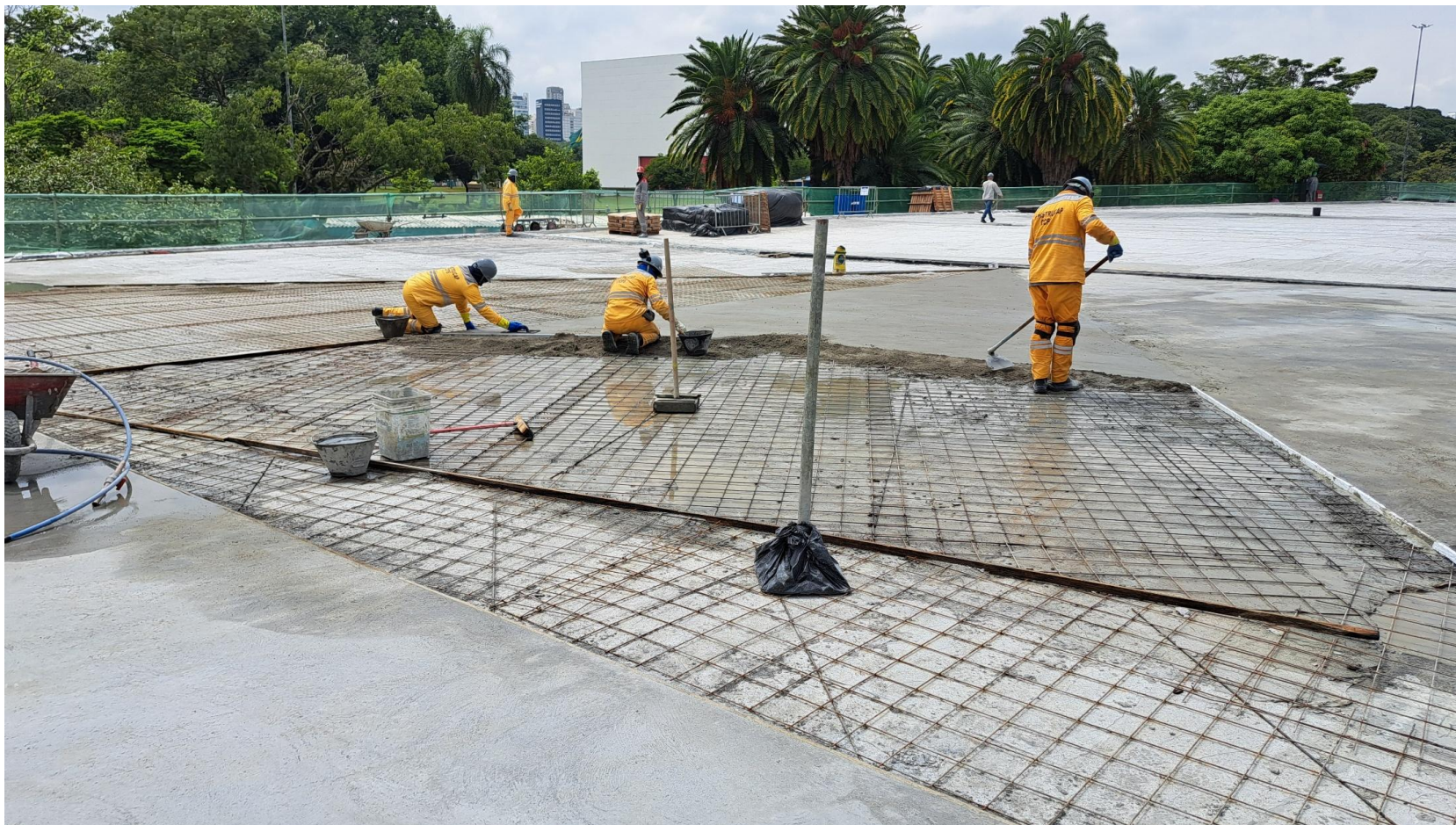
Execução proteção mecânica da impermeabilização – fevereiro/2025
