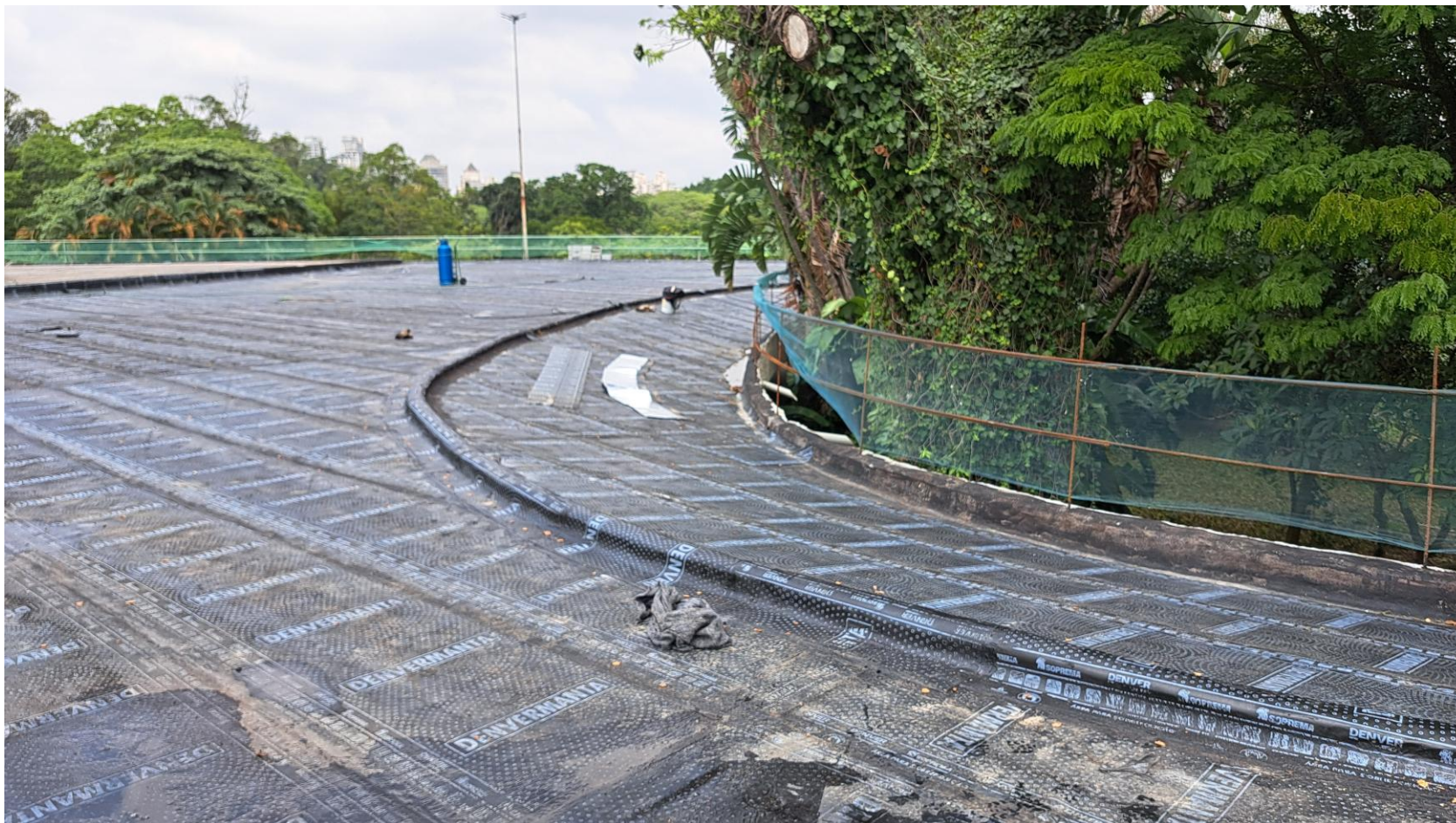
Aplicação manta asfáltica para impermeabilização – fevereiro/2025
