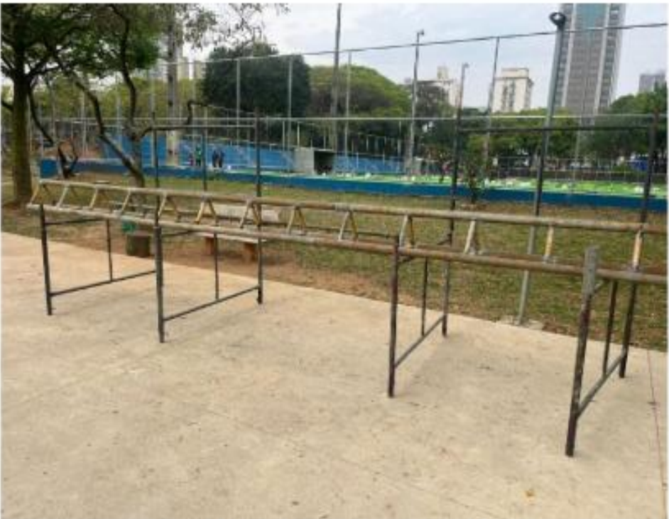
ESTRUTURA METÁLICA DE DIVISA
