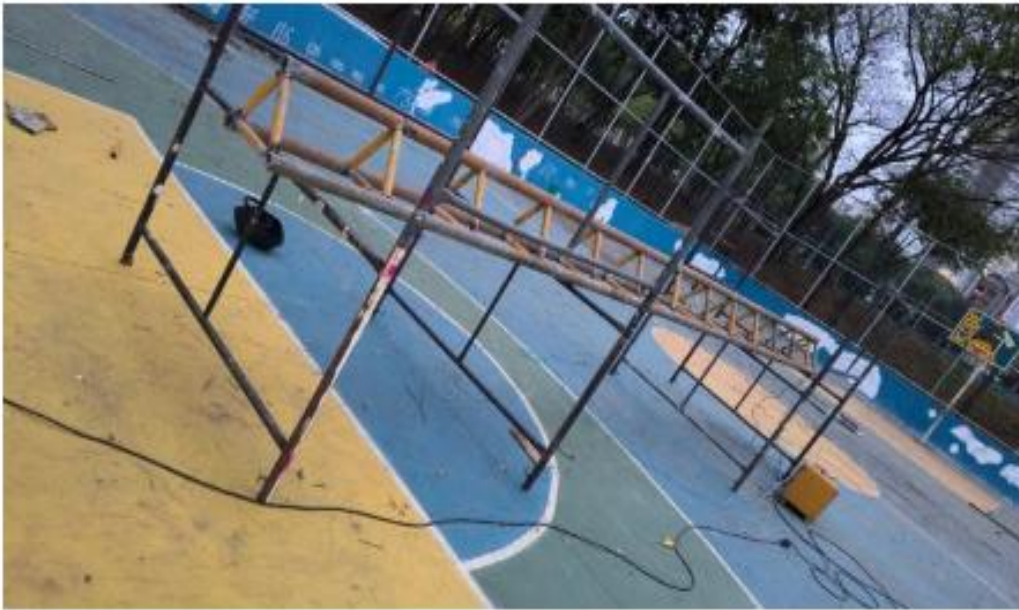
ESTRUTURA METÁLICA DE DIVISA
