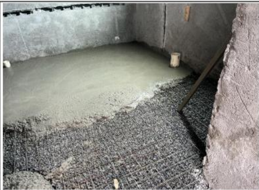
ADM - PISO DE CONCRETO - SALAS INTERNAS
