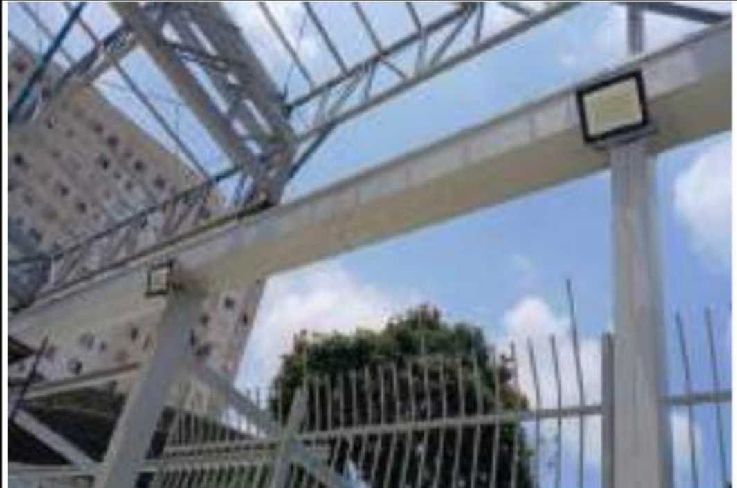
INSTALAÇÃO ELÉTRICA ILUMINAÇÃO
