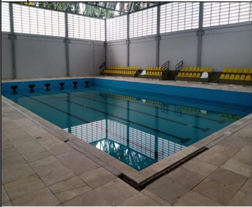
GINÁSIO PISCINA SEMI OLÍMPICA COM REVESTIMENTO DE PISO, RALO SECA PISO, PINTURA, ASSENTOS.
