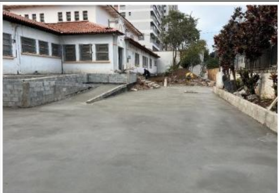
IMPLATAÇÃO - CONCRETO - ESPAÇO ATI / CALÇADA
