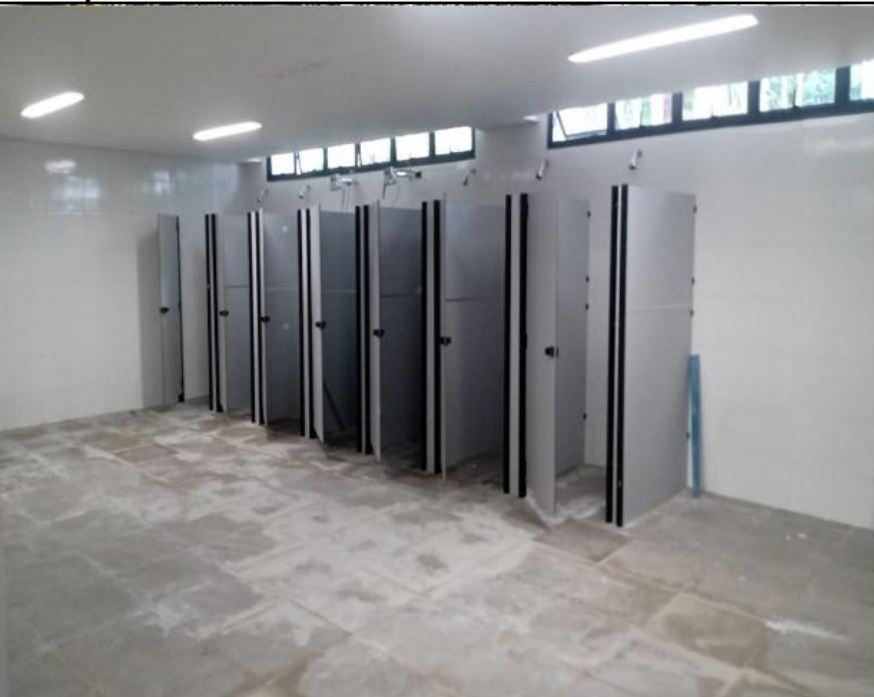
INSTALAÇÃO DE DIVISÓRIAS SANITÁRIAS.
