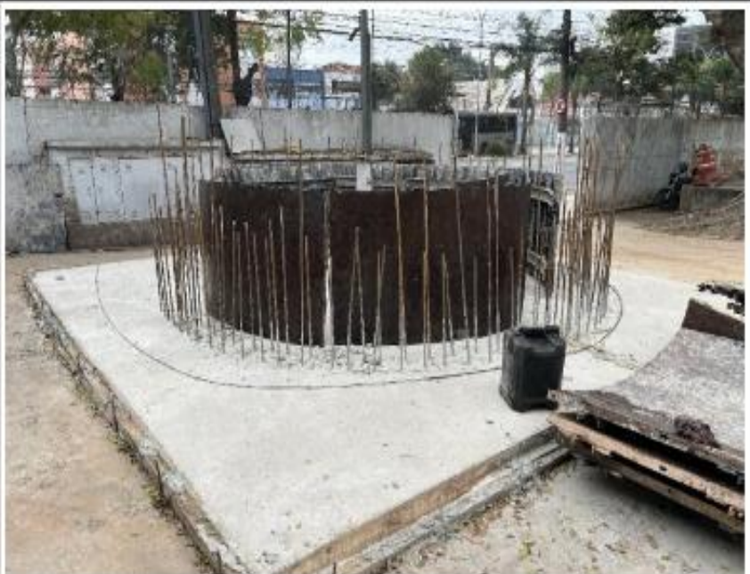
ADM - FUNDAÇÃO RESERVATÓRIO
