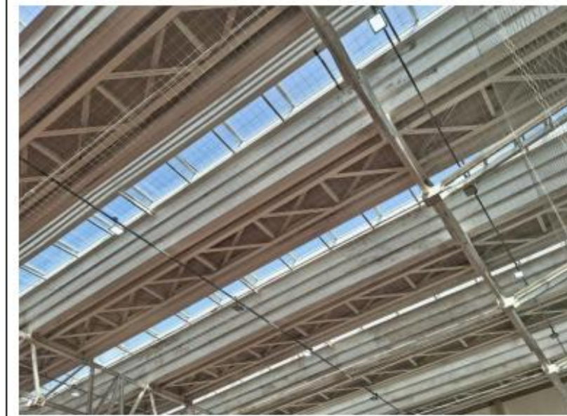
FOTO 11 – COBERTURA PRÉDIO ADMINISTRATIVO
