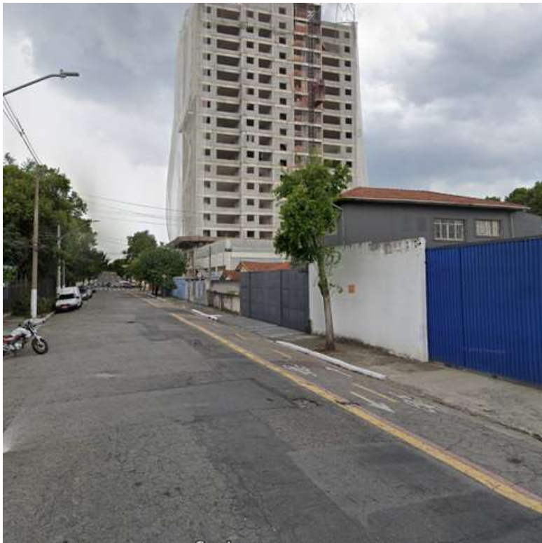
Antes da pavimentação
