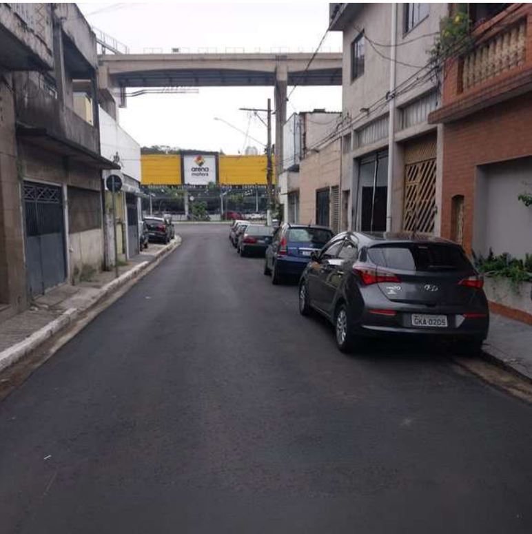
Depois da pavimentação
