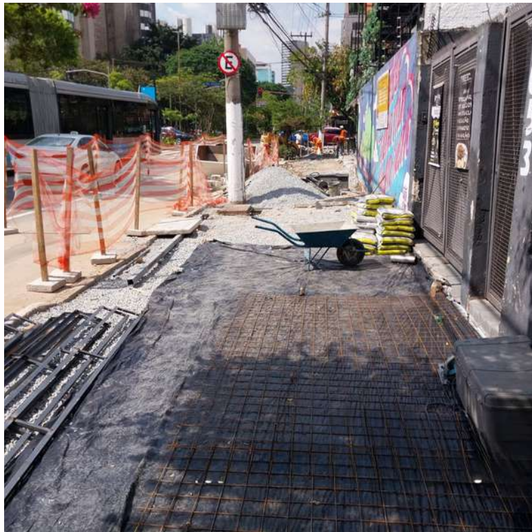
CALÇADA - Durante da requalificação
