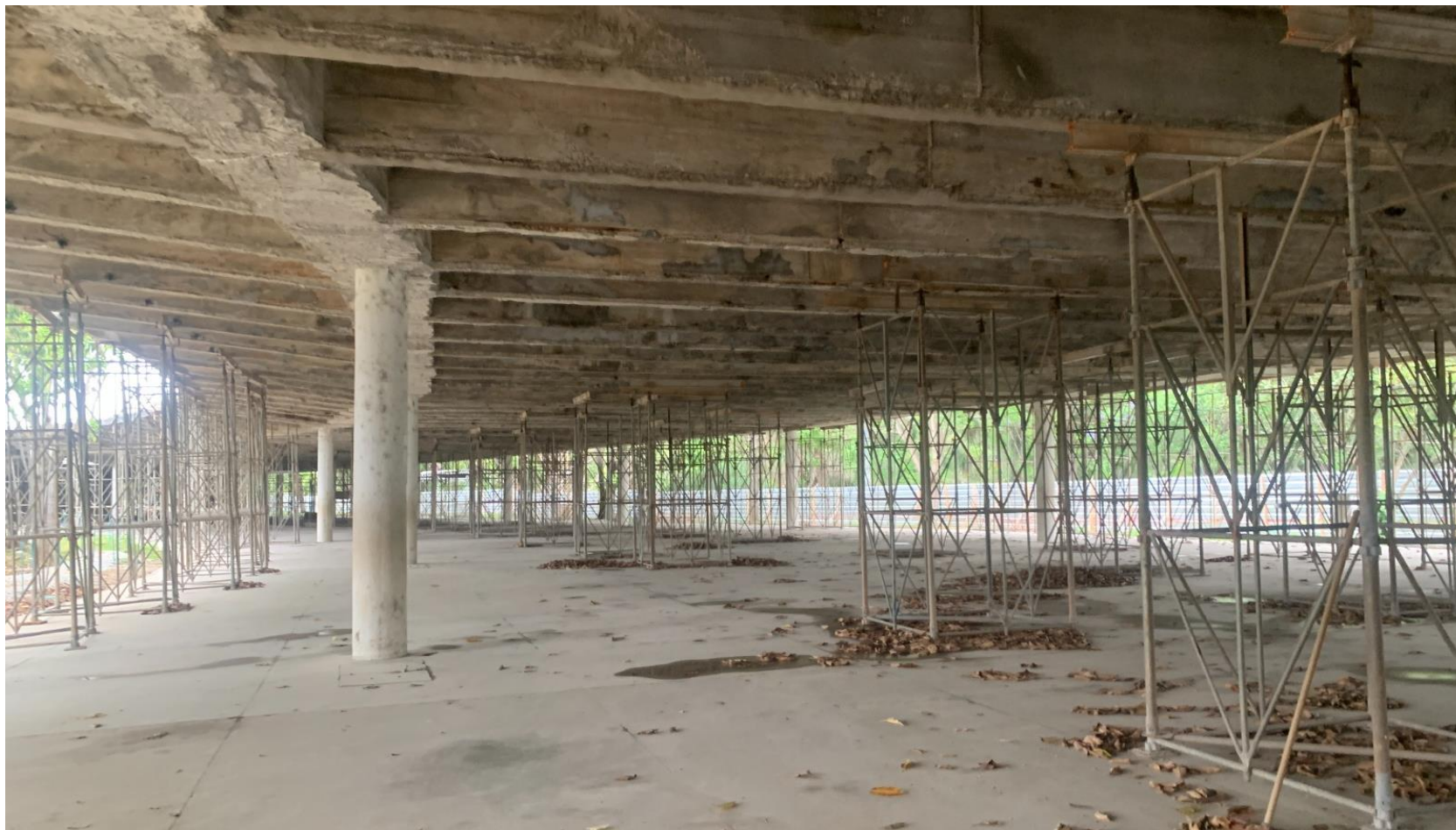
Cimbramento e Forro demolido – outubro/2024
