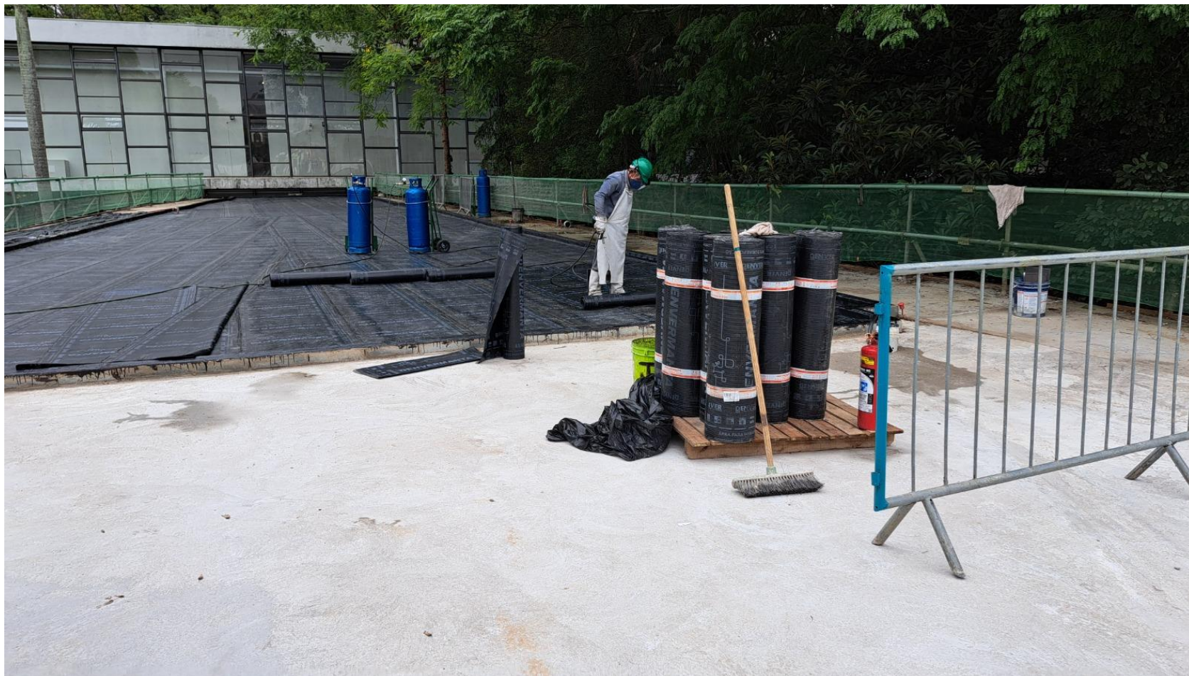
Aplicação de manta asfáltica (impermeabilização) – outubro/2024
