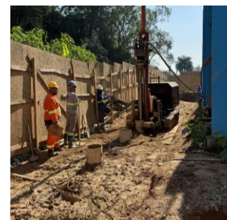
Redes de saneamento básico. Jararaú II. Ago./2024.
