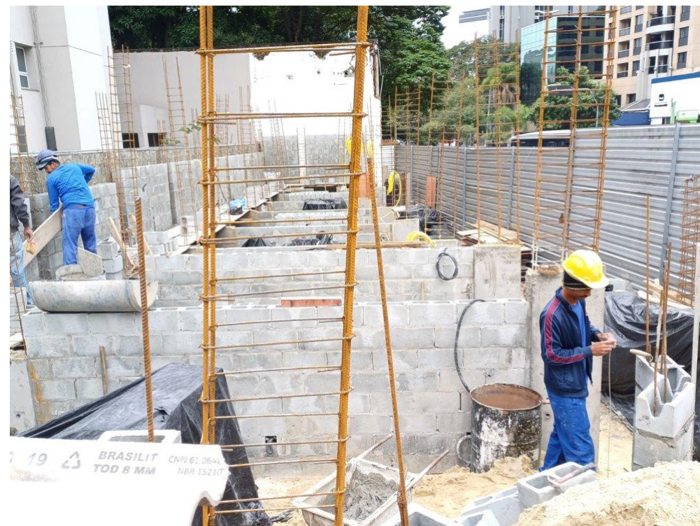
Execução de alvenaria dos Box ao lado dos prédios - Foto: agosto/24
