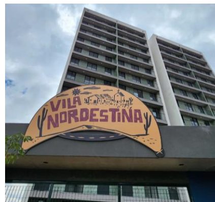
Execução da provisão – Vila Nordestina. Dez./2024
