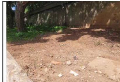
LIMPEZA COM RETIRADA DE ENTULHO
