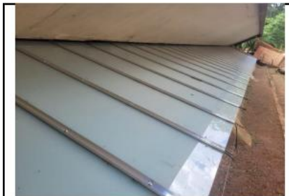
NOVOS VIDROS INSTALADOS
