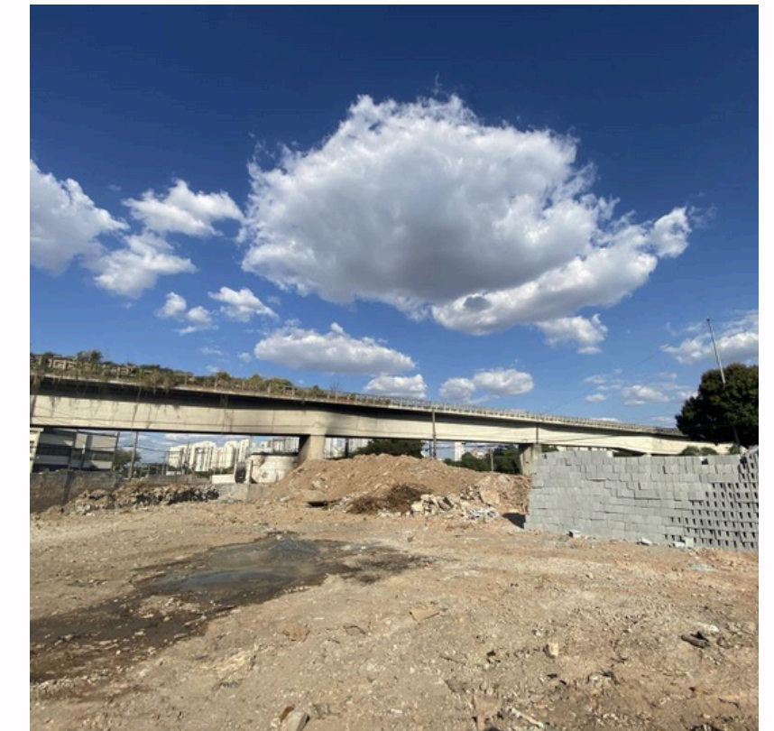
Foto em execução
