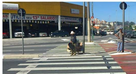
Canteiro Central muito estreito para acomodar pedestres
