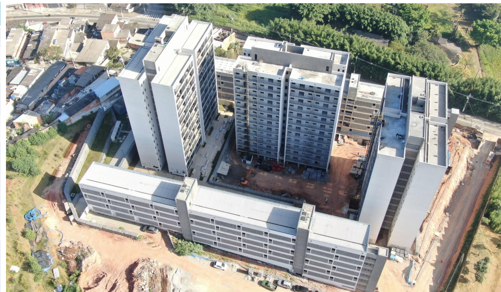
Execução da provisão – Maria de Barros Teixeira - Vila Nordestina. Abr./2026
